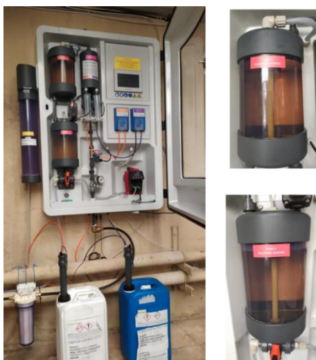
Εικόνα 13: Σύστημα απολύμανσης με διοξείδιο του χλωρίου στην Ιεράπετρα
