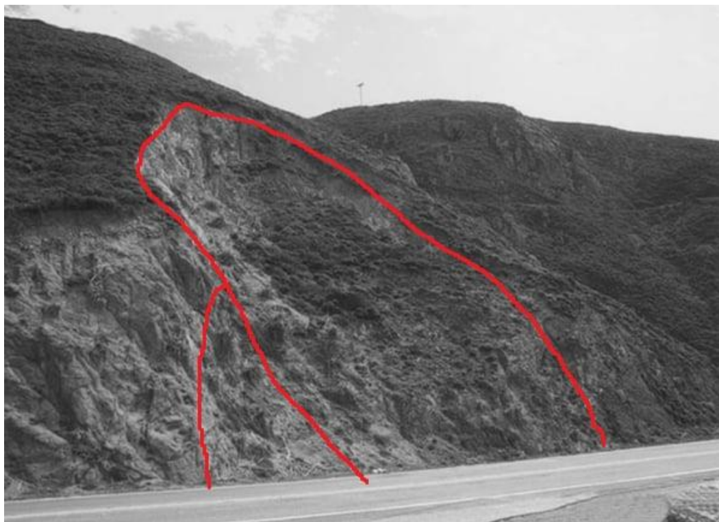
Σχήμα 3.2 Κυκλική αστοχία σε πολύ φθαρμένο, γρανιτικό βράχο (στον αυτοκινητόδρομο 1, κοντά στο Devil's Slide, Pacifica, Καλιφόρνια).
