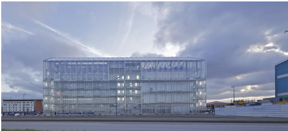
Εικόνα 46. Βόρεια όψη. Νέα κατασκευή με περίβλημα μεταλλικού σκελετού επενδεδυμένο με πάνελ ETFE.
