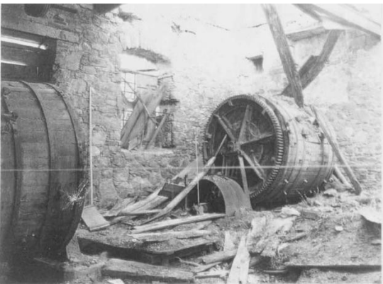
(Φωτ. 127) Μία από τις περιστρεφόμενες βαρέλες του βυρσοδεψείου Κορνηλάκη.
