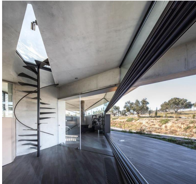
Εικόνα 83: Υπόσκαφη κατοικία στο Συκάμινο, όπου τα ανοίγματα έχουν σχεδιαστεί σε υποχώρηση και έχει δημιουργηθεί ένα στέγαστρο, το οποίο περιορίζει την ηλιακή ακτινοβολία που εισέρχεται στην κατοικία τις κρίσιμες ώρες.
