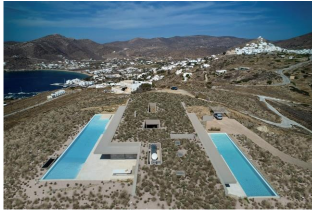
Εικόνα 22: Υπόσκαφη κατοικία στην Ίο με φυτεμένο δώμα και δύο πλευρές ανοιχτές.
