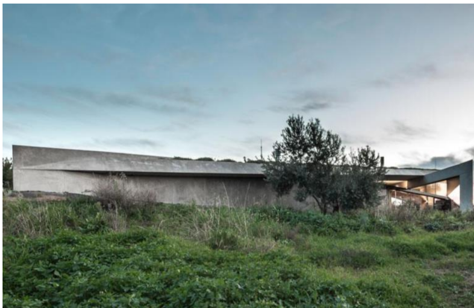
Εικόνα 72: Υπόσκαφη κατοικία στο Σικάμνο. Κέλυφος από οπλισμένο σκυρόδεμα.
