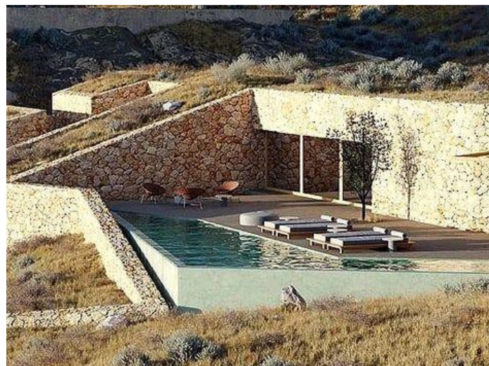
Εικόνα 74: Επένδυση κελύφους με πέτρα που συμβάλλει στην οπτική ενσωμάτωση της κατασκευής στο φυσικό τοπίο.
