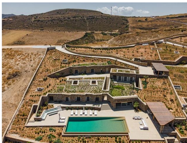
Εικόνα 20: Υπόσκαφο συγκρότημα στην Αντίπαρο, μερικώς βυθισμένο, με μια πλευρά ανοιχτή και φυτεμένο δώμα-συνέχεια του ανάγλυφου.
