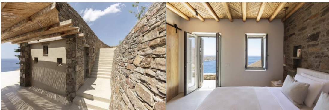
Εικόνα 86: Χρήση ξερολιθιάς και ξύλου εξωτερικά και εσωτερικά της υπόσκαφης κατοικίας.
