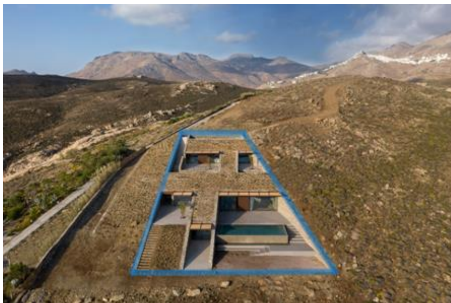
Εικόνα 91: Ncaved, Σέρφιος. Πρόσωση της υπόσκαφης κατοικίας στην οποία διακρίνεται το μικρό μήκος της όψης της, το φυτεμένο δώμα και το ορθογώνιο σχήμα της.
