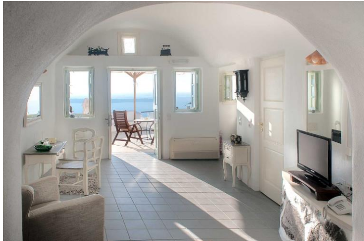
Εικόνα 79: Υπόσκαφη κατοικία στη Σαντορίνη. Άνοιγμα - φεγγίτης πάνω από την είσοδο στην πρόσοψη της κατοικίας. Εισέρχεται φυσικό φως και ενισχύεται η εισροή του αέρα εντός της κατοικίας.
