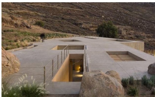
Εικόνα 18: Υπόσκαφη κατοικία στη Σέριφο με άνοιγμα-είσοδο από το επίπεδο του εδάφους κατεβαίνοντας επίπεδο.
