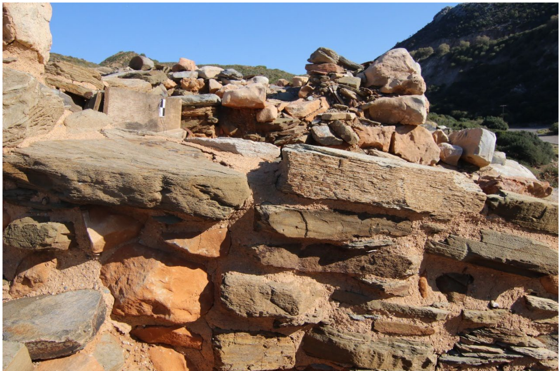
Λεπτομέρεια από τον ανατολικό τοίχο του χώρου 4. Σε δεύτερο πλάνο διακρίνεται και η πρόχειρη αντιστήριξη στον όμορο χώρο 3 λόγω απόκλισης από την κατακόρυφο του βόρειου τοίχου του. Ακόμη σε πρώτο πλάνο εντοπίζουμε και κονιάματα αποκατάστασης
