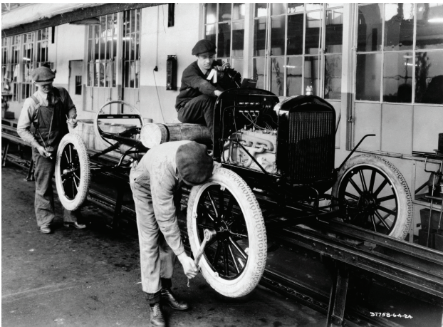
Εικ.7: Κινητή Γραμμή Συναρμολόγησης - Αυτοκινητοβιομηχανία Ford.
