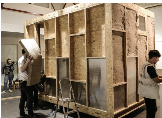
Εικ.42: Μόνωση των μονάδων- The Shed Project
