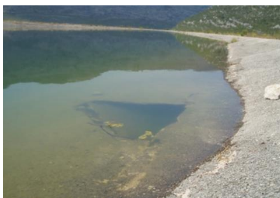
Εικόνα 4.12: Σπάσιμο τσιμέντου στον πυθμένα της λιμνοδεξαμενής ως αποτέλεσμα της υποχώρησης του εδάφους (Milanovic, 2014)
