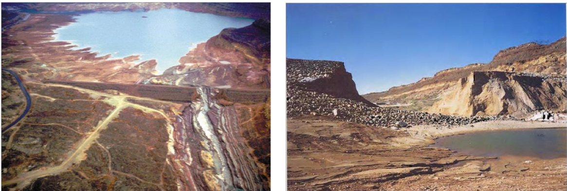
Εικόνα 4.7: Απεικόνιση της αστοχίας του αναχώματος στον ταμιευτήρα Quail Creek της Γιούτα των ΗΠΑ ( https://damfailures.org ).
