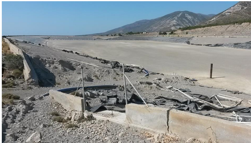
Εικόνα 4.17: Αστοχία επιχώματος στη λιμνοδεξαμενή της Χρυσοσκαλίτισσας (Στειακάκης, 2017).
