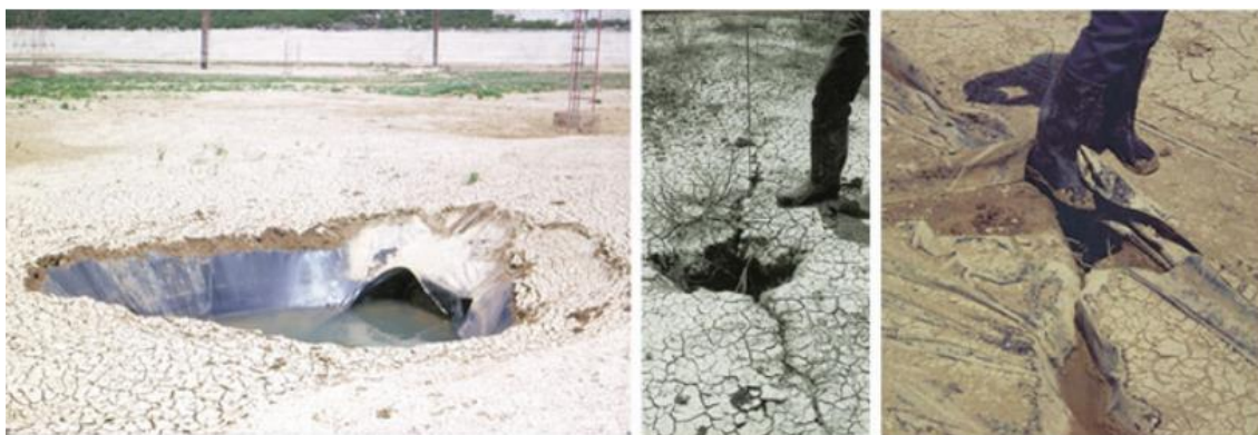
Εικόνα 4.11: Καταστροφή της γεωμεμβράνης μετά από φαινόμενα καθιζήσεων και δημιουργία ρωγμών στον πυθμένα της λιμνοδεξαμενής (Milanovic, 2014)
