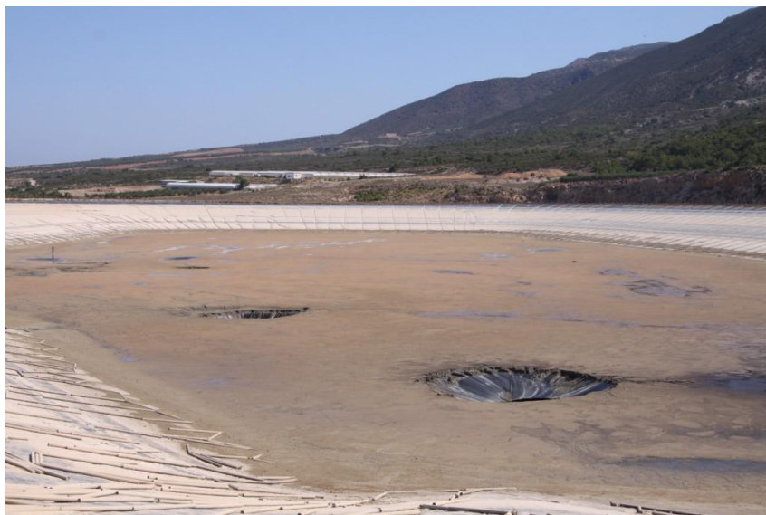
Εικόνα 4.18: Εικόνα από τον πυθμένα της εγκαταλειμμένης λιμνοδεξαμενής των Αγ. Θεοδώρων με εμφανή τα βυθίσματα που δημιουργήθηκαν λόγω αστοχίας της μεμβράνης και της εσωτερικής διάβρωσης (Στειακάκης, 2011) .
