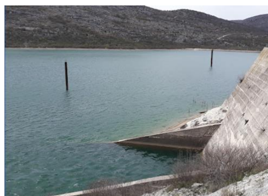
Εικόνα 4.13: Τοποθέτηση σωλήνων ως μέτρο πρόληψης για την εκκένωση του εγκλωβισμένου αέρα (Milanovic, 2014).
