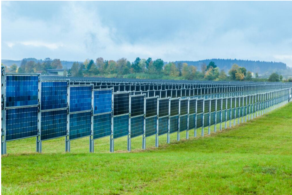
Εικόνα 7: Εγκατάσταση κάθετων φωτοβολταϊκών πλαισίων.
