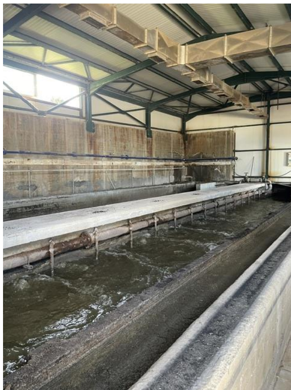
Εικόνα 34: Κανάλι άντλησης αστικού λύματος.
