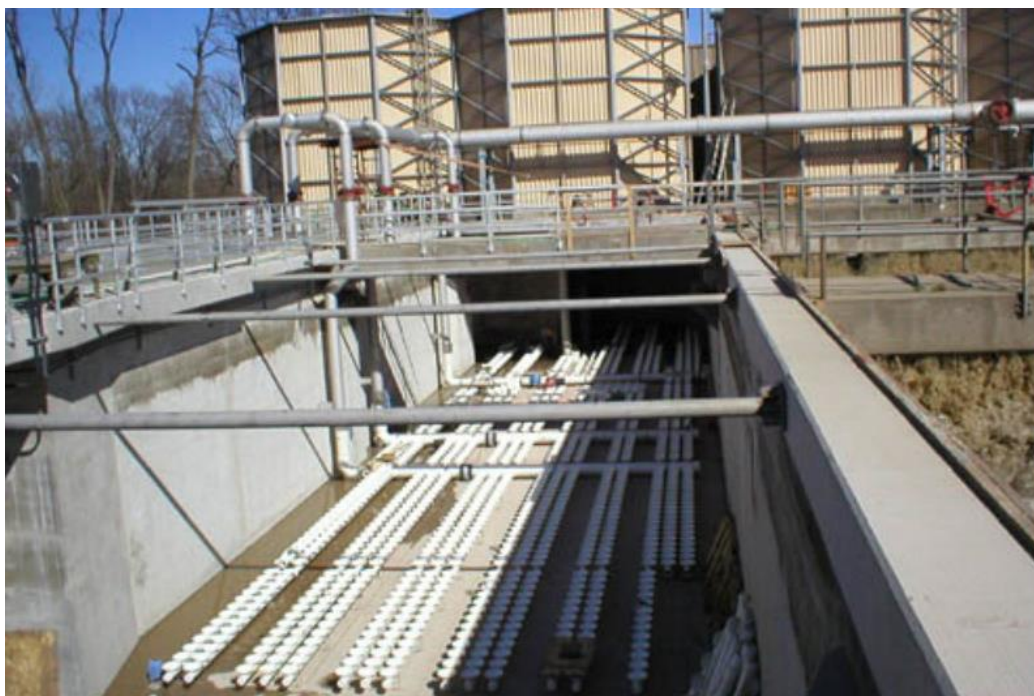
Εικόνα 6: Μονάδα αερισμού εμβολικής ροής με διαχυτήρες(Γκίκας,2020)
