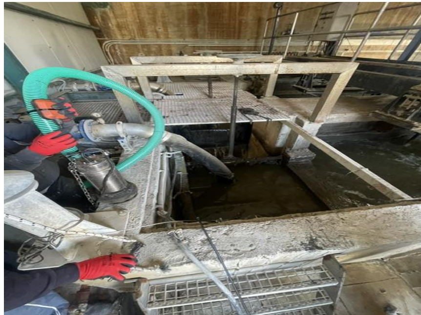
Εικόνα 33: Τοποθέτηση φυγόκεντρης αντλίας στο κανάλι προεπεξεργασίας
