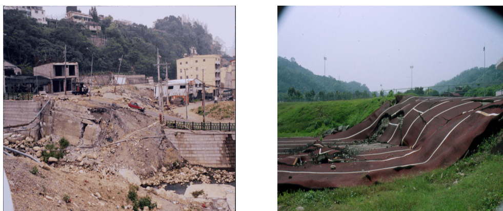
Εικόνα 2.17: Παραμόρφωση εδάφους - Σεισμός Chi-Chi Ταιβάν, (Tectonics Observatory (2024))
