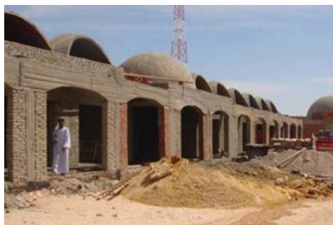
89. Ανέγερση κτιρίου με θόλους κάνοντας χρήση οπλισμένου σκυροδέματος στον
