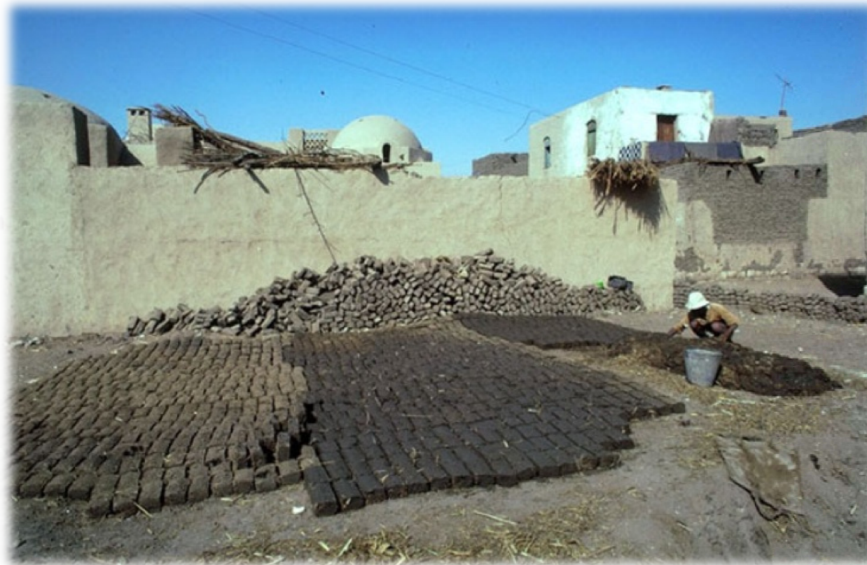
63. Κατασκευή ωμόπλινθων στον οικισμό New Gournah το 1980 Α
