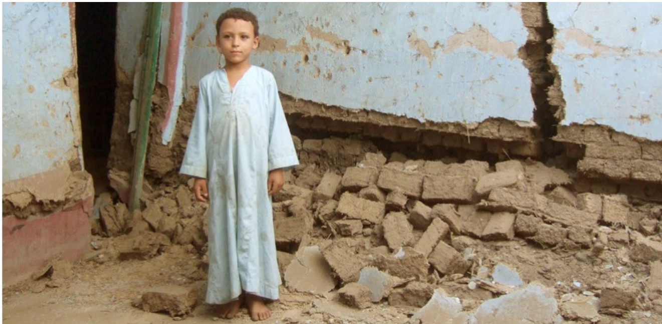
75. Παθογένειες σε θεμέλια κτιρίου στον οικισμό New Gournu λόγω ανοδικής υγρασίας.
