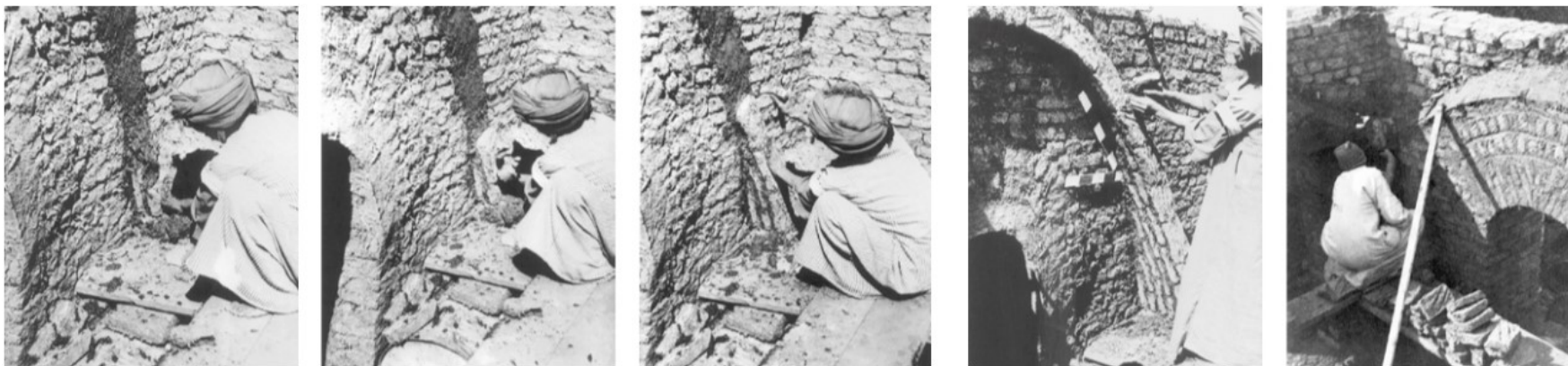
67. Η Διαδικασία κατασκευής του ημικυλινδρικού θόλου βάσει της νοβίας τεχνικής χωρίς χρήση κατασκευής υποστήριξης.
