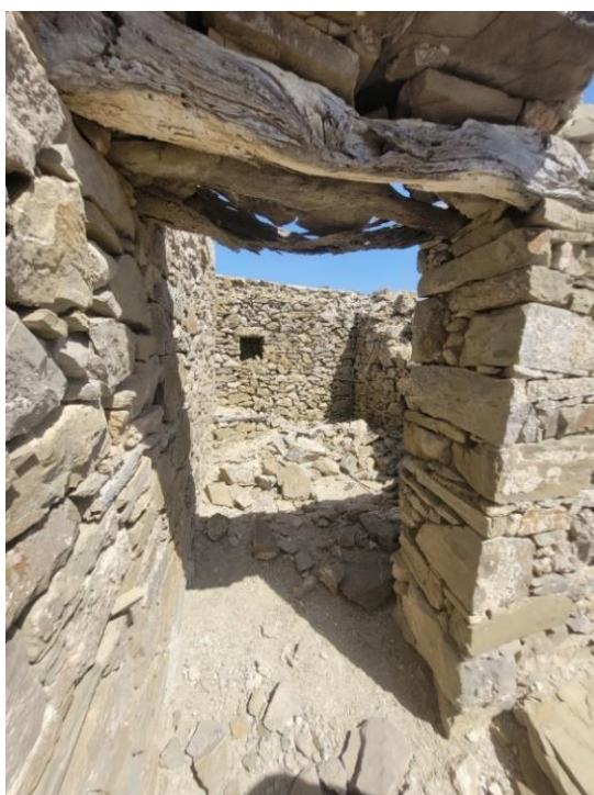
Εικόνα 65, 66: Λαξευμένοι λίθοι σε γωνία τοιχοποιίας σε στάβλο έξω από το χωριό Πυλές, Μπατική τοιχοποιία σε στάβλο στην περιοχή Αφιάρτης (Μενετές).
