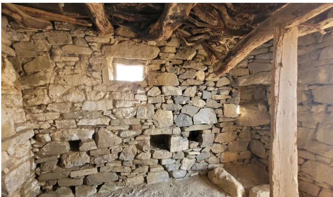
Εικόνα 64: Μπατική τοιχοποιία σε στάβλο στην περιοχή Συκέλαος (Πυλές).
