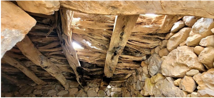
Εικόνα 68: Δώμα με τράβες και σκιάκια στάβλου στον αγροτικό οικισμό Κοίλιος στο Τρίστομο.
