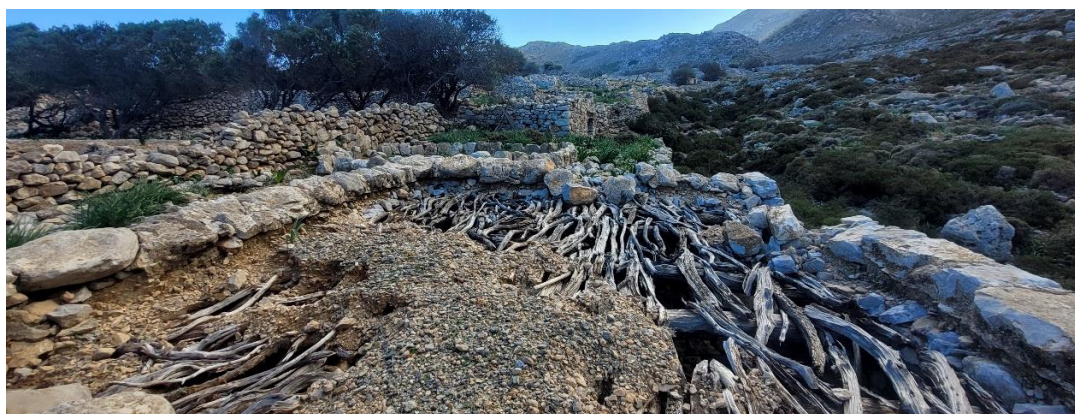
Εικόνα 74: Δώμα με τράβες και σκιάκια στάβλου στον αγροτικό οικισμό Κοίλιος στο Τρίστομο
