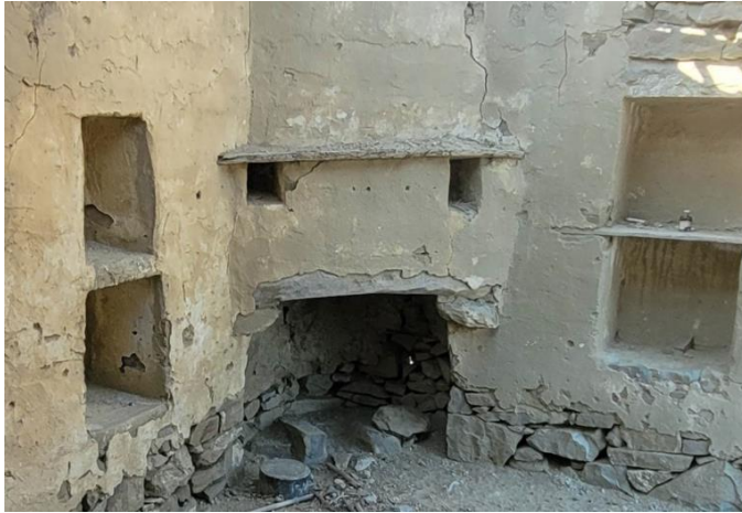
Εικόνα 75: Στάβλος με ορθογώνιο άνοιγμα τζακιού και εσωτερική ανακαπνέα και στάβλος με ημικυκλικό άνοιγμα τζακιού, έξω από το χωριό Πυλές.
