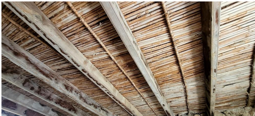
Εικόνα 70: Δώμα με κατράνια και καλάμια στάβλου στο χωριό της Αρκάσας.
