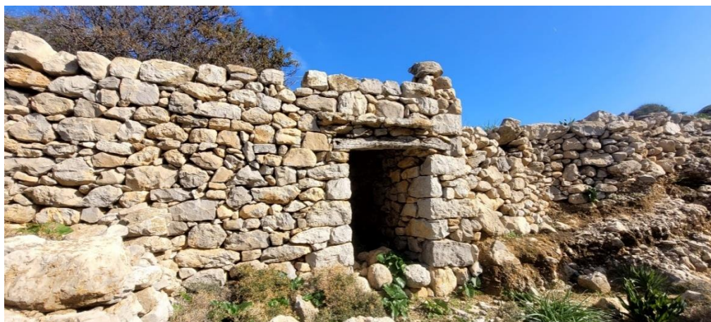
Εικόνα 81: Στάβλος με ξύλινο πρέκι θύρας στον αγροτικό οικισμό Κοίλιος στο Τρίστομο.
