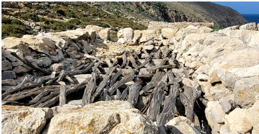
Εικόνα 69: Δώμα με τράβες και σκιάκια στάβλου στον αγροτικό οικισμό Κοίλιος στο Τρίστομο.
