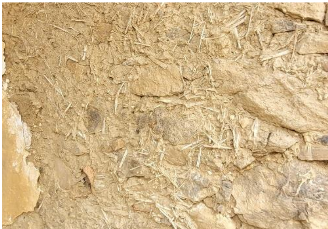
Εικόνα 67: Τμήμα επιχρισμένης τοιχοποιίας στάβλου, με πηλόχωμα και άχυρα, στην περιοχή Εξήλες (Μενετές).
