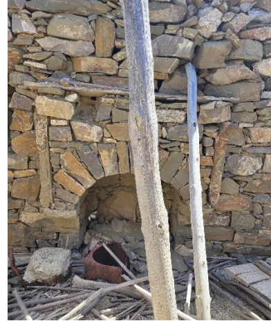
Εικόνα 75: Στάβλος με ορθογώνιο άνοιγμα τζακιού και εσωτερική ανακαπνέα και στάβλος με ημικυκλικό άνοιγμα τζακιού, έξω από το χωριό Πυλές.
