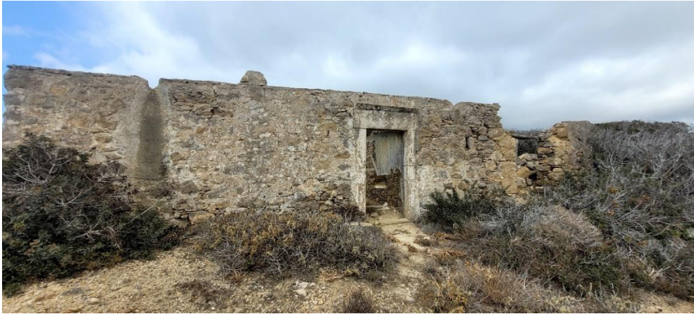
Εικόνα 79: Στάβλος με πρέκι θύρας από πωρόλιθο, στην περιοχή Εξήλες (Μενετές).
