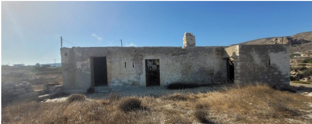
Εικόνα 80: Στάβλος με πρέκι θύρας από πωρόλιθο, στην περιοχή Αφιάρτης (Μενετές).
