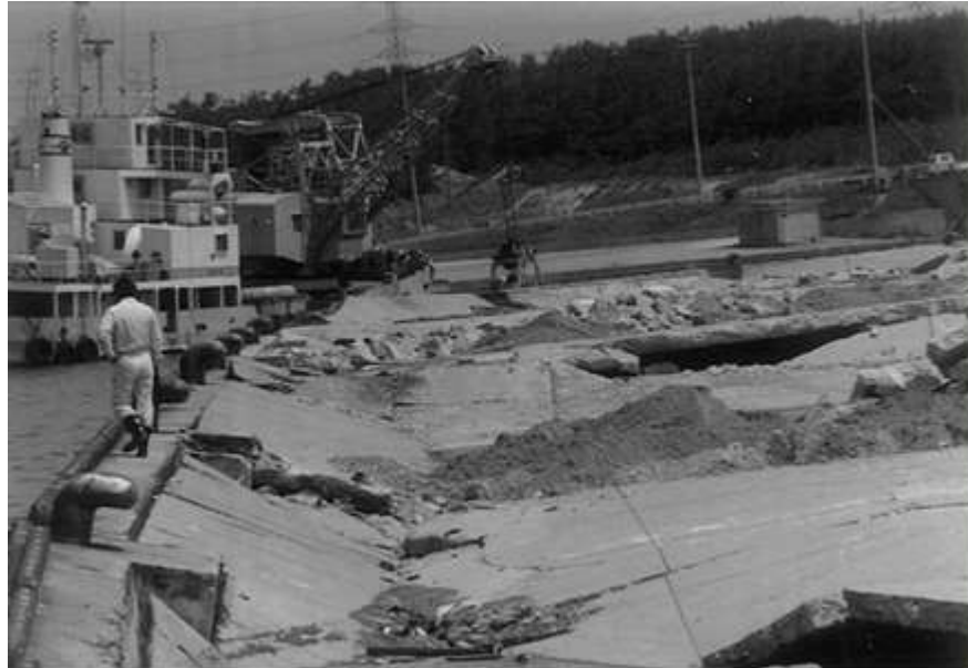
Εικόνα 2.23: Λιμενικές καταστροφές από το σεισμό Nihokai-Chubu (PIANC, 2001)
