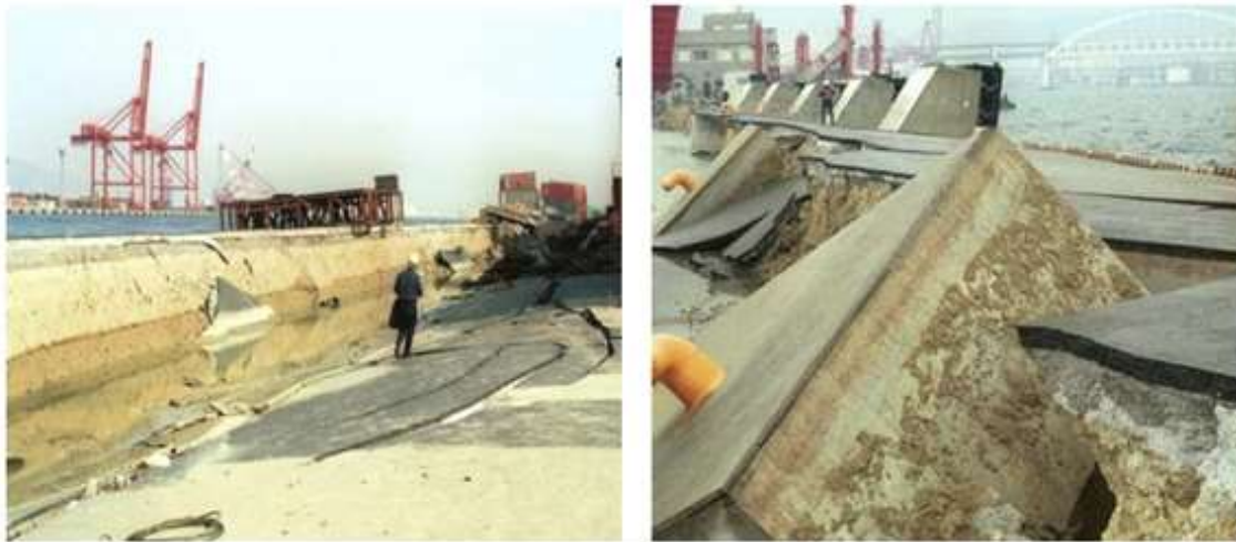
Εικόνα 2.20: Καταστροφές λιμενικών κατασκευών από τον σεισμό Kobe
