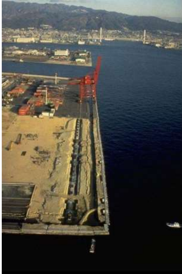
Εικόνα 2.25: Αστοχία κρηπιδότοιχων στο λιμάνι του Akita
