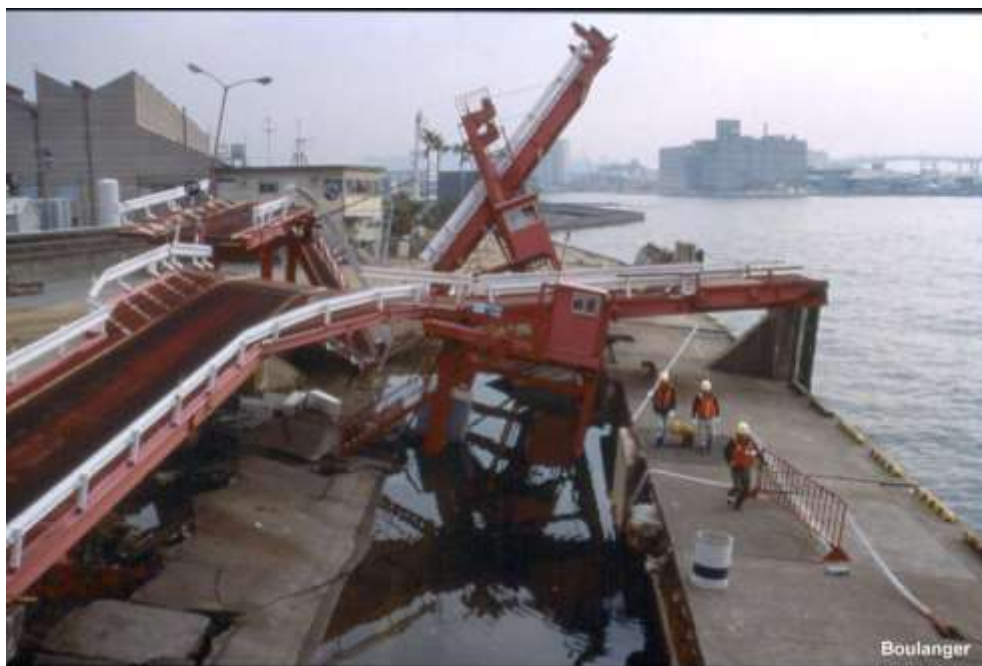
Εικόνα 2.21: Καταστροφές του λιμανιού του Kobe λόγω ρευστοποίησης (1995)
