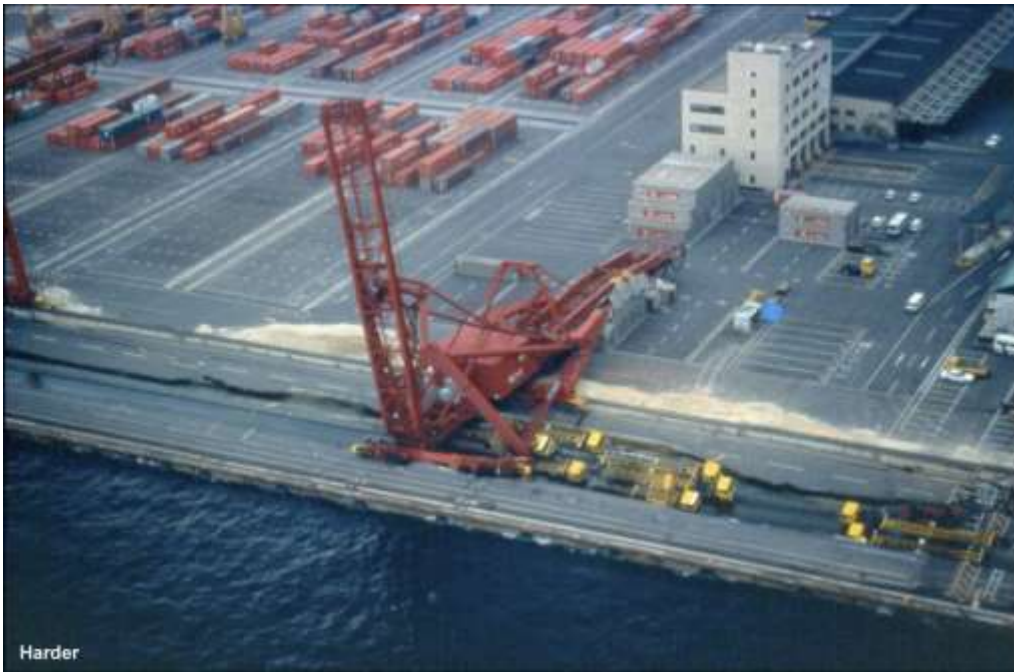
Εικόνα 2.22: Αστοχία πασσαλότοιχων στις προβλήτες του λιμανιού του Kobe (1995)
