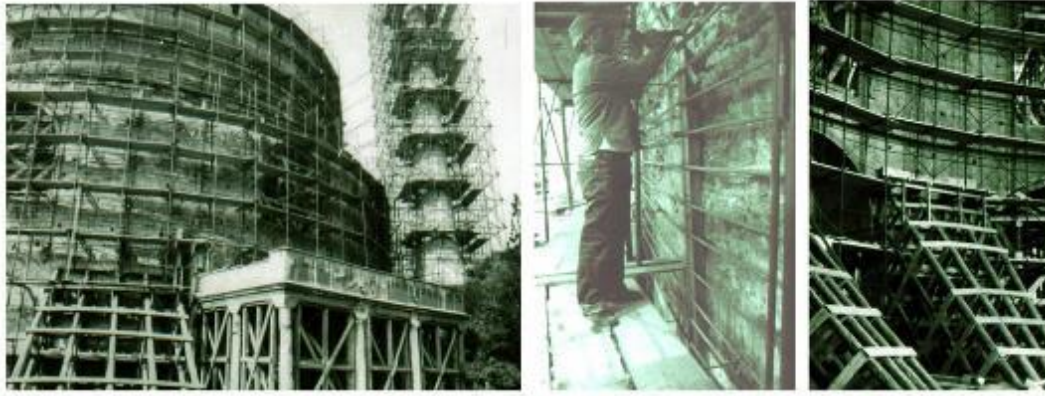
Εικόνα 37 Προσωρινή υποστήλωση Ροτόντας και εργασίες αποκατάστασης
