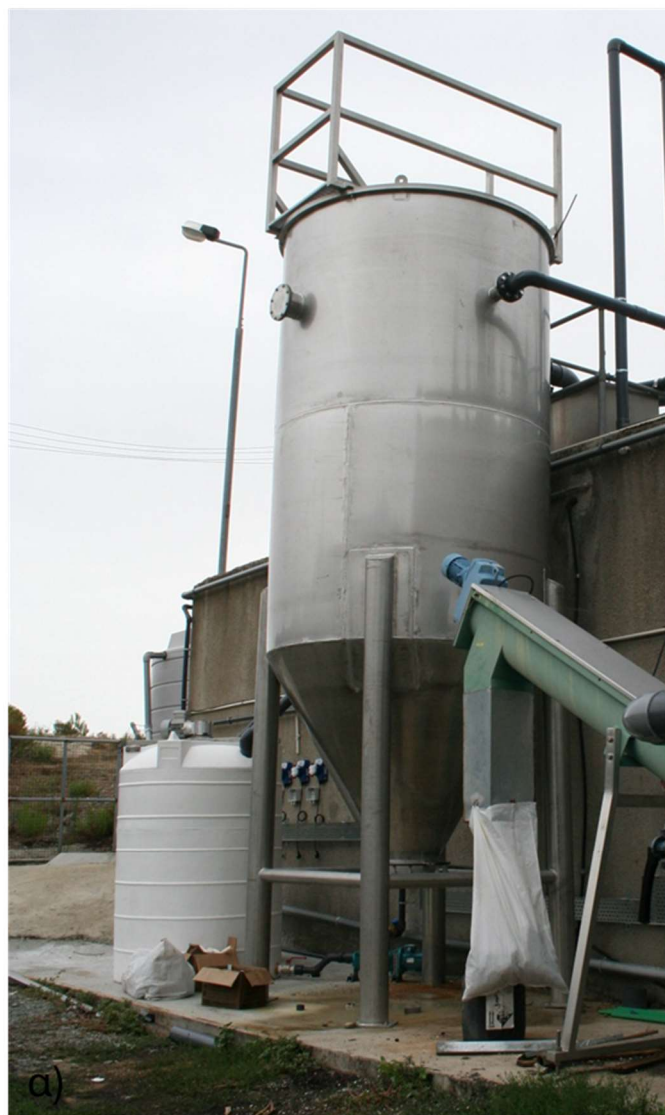
Σχήμα 5.13: α) Φωτογραφία του αμμόφιλτρου στην ΕΕΛ Κυπερούντας β) σχηματική απεικόνιση του αμμόφιλτρου κατά τον σχεδιασμό.
