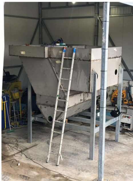
Σχήμα 5.9: Φωτογραφίες κατά την κατασκευή της δεξαμενής καθίζησης με λαμέλλες.
