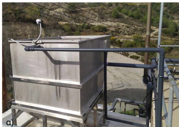
Σχήμα 5.14: Φωτογραφία της δεξαμενής καθίζησης με λαμέλλες στην ΕΕΛ Κυπερούντας β) σχηματική απεικόνιση δεξαμενής καθίζησης με λαμέλλες κατά τον σχεδιασμό.
