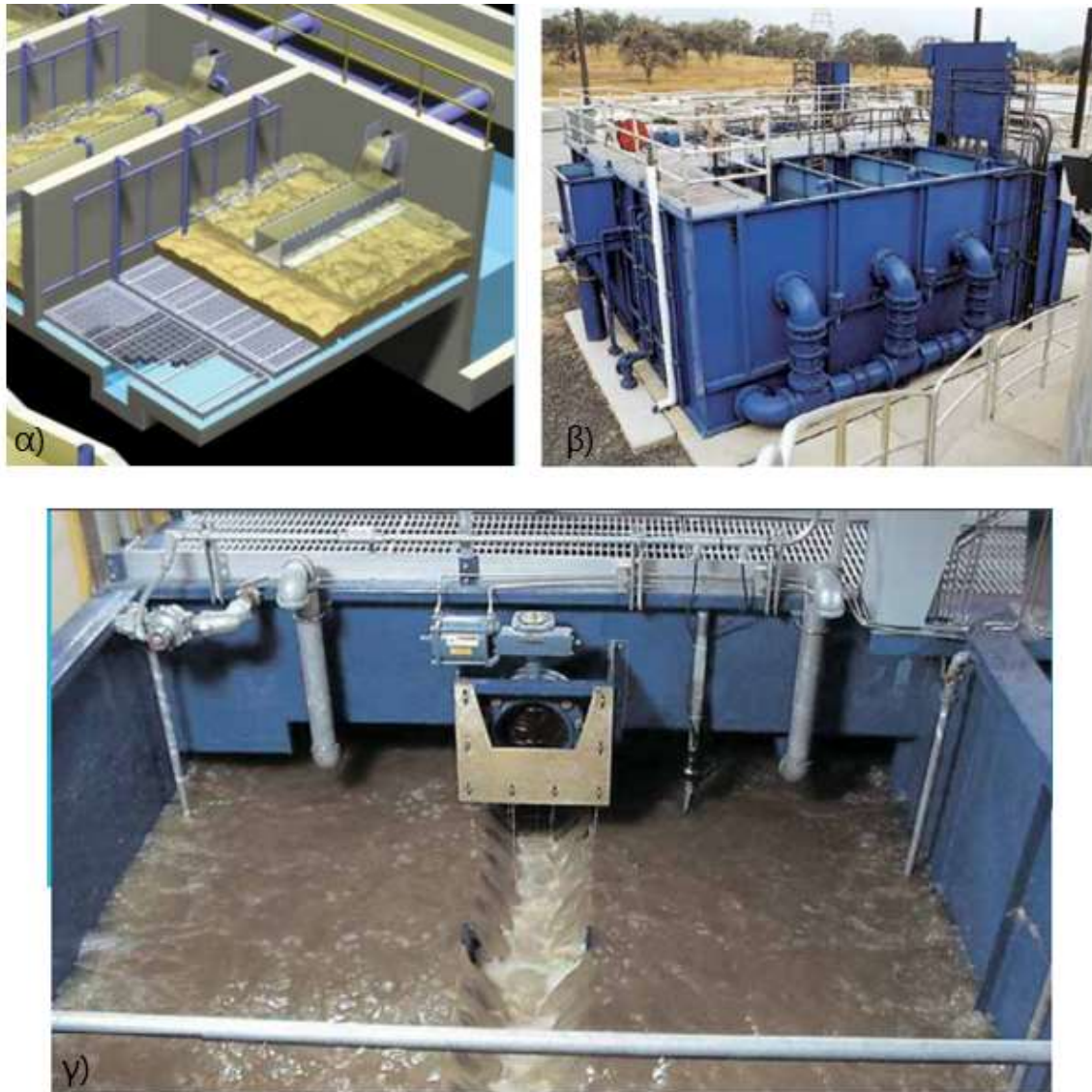
Σχήμα 2.12: α, β) και γ) φωτογραφίες ενός PBSF (Envoqua Water Technologies, 2014).
