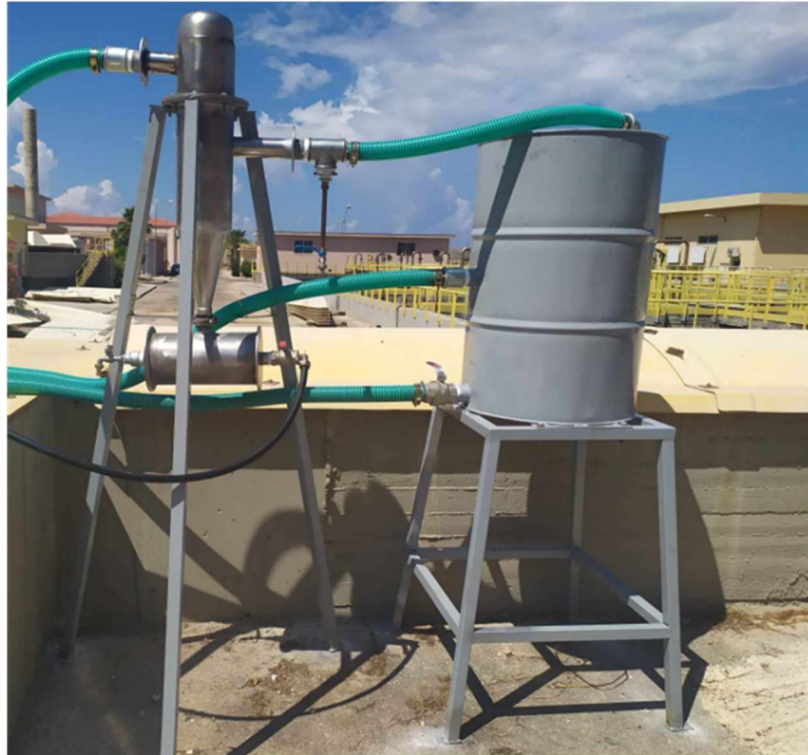
Σχήμα 2.17: Διάταξη υδροκυκλώνα στην ΕΕΛ Χανίων.
