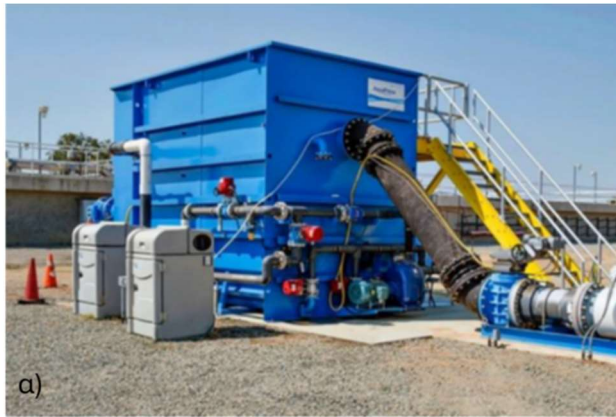
Σχήμα 2.10: (α) Φωτογραφία ενός CDF στην ΕΕΛ Linda, Καλιφόρνια, Ηνωμένες Πολιτείες Αμερικής, (β) Οκτώ μεμονωμένοι δίσκοι στο εσωτερικού του CDF (Caliskaner et al., 2018).
