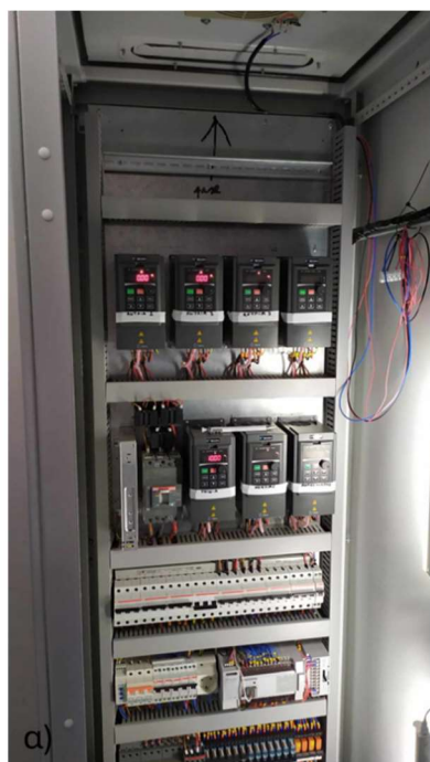
Σχήμα 5.6: α) Ηλεκτρολογικός πίνακας πιλοτικής μονάδας, β) αρχική οθόνη στο PLC που απεικονίζεται η πιλοτική μονάδα.
