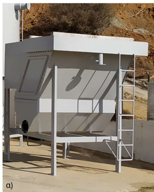
Σχήμα 5.4: Φωτογραφία της δεξαμενής καθίζησης με λαμέλλες που σχεδιάστηκε και κατασκευάστηκε από το εργαστήριο Σχεδιασμού Περιβαλλοντικών Διεργασιών του Πολυτεχνείου Κρήτης στην ΕΕΛ Μάρπησσας β) σχηματική απεικόνιση της δεξαμενής κατά τον σχεδιασμό.
