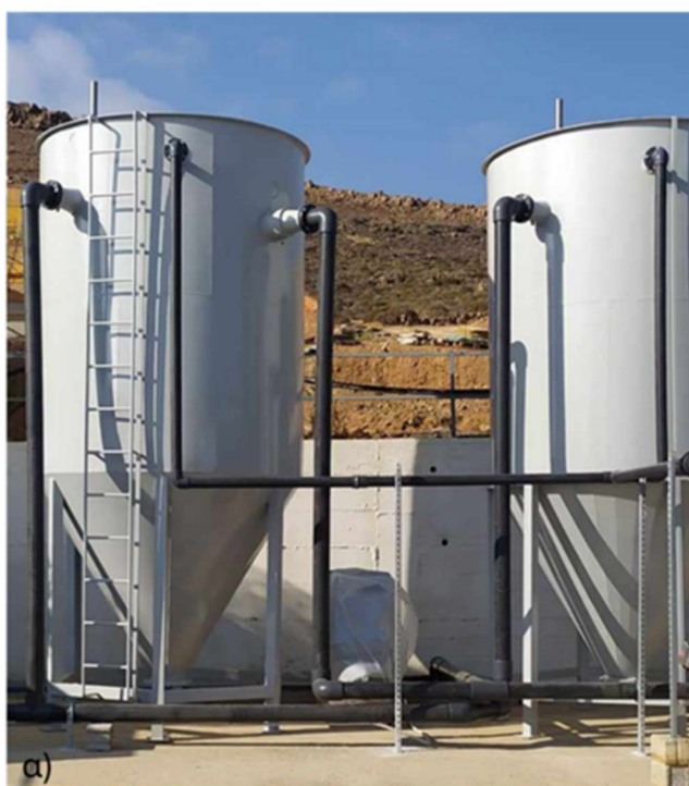
Σχήμα 5.3: α) Φωτογραφία των CBUMFs που σχεδιάστηκαν από το εργαστήριο Σχεδιασμού Περιβαλλοντικών Διεργασιών του Πολυτεχνείου Κρήτης στην ΕΕΛ Μάρπησσας β) σχηματική απεικόνιση των CBUMFs κατά τον σχεδιασμό.
