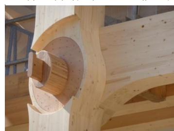
Εικόνα 85. «Λεπτομέρεια πλακιδίων και πείρων στα σημεία ένωσης»
