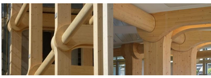
Εικόνα 82. «Μορφή σημείων συνάντησης δοκών με τα υποστυλώματα»
