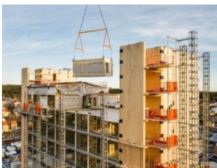
Εικόνα 76. «Φωτογραφία κατά την τοποθέτηση των προκατασκευασμένων μονάδων CLT»
