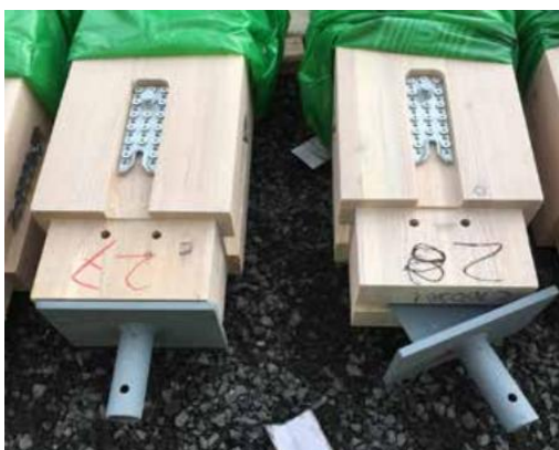
Εικόνα 57. «Κρυφοί προκατασκευασμένοι σύνδεσμοι»
