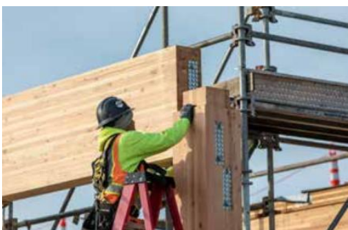
Εικόνα 56. «Συνδεσμολογία δοκών με υποστυλώματα»
