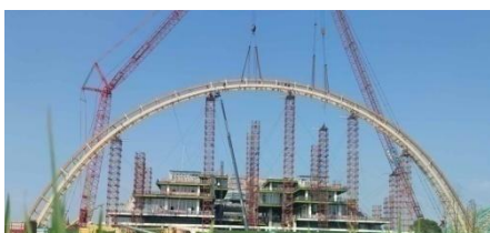
Εικόνα 95. «Οι χαλύβδινες κατασκευές κάτω από την αψίδα, κατά την διάρκεια συναρμολόγησης της»
