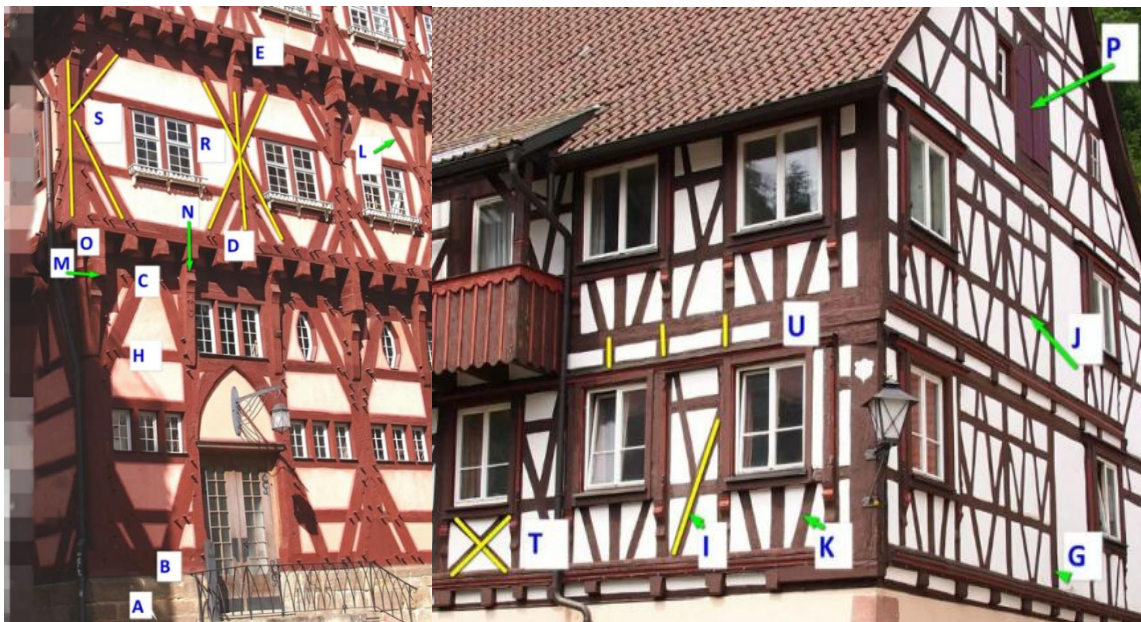
Εικόνα 11. «Κολλάζ με επεξηγηματικές εικόνες για τη δομή των σπιτιών Fachwerk»
