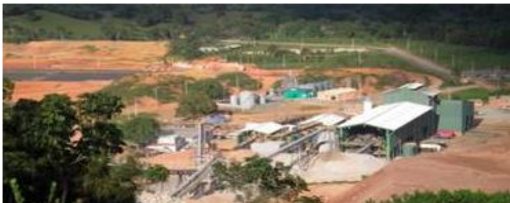
Σχήμα 3.6: Εγκαταστάσεις επεξεργασίας του μεταλλείου. Στα αριστερά βρίσκεται το εργοστάσιο εμπλουτισμού του οξειδωμένου μεταλλεύματος και στα δεξιά αυτό του θειούχου (Perilya Limited, n.d.).
