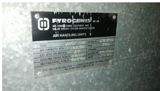
Εικόνα 7.4 Σύστημα κλιματισμού HVAC της υφιστάμενης δομής (Πηγή: Φωτογραφικό υλικό).
