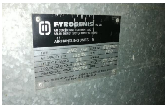
Εικόνα 4.7 Χαρακτηριστικά στοιχεία της μονάδας διαχείρισης του αέρα.
