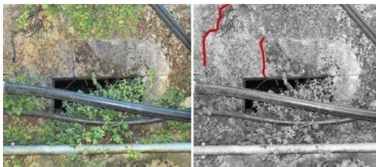
Εικόνα 69. Αστοχία σε μονολιθικό ανώφλι ανοίγματος της βόρειας όψης. Λήψη Γ. Λιόφαγος.
