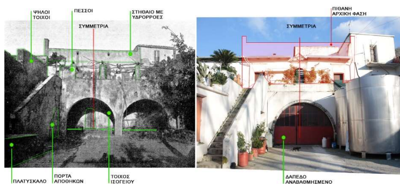
Εικόνα 24. Αριστερά: Φωτογραφική λήψη από τον G. Gerola το 1902. Δεξιά: Λήψη του 2023 (Γ. Λιόφραγος). Παρατηρούμε την υπερύψωση του δαπέδου. Επίσης έχουν καθααιρεθεί, ο τοίχος με την είσοδο του ισογείου, το στηθαίο του δώματος με τις υδρορροές, οι πεσσοί στον εξώστη. Επιπλέον δεν υπάρχει η είσοδος αριστερά κάτω από τη σκάλα και οι υψηλές τοιχοποιίες στο πλάι της.
