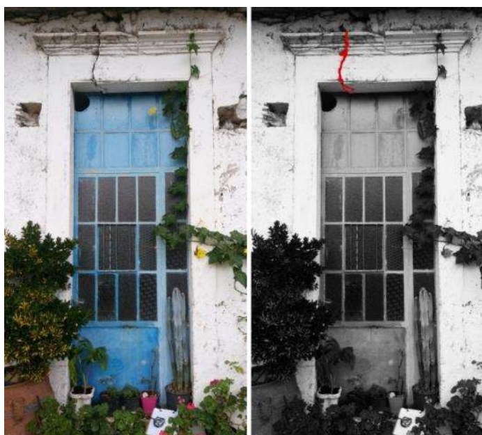
Εικόνα 70. Αστοχία σε μονολιθικό ανώφλι ανοίγματος της δυτικής - κύριας όψης. Λήψη Γ. Λιόφαγος.
