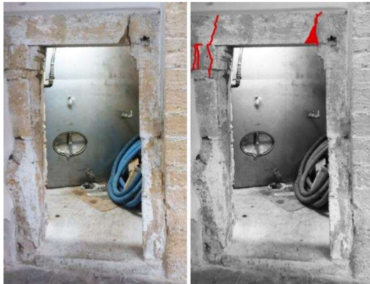
Εικόνα 67. Ρωγμές στο ανώφλι θύρας ισογείου. Λήψη: Γ. Λιόφαγος.
