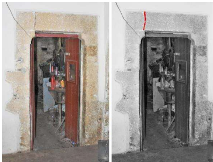
Εικόνα 68. Ρωγμές στο ανώφλι θύρας ισογείου. Λήψη Γ. Λιόφαγος.
