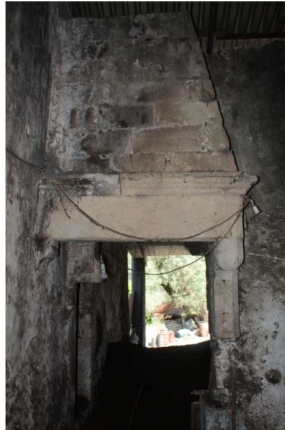
Εικόνα 47. Αποτύπωση όψης λιθοκτιστής εστίας σε κεντρικό χώρο στον όροφο. Σχέδια αποτύπωσης και φωτογραφίες: Γ. Λιόφαγος.
