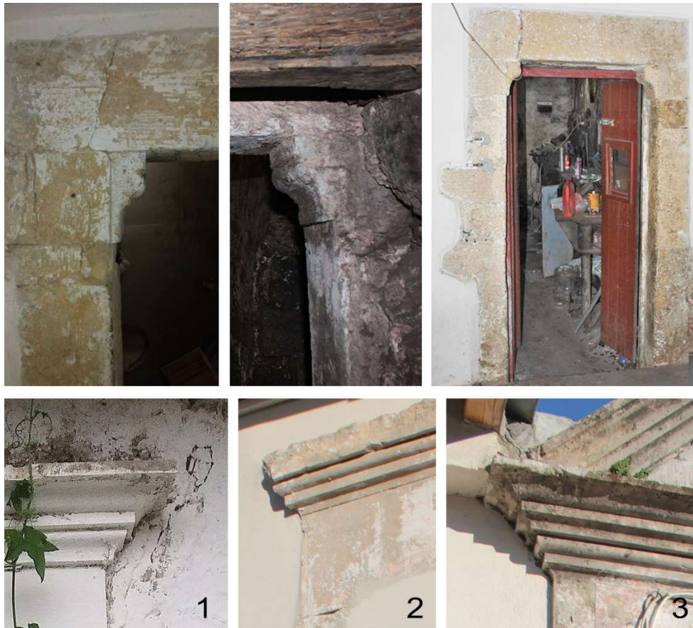
Εικόνα 50. Λίθινα γείσα στα πλαίσια των ανοιγμάτων της κύρια όψης (δυτική). Διακρίνουμε τη διαφορετική μορφή τους. 1: Ακραίο άνοιγμα, 2: άνοιγμα πλησίον του θυρώματος. 3: κεντρικό θύρωμα.
