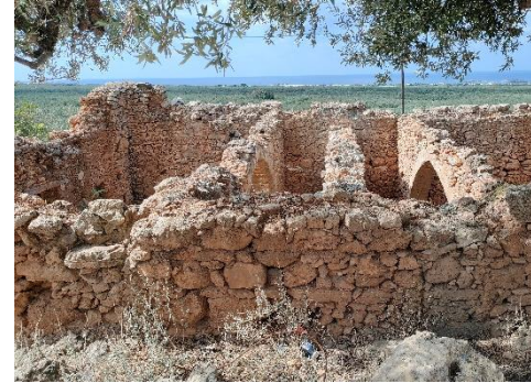
Εσωτερικό που γεφυρώνεται με καμάρες Τοιχόπαχο 60 εκατοστών
