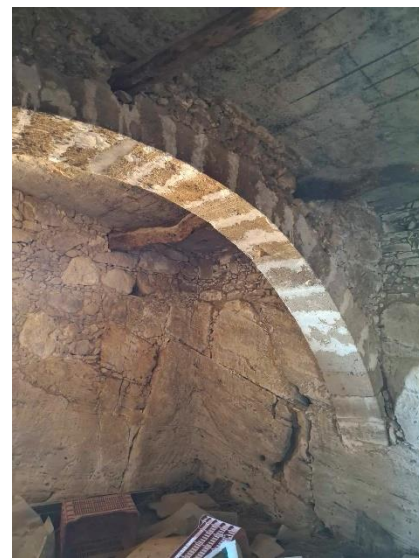
Καμάρα χωρίς «πόδι» με τα πακτωμένα ξύλινα δοκάρια και το μεταγενέστερο δώμα από σκυρόδεμα
