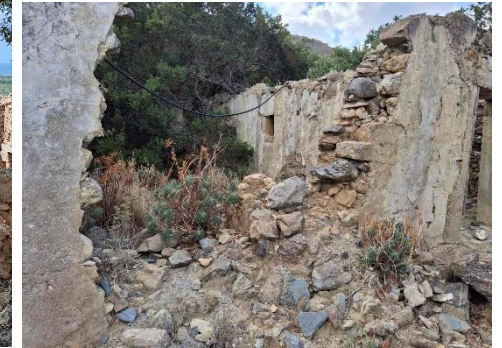
Εσωτερικό που γεφυρώνεται με καμάρες Τοιχόπαχο 60 εκατοστών
