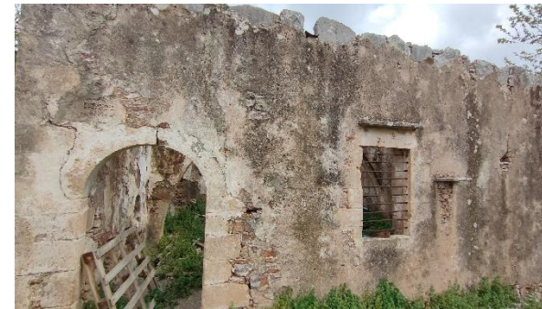
Επιχρισμένη κατοικία με τοξωτή πόρτα και πέτρες που προεξέχουν. Η μια για την προφύλαξη από το νερό της βροχής και η άλλη για αντικείμενα
