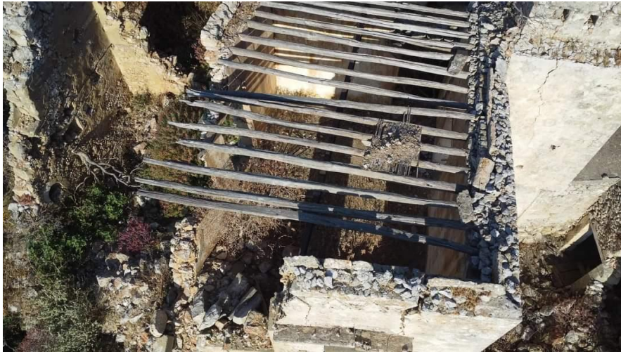
Κατασκευή χωρίς μεσοδόκι με πυκνά δοκάρια απο κυπαρίσι και λίγα απομεινάρια από τα καλάμια και τη <<λεπίδα>>
