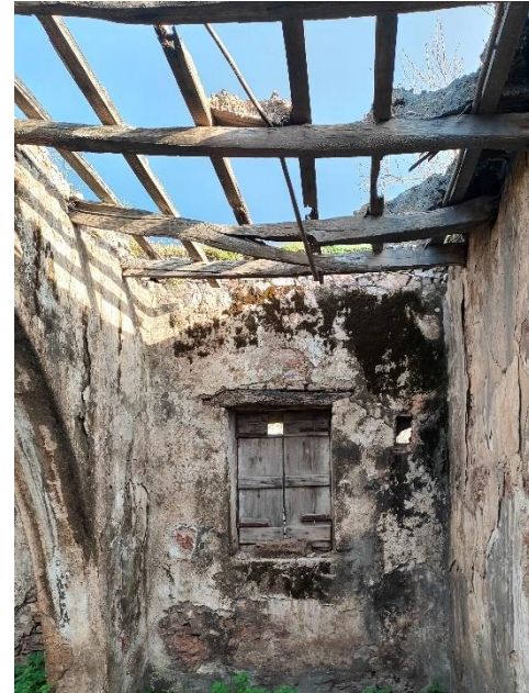
Ξύλινα δοκάρια πακτωμένα στην καμάρα και υπολείμματα από τα καλάρια και το χώμα
