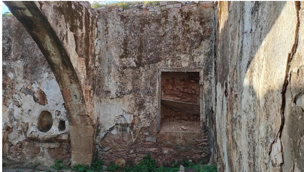
Δεξιά η εσοχή στον τοίχο που χρησιμοποιούνταν ως ερμάριο με το ράφι της και πιθανώς και με πορτάκια και αριστερά η εσοχή για τη λάινα και το μαστραπά
