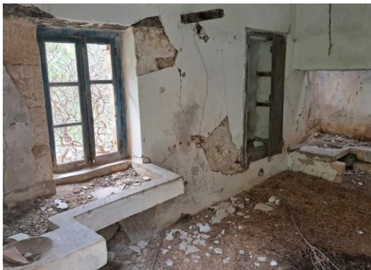
Υπολείμματα κονιάματος εσωτερικά και εξωτερικά των κατοικιών
