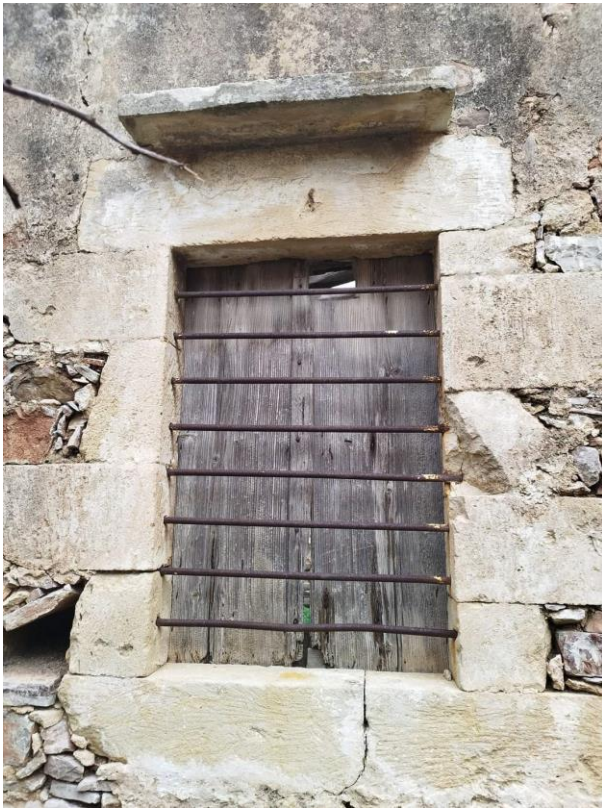
Άνοιγμα με τα παραθυρόφυλλα, τις σιδεριές και μια πλάκα που προεξέχει για τα νερά
