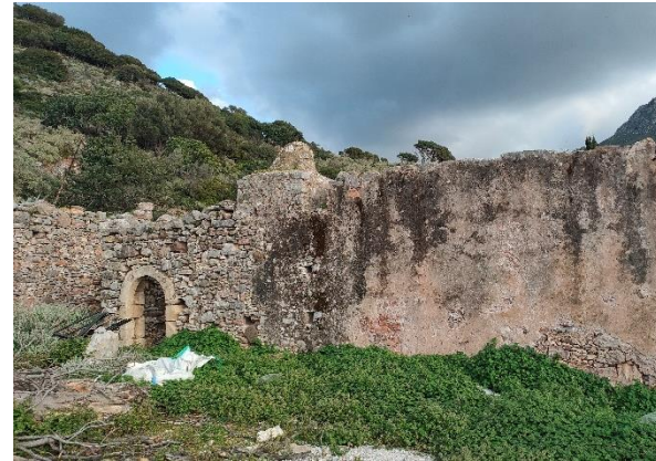
Υπολείμματα από επίχρισμα στο μεταγενέστερο κομμάτι του κτίσματος
