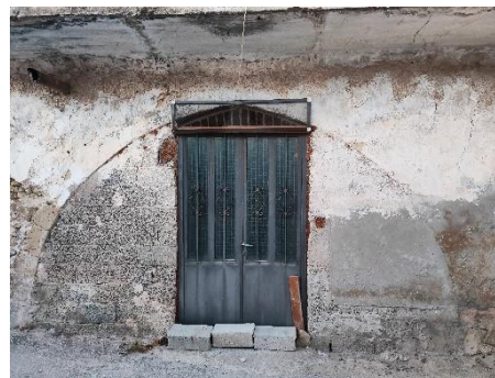
Καμάρα κλεισμένη με τσιμεντόλιθους
