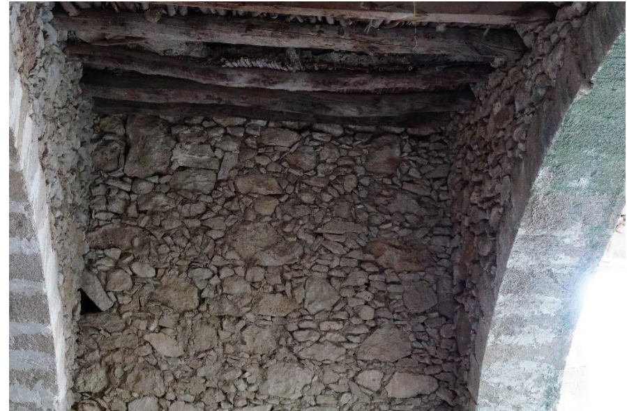
Ξύλινα δοκάρια και η επικάλυψη από καλάμι ανάμεσα σε δύο καμάρες
