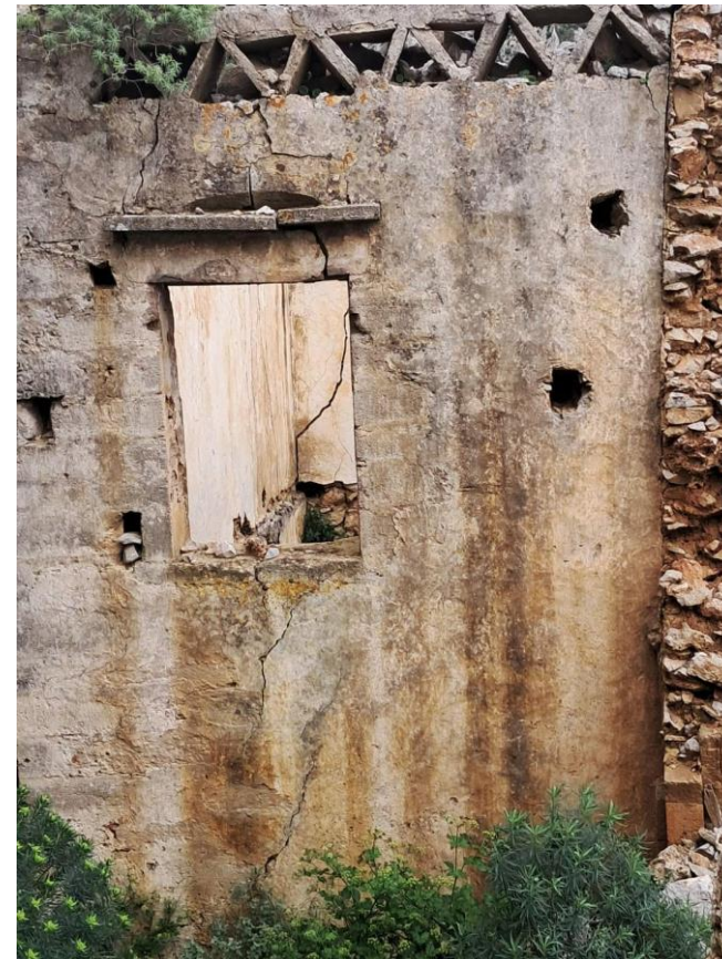
Σκαλοθυρίδες γύρω και πάνω από το άνοιγμα
