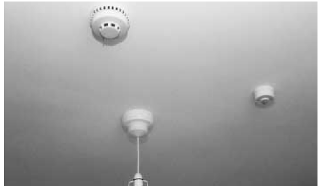
Εικόνα 16: Ανιχνευτής καπνού, υπέρυθρων και λάμπα (Barlow et al.,1999,p.75).
