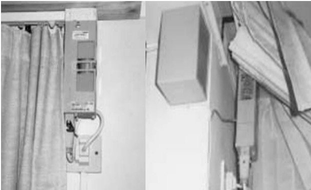
Εικόνα 25: Μοτέρ κουρτίνας (Barlow et al.,1999,p.77).
