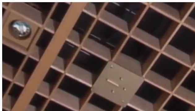
Εικόνα 5: Λεπτομέρεια στην οροφή με ενσωματωμένο μικρόφωνο.
