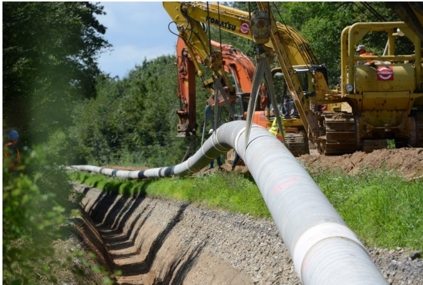
Εικόνα 1.2: Τοποθέτηση των σωλήνων φυσικού αερίου για τον αγωγό Nordschwarzwald στη Γερμανία. Πηγή: FNB GAS
