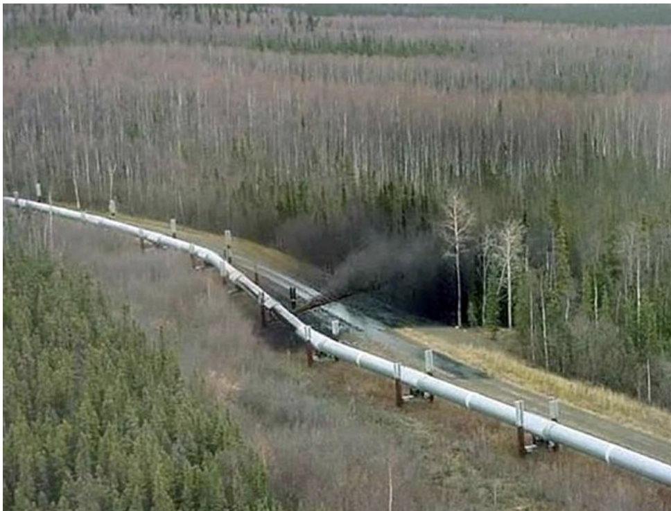
Εικόνα 2.1: Διαρροή πετρελαίου σε αγωγό του Περού Πηγή : The Energy Year
