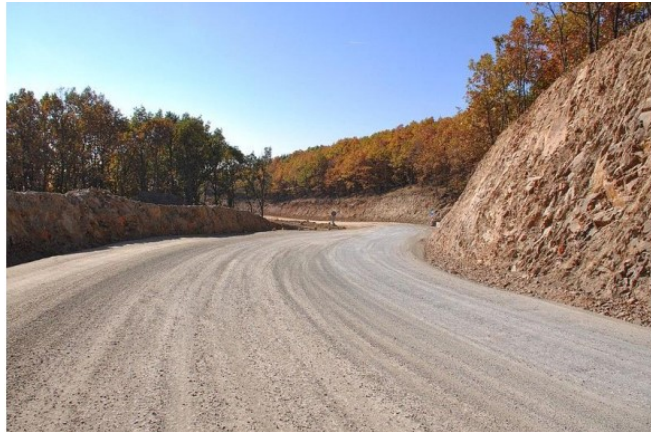
Εικόνα 2.2: Όρυγμα για τη διαμόρφωση οδοστρώματος (Antigoldgreece, 2014).
