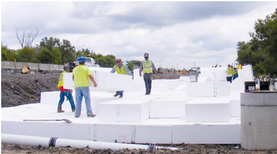
Εικόνα 3.1: Μπλοκ διογκωμένης πολυστερίνης (EPS Industry Alliance, 2020).
