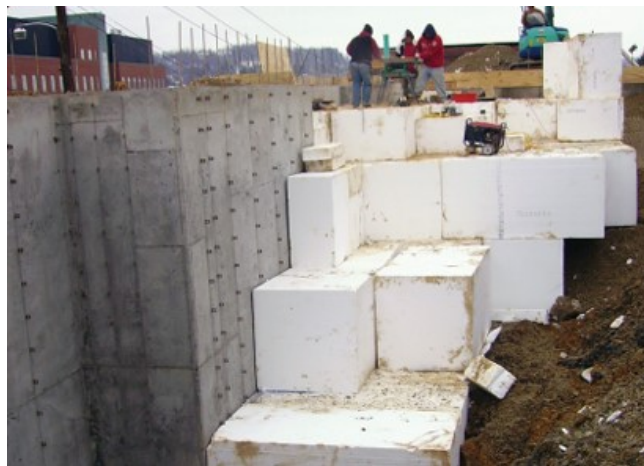
Εικόνα 3.9: Τοίχος αντιστήριξης EPS για την επίχωση τοίχων στις φοιτικές εστίες του Πανεπιστημίου της Δυτικής Βιρτζίνια, στη Morgantown (EPS Industry Alliance, 2020).
