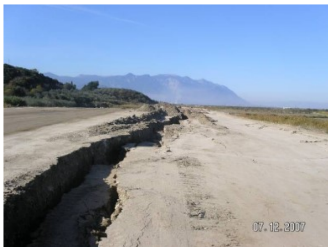
Εικόνα 5.11: Αστοχία κατά την κατασκευή του οδικού επιχώματος στον ΠΑΘΕ (Παπαχαλαράμπους κ.α., 2008).
