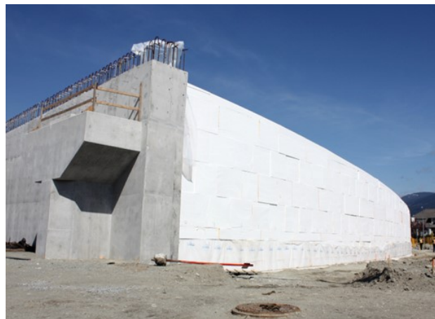
Εικόνα 3.7: Χρήση γεωαφρού EPS σε ακροβάθρο γέφυρας (Lyratzakis, 2021).
