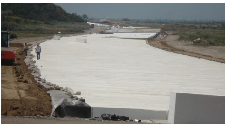
Εικόνα 3.4: Τοποθέτηση μπλοκ EPS στον αυτοκινητόδρομο ΠΑΘΕ (EPS Hellas).
