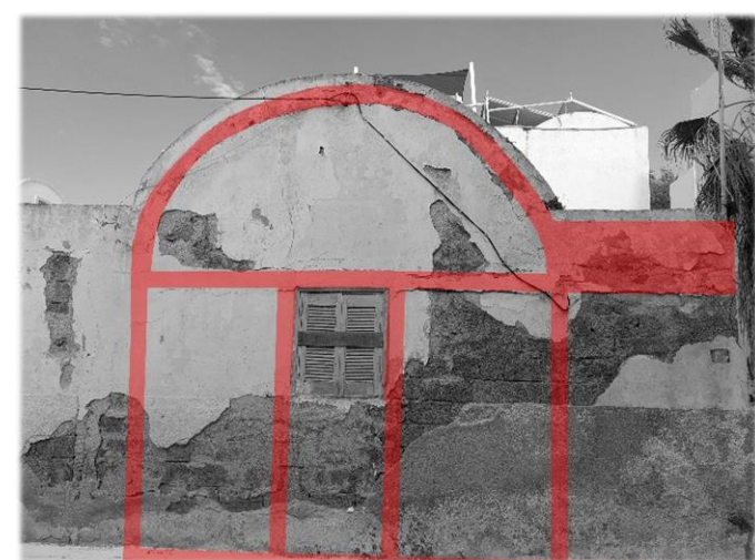
Εἰκόνα 136 : Σημερινή ἀπεικόνιση ἐνὸς εγκαταλελειμμένου κτιρίου τῆς ανοικοδόμησης (ἐνὸς μονόθολου τύπου Α κατοικίας) στὸν οἰκισμό των Φηρῶν που ἐπιτρέπει τὴ διεξαγωγή συμπερασμάτων ὡς πρὸς τὴ χρήση υλικῶν καὶ τὴ δόμησή του ἐν γένει. Πηγή: προσωπικὸ ἀρχεῖο
