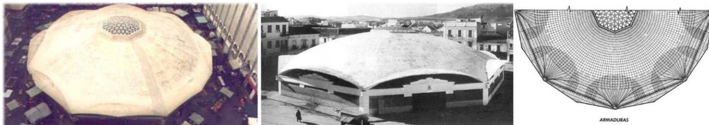
Εικόνα 238: Απόψεις και σχέδιο του Market Hall στο Algeciras της νότιας Ισπανίας. Έργο του αρχιτέκτονα μηχανικού Eduardo Torroja (1933). Πηγή: http://www.torrojaingenieria.es/TRABAJOS/EDIFICIOS/9510-MERCADO%20ALGECIRAS%20DESCRIPCION/ENGLISH%20PAPER/EP-9510-MERCADO%20ALGECIRAS%20DESCRIPCION.pdf
