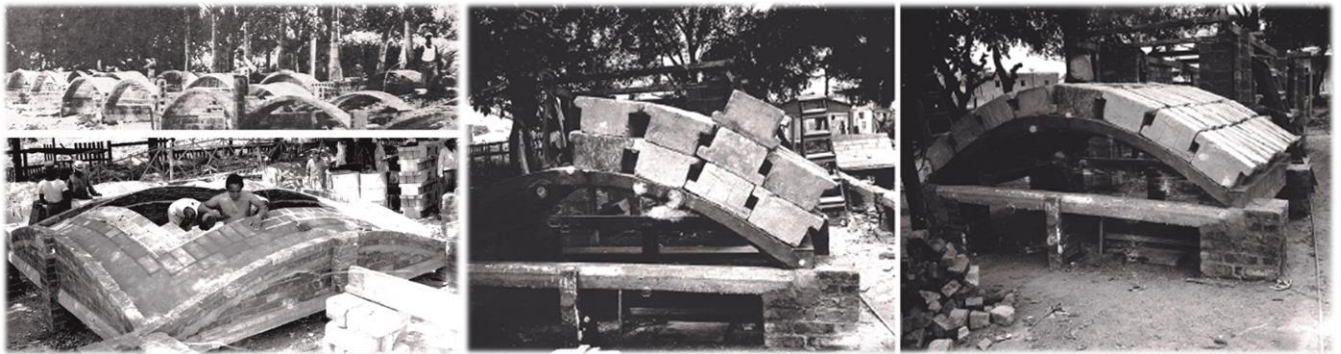
Εικόνα 250: Αριστερά: άποψη της εκπαιδευτικής συνεργασίας διαφορετικών ειδικοτήτων. Κέντρο και δεξιά: Συμμετρικές και ασύμμετρες φορτίσεις σε πειραματικούς θόλους. Αθάνα 1961. Πηγή: Al Asali, M. W., Couret, D. G., & Ramage, M. H. (2021). Beyond the National Art Schools. Journal of the Society of Architectural Historians , 80, Article 3. https://doi.org/10.1525/jsah.2021.80.3.321
