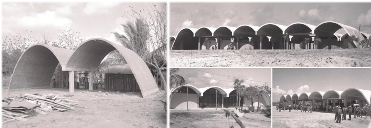
Εικόνα 248: Αριστερά: άποψη κατασκευής του πρώτου θόλου από τούβλα στην Κούβα μετά την επανάσταση. Έργο του αρχιτέκτονα Juan Campros Almanza και του πολιτικού μηχανικού Alfredo Pérez. Δεξιά: απόψεις των παραθαλάσσιων σπιτιών (cabañas) στη Santa Lucía, βόρεια του Camagüey. Έργο του ίδιου αρχιτέκτονα Juan Campros Almanza το 1960. Πηγή: Al Asali, M. W., Couret, D. G., & Ramage, M. H. (2021). Beyond the National Art Schools. Journal of the Society of Architectural Historians , 80, Article 3. https://doi.org/10.1525/jsah.2021.80.3.321
