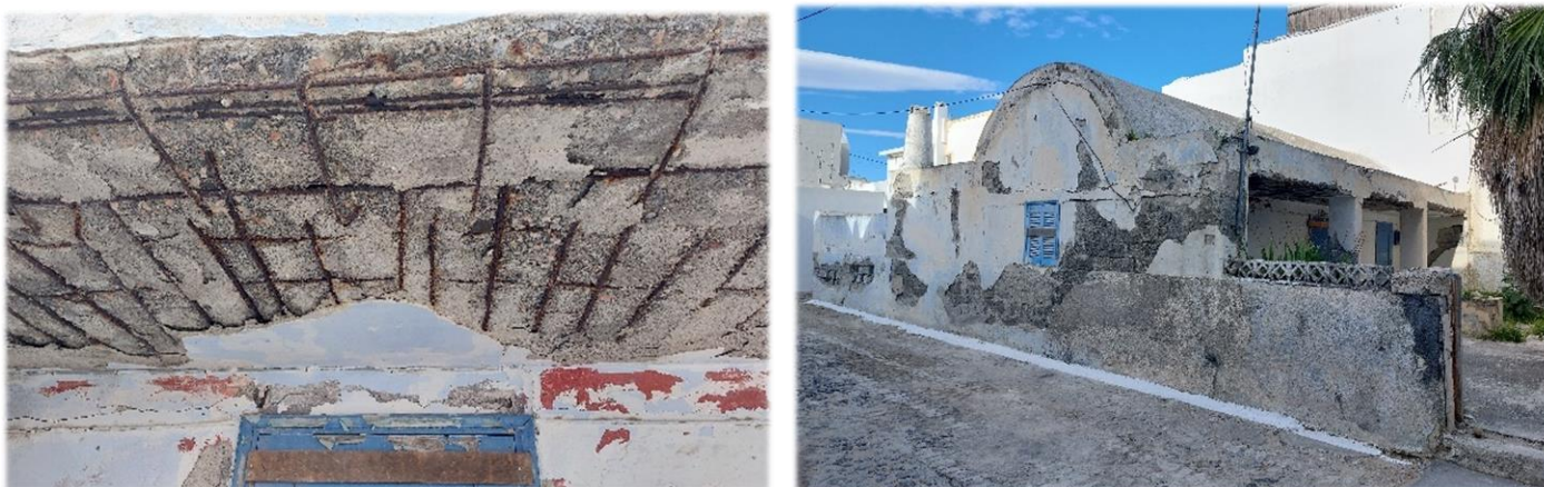
Εικόνα 134: Σημερινή απεικόνιση οπλισμών στην οροφή της στοάς ενός μονόθολου τύπου Α κατοικίας στον οικισμό των Φηρών. Πηγή: προσωπικό αρχείο
