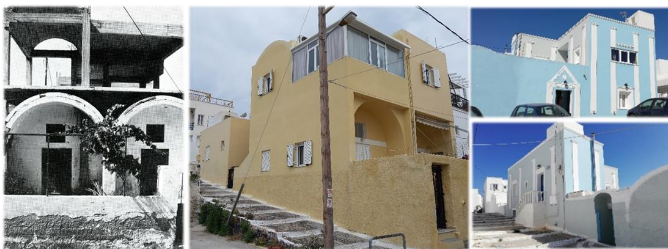
Εικόνα 138: Αριστερά τρόπος κάλυψης αρχικών θόλων στα συγκροτήματα κατοικίας για δημιουργία ορόφου. Πρόσοψη πηγή Γ. Αίσωπος, Στ. Γυφτόπουλος, Κ. Φίλιππα και Μ. Χατζηγιαννούλη, αρχιτέκτονες, «Επιστροφή στην Σαντορίνη», Αρχιτεκτονικά Θέματα 26, 1992. Κέντρο: άποψη επεμβάσεων σε μια γωνιακή κατοικία στα Φηρά Θήρας και δεξιά σημερινές απόψεις κατοικίας του προγράμματος της ανοικοδόμησης στο Ημεροβίγλι που εκτός από την προσθήκη έχουν ενσωματωθεί νεοκλασικά στοιχεία. Πηγή: προσωπικό αρχείο. Είναι εμφανές το κλίμα πολλών μεταρρυθμίσεων εκείνης της περιόδου.
