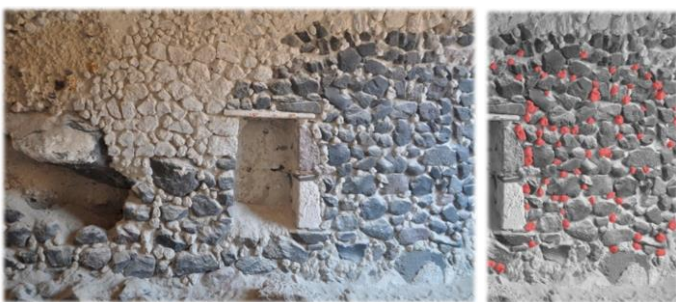
Εικόνα 35: Απεικόνιση εσωτερικής τοιχοποιίας ενός υπόσκαφου χώρου στον οικισμό Αγγιλιάς της νήσου Θηρασίας. Ανάμεσα στους λίθους εισάγονται στο κονίαμα τόφφοι ως σφήνες. Φωτογραφία Ι. Ντούτση δεξιά προσωπική επεξεργασία. Πηγή: Εγχειρίδιο για τις θηραϊκές τεχνικές δόμησης ομάδα Μπουλούκι σελ 33
