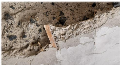
Εικόνα 40 : Στρώματα της ενδιάμεσης κατασκευής του χώματος και της υπόσκαφης κατοικίας. Πηγή:προσωπικό αρχείο
