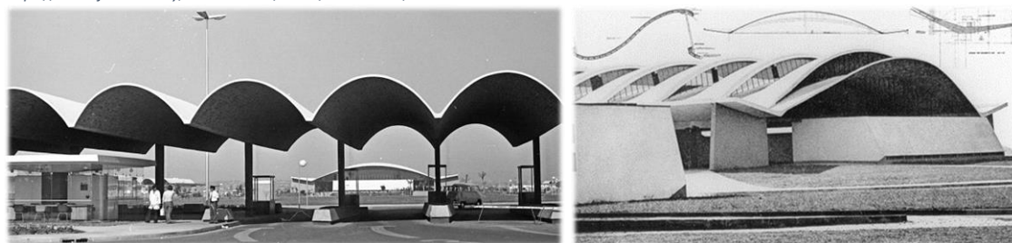
Εικόνα 272: Αριστερά απεικόνιση των αυτοφερόμενων θολωτών στεγάστρων που στηρίζονται από μία σειρά πεσσών και δεξιά απεικόνιση στέγασης των κλιμακωτών τοξωτών φωταγωγών, τμήματα του τερματικού σταθμού λεωφορείων (1973) στο Dámaso Antonio Larrañaga y Latorre, Ουρουγουάη. Πηγή: https://benhuser.com/2012/01/31/eladio-dieste-porto-alegre-rs/
