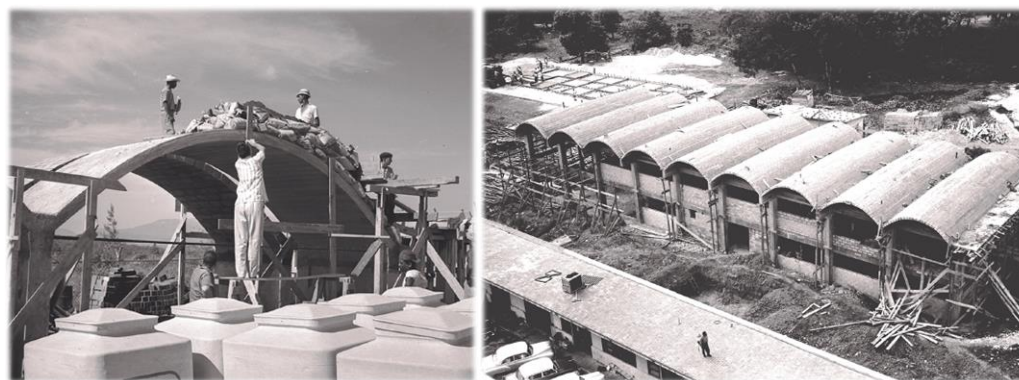
Εικόνα 249: Αριστερά: άποψη κατασκευής του πειραματικού θόλου στο Santiago de Cuba της Κούβας 1960. Δεξιά: άποψη του κτιρίου γραφείων και κέντρο τεχνικής έρευνας με θόλο από τσιμεντόλιθο στην Αβάνα της Κούβας. Επικεφαλής του έργου ήταν ο Hugo D' Acosta Calheiros. 1960. Πηγή: Al Asali, M. W., Couret, D. G., & Ramage, M. H. (2021). Beyond the National Art Schools. Journal of the Society of Architectural Historians , 80, Article 3. https://doi.org/10.1525/jsah.2021.80.3.321
