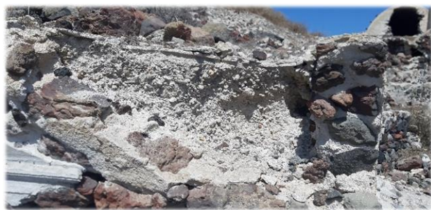
Εικόνα 25: Άποψη επίχωσης μιας θολωτής στέγας. Πηγή: προσωπικό αρχείο.
