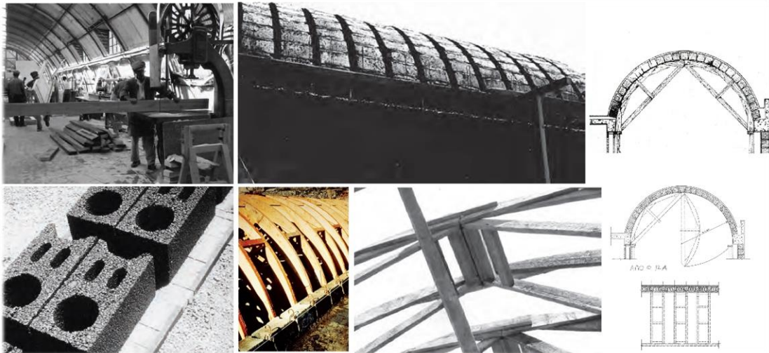
Εικόνα 118: Απόψεις και σκίτσα που αφορούν την κατασκευή, κισσηρόλιθοι, ξυλότυποι μέσω των οποίων θα σχηματιστεί ένα τριαρθρωτό τόξο όπου θα καλουπωθεί ο κυλινδρικός θόλος. Πηγές:
