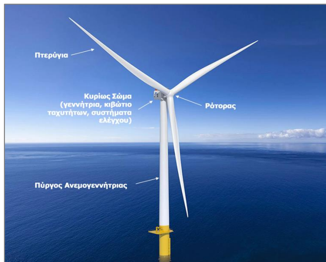
Εικόνα 9: Μέρη ανεμογεννήτριας
