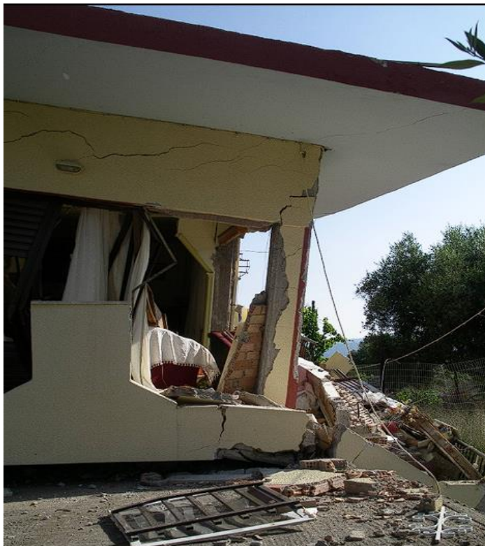
Εικόνα 149 Υποστύλωμα K12 πρώτου ορόφου. Το αντίστοιχο υποστύλωμα του ισογείου έχει καταστραφεί πλήρως
