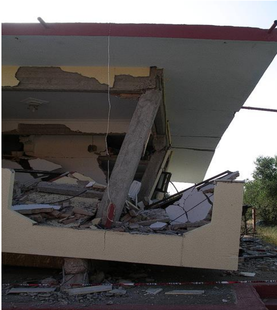
Εικόνα 150 Υποστύλωμα Κ9 πρώτου ορόφου. Το αντίστοιχο υποστύλωμα του ισογείου έχει καταστραφεί πλήρως(Φιτνέογλου, Χαραλαμπίδη, 2008).
