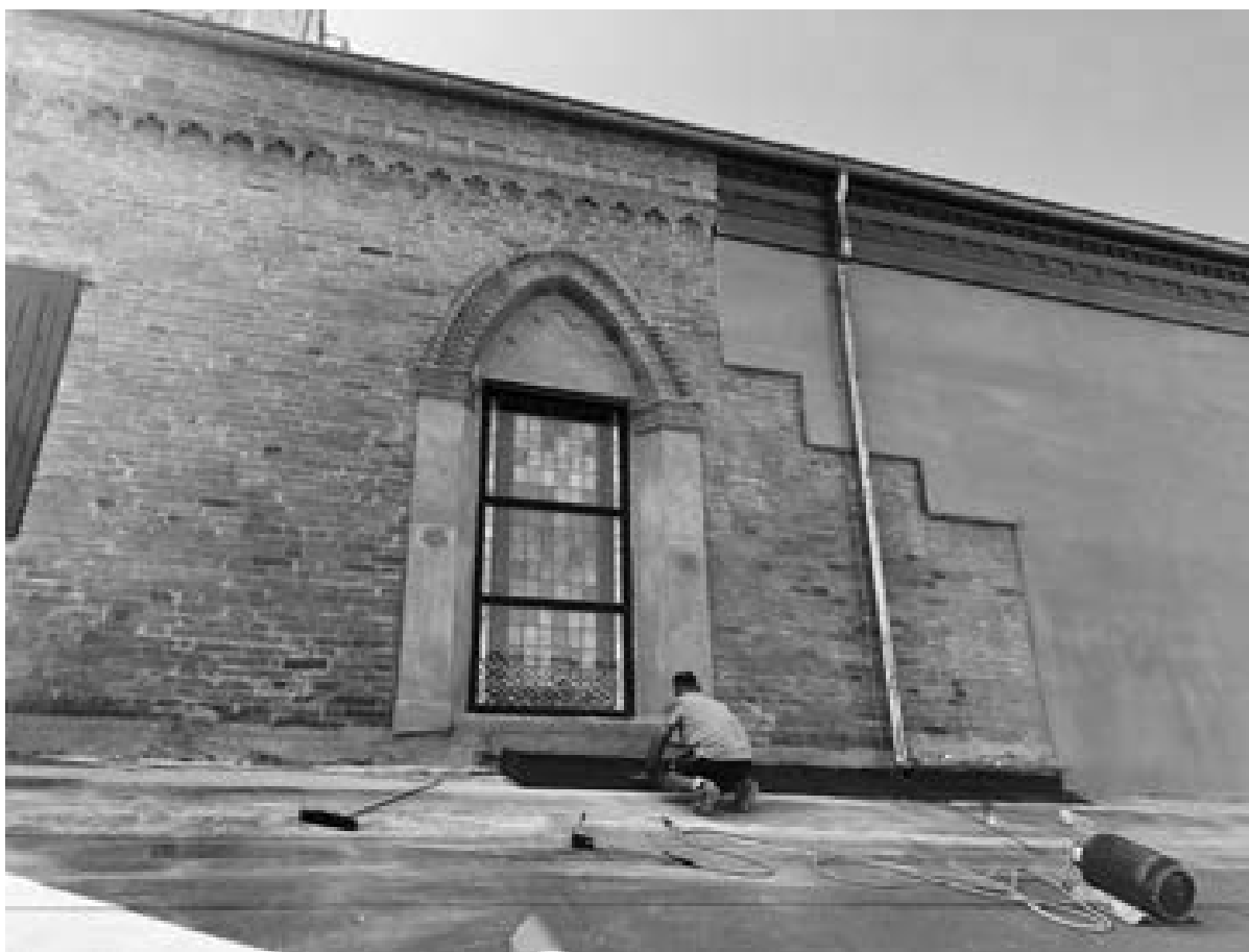
Εικόνα 33: Εξωτερική άποψη της αποκατάστασης - αναδόμησης του βόρειου τοίχους του κλίτους. Παρατηρούμε της δημιουργία "σκαλοπατιού" στην νέα τοιχοποιία από ξύλινο σκελετό και πάνελ το οποίο γίνεται για λόγους διάκρισης μεταξύ παλαιού - νέου και υπόμνησης του κατεστραμμένου τμήματος από τον σεισμό. Ακόμη, εμφανίζεται η συνέχεια με τα ίδια μοτίβα του διακοσμητικού γείσου της στέγης.
