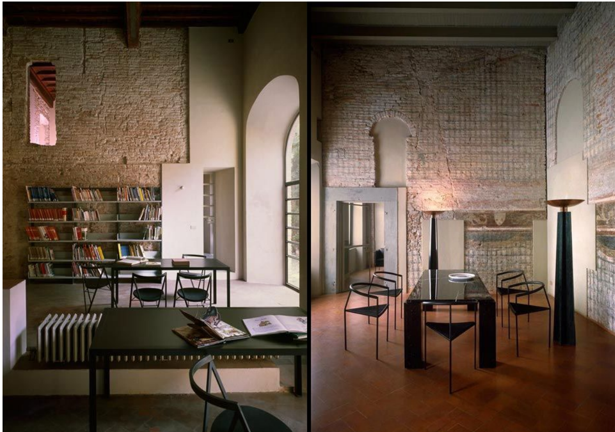
Εικόνα 34: Απόψεις από την casa Pierotti. Είναι εμφανή τα σημάδια του χρόνου στις τοιχοποιίες, ενώ οι νέες επεμβάσεις διακρίνονται με τις επιχρισμένες επιφάνειες που είτε εισέρχονται, είτε εξέρχονται από την επιφάνεια της παλαιάς τοιχοποιίας.
