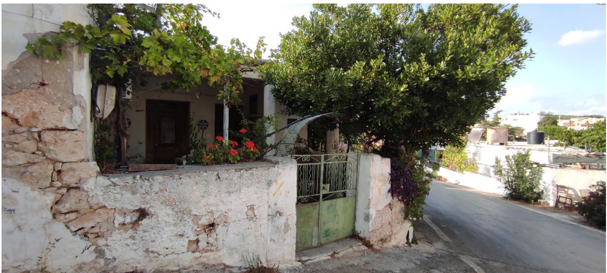
Εικόνα 19: Κατοικία της περιόδου 1898 - 1970. Σύγχρονη οικία με φέροντα οργανισμού από οπλισμένο σκυρόδεμα χαρακτηρισμένη κίτρινη, δηλαδή κατοικήσιμη ύστερα από επισκευές. Είναι εμφανή η διακοσμητική τάση στην είσοδο (εξώπορτα) και οι λεπτές διατομές των κολώνων του πρόπυλου (ημιυπαιθρίου).
