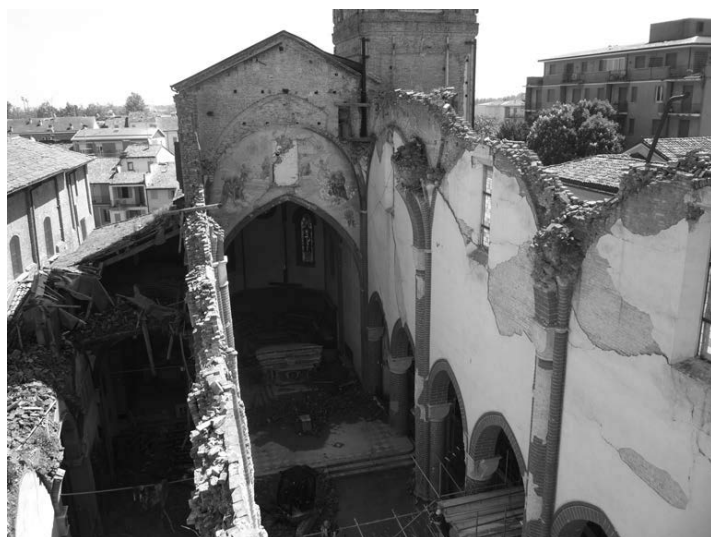
Εικόνα 28: Αριστερά: Ο ναός μετά τον σεισμό του 2012. Είναι εμφανή η περιστροφή του αριστερού τοίχους του κεντρικού κλήρους. Δεξιά: Οι μηχανισμοί κατέρρευσης που ενήργησαν στον ναό.
