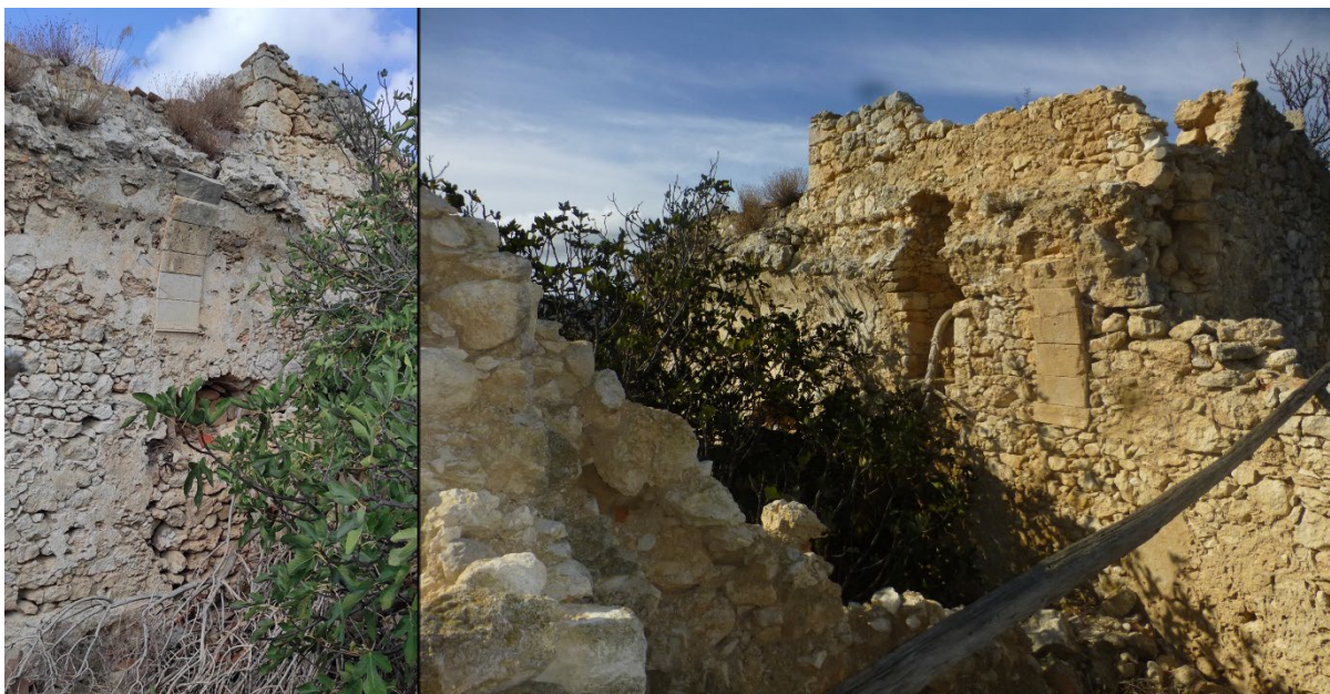
Εικόνα 12: Αριστερά το νότιο τμήμα της οικίας. Δεξιά το βόρειο. Διακρίνονται τα ενισχυτικά τόξα καθώς και θολωτό άνοιγμα στο μέσο, που συνδέει τα δύο επίμηκες τμήματα του κτηρίου.
