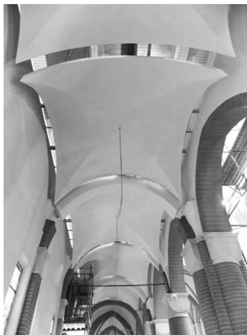
Εικόνα 32: Τα ηχοαπορροφητικά πάνελ τα οποία προσομοιάζουν τα σταυροθόλια του ναού. Η σκοτία που υπομνύει την απώλεια που προκάλεσε ο σεισμός στο σώμα του κτηρίου.
