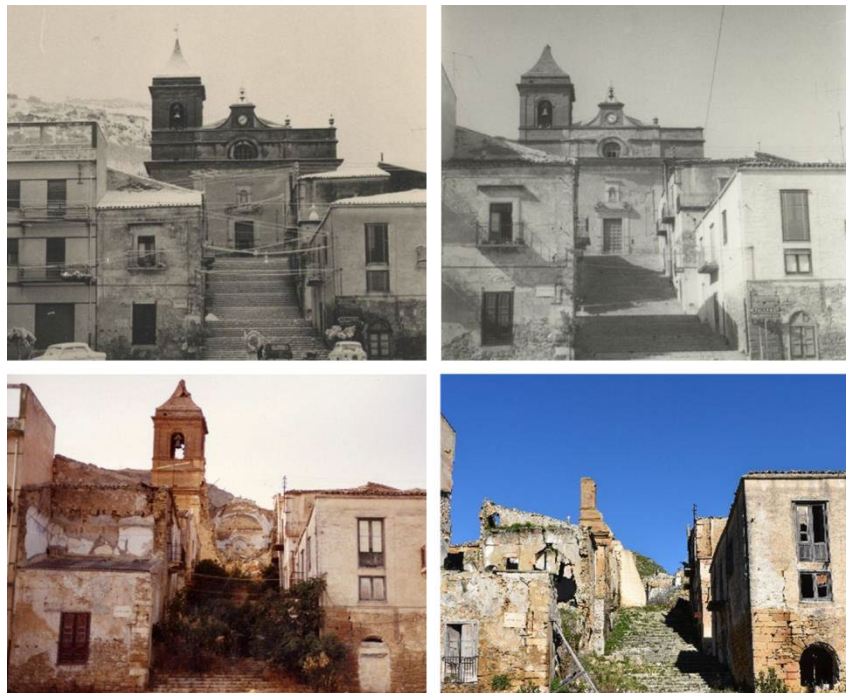
Εικόνα 36: Ο κεντρικός ναός του Poggioreale Antica πριν και μετά τον σεισμό (πάνω αριστερά και δεξιά), στις αρχές της δεκαετίας του 2000 (κάτω αριστερά) και το 2022 (κάτω δεξιά).
