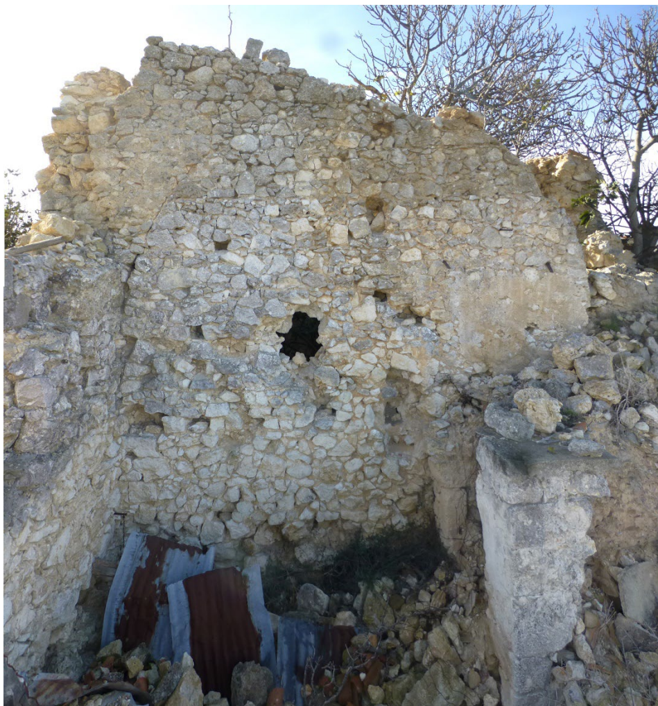
Εικόνα 13: Το βόρειο τμήμα του δυτικού θολοσκεπή χώρου με την μεταγενέστερη έμφραξη κάτω από το ενισχυτικό τόξο το οποίο δεν σώζεται ολόκληρο. Στον χώρο υπάρχουν μεταγενέστερες κατασκευές κατά τον κατακερματισμό του.
