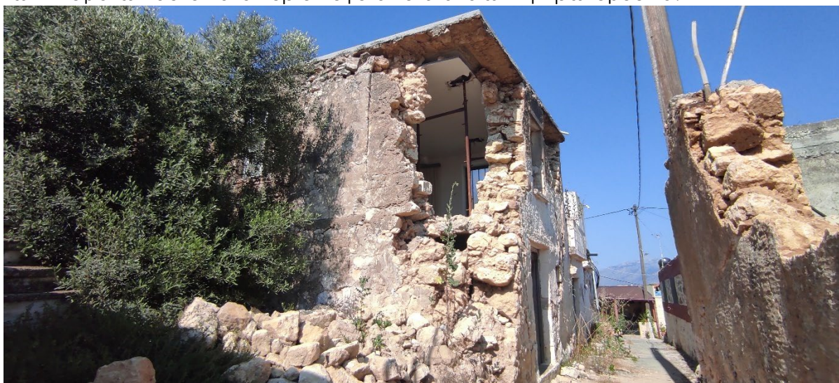
Εικόνα 43: Κτήριο στην περίμετρο του ιστορικού ιστού του Γαλατά, στο οποίο έχει αστοχήσει η γωνιά και έχει απωλέσει την διαφραγματική λειτουργία του αφού η πλάκα από οπλισμένο σκυρόδεμα έχει συμπεριφερθεί διαφορετικά από ότι το υπόλοιπο κτήριο και για αυτό έχουν τοποθετηθεί τα ικριώματα για την συγκράτησή αυτής.
