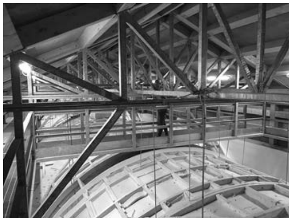
Εικόνα 31: Αριστερά: Τρισδιάστατη απεικόνιση του νέου ξύλινου φορέα της στέγης - τοιχοποιίας ο οποίος συμπληρώνει την ογκοπλασία του ναού. Δεξιά: Όπως κατασκευάστηκε ο φορέας με τις αναρτήσεις των σταυροθολίων.
