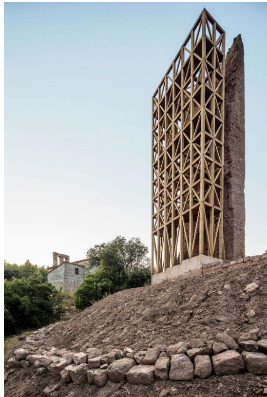
Εικόνα 45: Carles Enrich, Αποκατάσταση του πύργου του Merola. Ο πύργος το 1500 δέχτηκε σεισμικές δονήσεις με αποτέλεσμα να διατηρείται μία από τις τέσσερις τοιχοποιίες - όψεις του. Η μελέτη προσπαθεί να ανάκτηση την γεωμετρία του πύργου μέσω των ξύλινων ικριωμάτων που παράλληλα στηρίζουν και συγκρατούν τα εναπομείναντα τμήματα.
