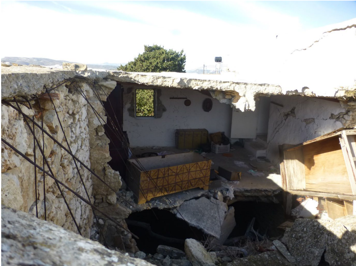
Εικόνα 21: Κατοικία εντός του ιστορικού πυρήνα του οικισμού, η οποία έχει καταρρεύσει μέρος της. Στην εικόνα παρατηρούμε ότι ο όροφος παρότι λιθόκτιστος έχει προστεθεί σε δεύτερη φάση. Στο αρχικό μονόχωρο ισόγειο κτήριο, το οποίο διατηρεί το αρχαιολογικό δομικό σύστημα της ξύλινης δοκού με ξύλινο υποστυλώμα στο κέντρο του χώρου, έχει προστεθεί όπλη πλάκα σκυροδέματος και πάνω σε αυτή έχει εγκατασταθεί μεταγενέστερα ο όροφος, ο οποίος έφερε δοκό και πλάκα από οπλισμένο σκυρόδεμα με μεταλλικές ράβδους χωρίς στείρα.
