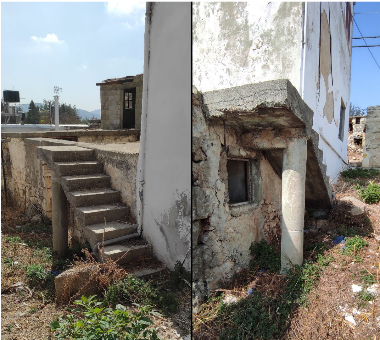
Εικόνα 18: Κλίμακα από οπλισμένο σκυρόδεμα σε εγκαταλελειμμένη μονόχωρη λίθοκτιστη οικία εντός του ιστορικού πυρήνα. Η λεπτότητα του ανώνυμου τεχνίτη για την κάλυψη της ανάγκης της μετάβασης στην προσθήκη στον όροφο της οικίας θα χαρακτηρίζονταν αντάξια των αρχιτεκτόνων του μοντέρνου κινήματος.
