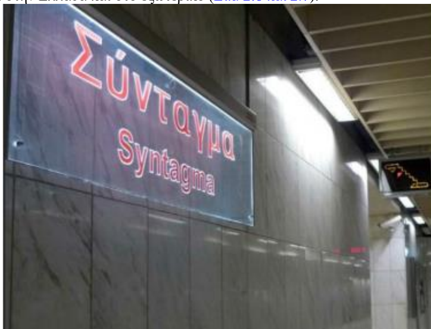
Εικ. 2.6. Ορθομαρμάρωση με μάρμαρο Βόλακα στο σταθμό μετρό Σύνταγμα.
