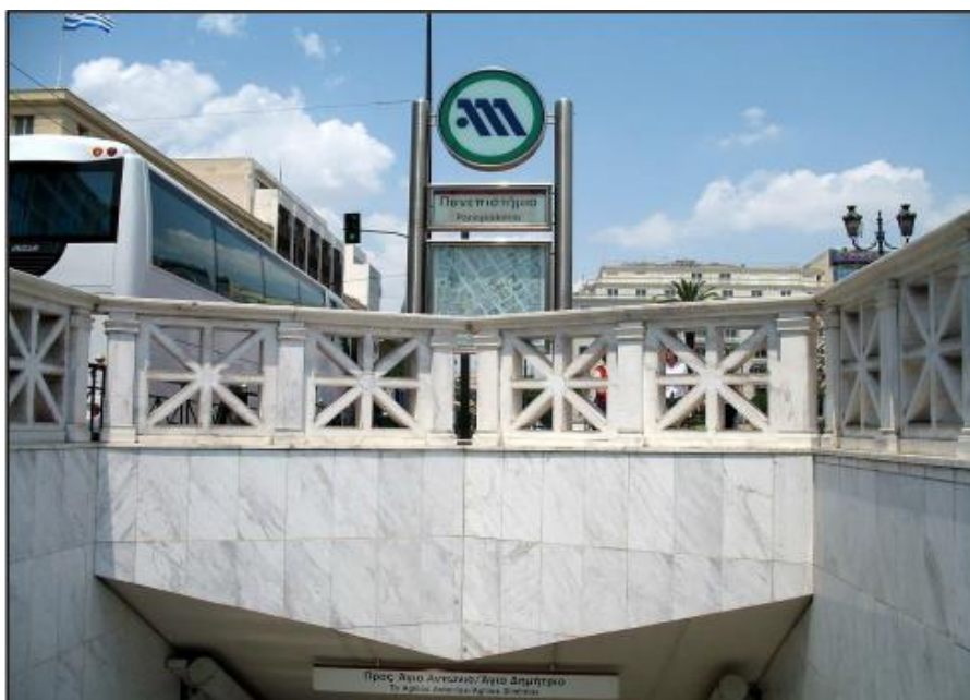
Εικ. 2.7. Ορθομαρμάρωση με μάρμαρο Βόλακα στην είσοδο του σταθμού μετρό Πανεπιστήμιο.
