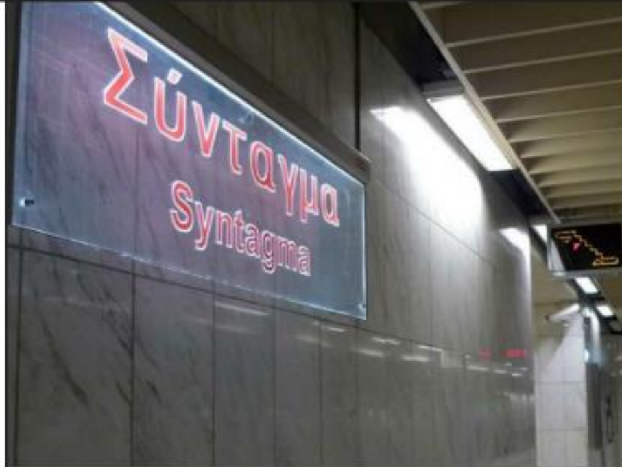
Σύνταγμα – Σταθμός Μετρό: Ορθομαρμάρωση με μάρμαρο Βώλακα.
