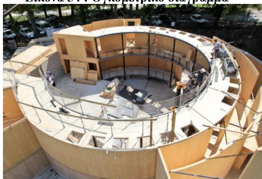
Εικόνα 55 : Κατασκευή του θεάτρου με κυρτά πάνελ 119
