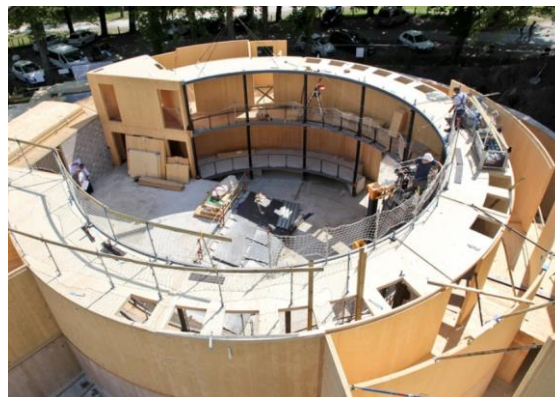
Εικόνα 43 : Ανέγερση Ξύλινης Ανωδομής 106
