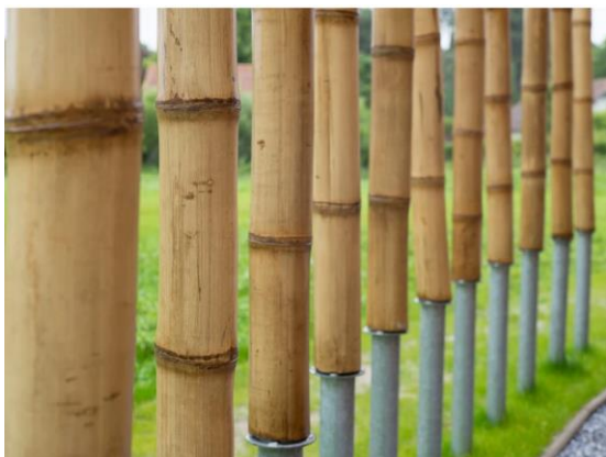
Εικόνα 57 : Στύλοι Μπαμπού σε Χαλύβδινα Θεμέλια 121
