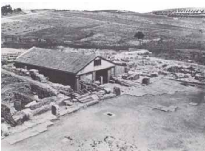
Εικ. 93: Η δεύτερη στέγη πάνω από την Αίθουσα του Θρόνου, νοτιοανατολική άποψη, 1904. Η προηγούμενη επίπεδη στέγη αντικαταστάθηκε από μια πιο μόνιμη δομή με κεκλιμένη στέγη που υποστηρίζεται από μεταλλικές δοκούς. Το πατάρι ήταν εξοπλισμένο με ράφια και χρησίμευε ως μουσείο.
