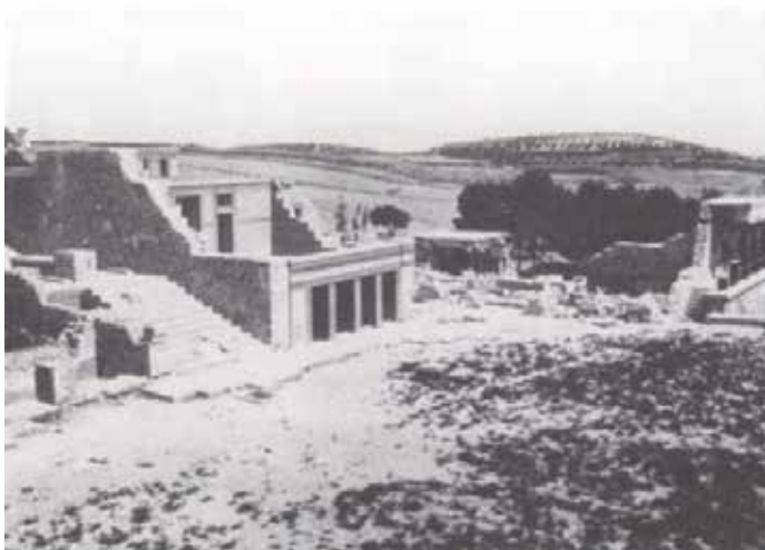
Εικ. 94: Η τελική μορφή που πήρε η Αίθουσα του θρόνου, νοτιοανατολική άποψη, 1930. Η δεύτερη στέγαση για την Αίθουσα του Θρόνου αντικαταστάθηκε από μια ογκώδη κατασκευή από οπλισμένο σκυρόδεμα που βασίστηκε στην ιδέα του Evans για το αρχικό μινωικό κτήριο. Αυτό περιλάμβανε την κατασκευή του εντελώς σύγχρονου πάνω ορόφου, που χρησιμοποιήθηκε ως «πινακοθήκη» για αντίγραφα τοιχογραφιών από διάφορα μέρη του ανακτόρου.
