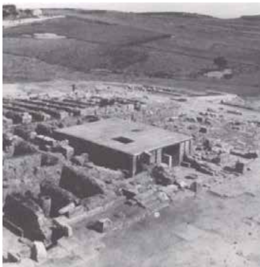
Εικ. 92: Η πρώτη στέγη πάνω από την Αίθουσα του Θρόνου, νοτιοανατολική άποψη, 1901. Η επίπεδη στέγη στηριζόταν σε πλίνθινα υποστυλώματα κατά μήκος των πλευρών και σε εσωτερικές κολώνες που ήταν κατασκευασμένες από ξύλο, καλυμμένες με γύψο και βαμμένες. Οι εσωτερικές κολώνες τοποθετήθηκαν στις θέσεις που καταλάμβαναν οι αρχικοί μινωικοί κίονες. Για προστασία, ο χώρος ήταν εφοδιασμένος με σιδερένια κιγκλιδώματα και σιδερένιες πύλες. Η προστατευτική κατασκευή κάλυπτε μόνο την αίθουσα του θρόνου ενώ το μεγαλύτερο μέρος της εκτεταμένης ανασκαφής ήταν εκτεθειμένο στις καιρικές συνθήκες.
