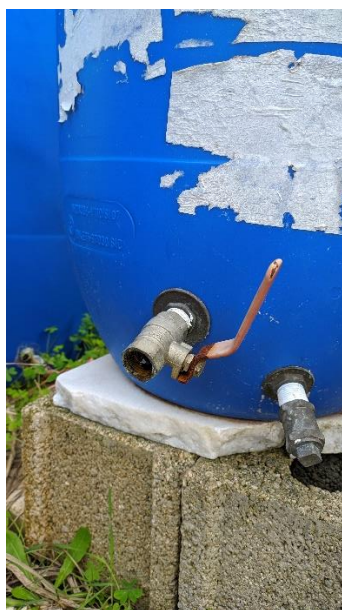
Εικόνα 3.3 Η βρύση που τοποθετήθηκε στη μονάδα με ύψος 60 εκατοστά.
