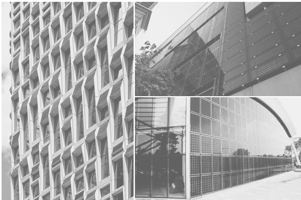
εικόνες 11,12,13: χρήση φωτοβολταϊκών στην πρόσοψη κτιρίου
