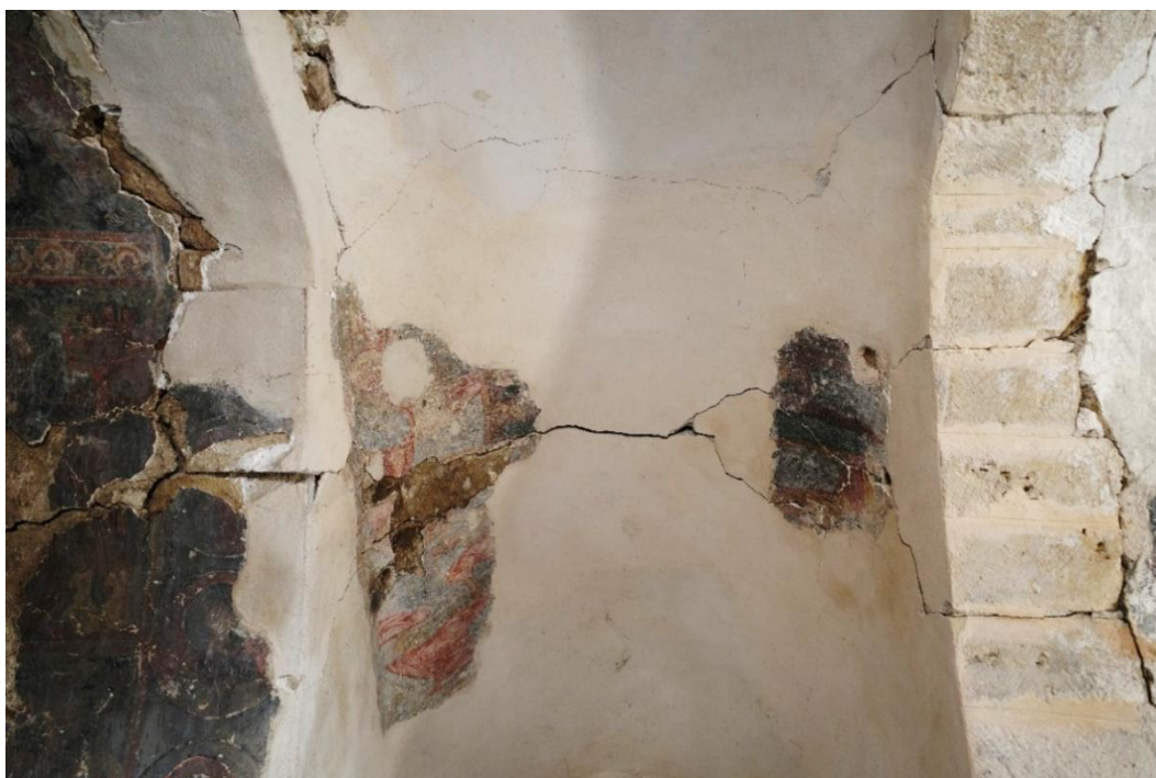
Εικ. 01.20. Η ένωση των κεραίων (θόλων), μετά τον σεισμό.
