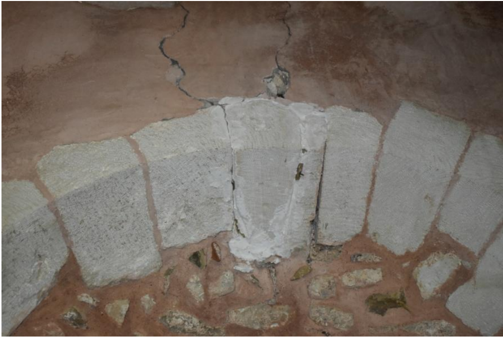
Εικ. 13.17. Το κλειδί του τόξου του τεταρτοσφαιρίου.
