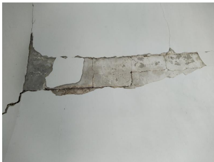
Εικ. 15.13. Θολίτες που αποκαλύφθηκαν μετά τον σεισμό.
