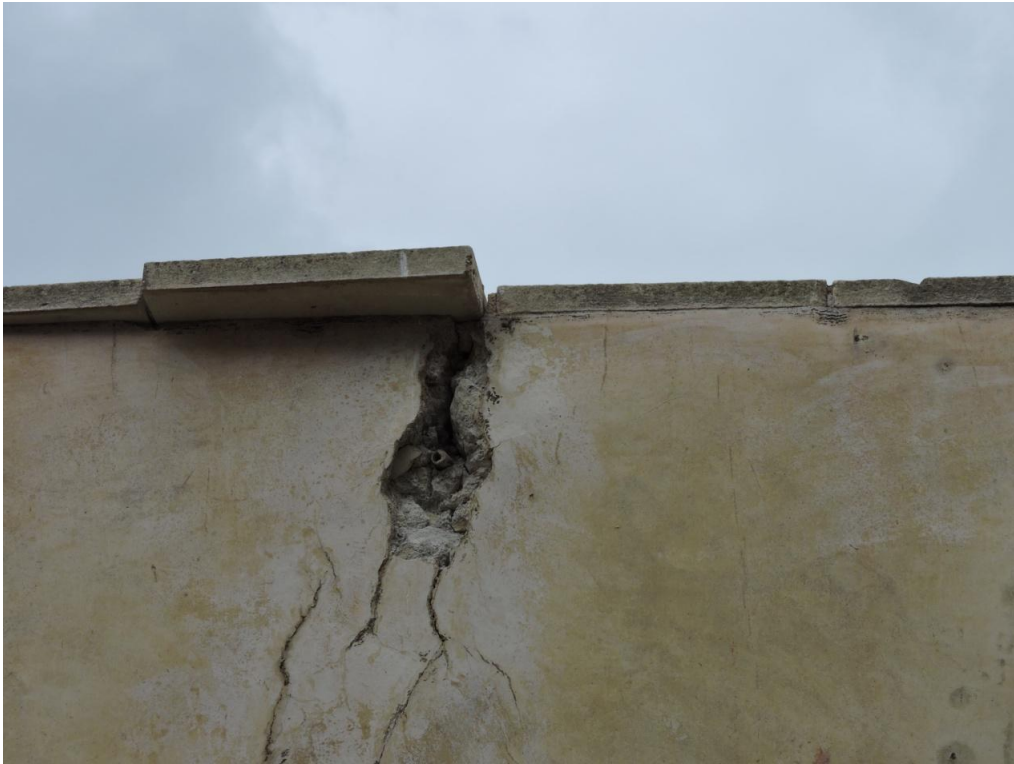
Εικ. 09.17. Νότιος τοίχος, μετά τον σεισμό η παλαιά (αποκατεστημένη) ρωγμή.
