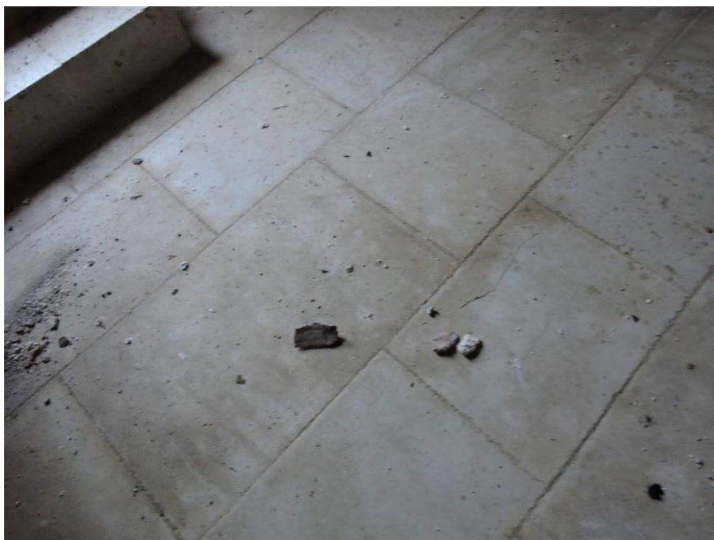
Εικ. 13.21. Απώλεια επιχρίσματος, μετά τον σεισμό.
