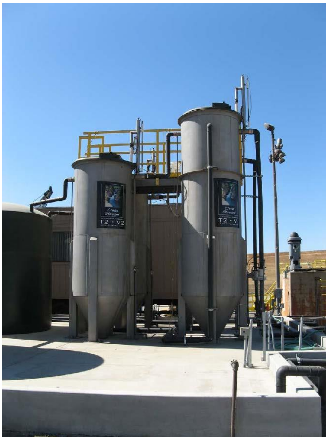
Εικόνα 3.8: Βιολογικό φίλτρο με χαλίκια ως υλικό πλήρωσης (Derlab.tuc, 2024)
