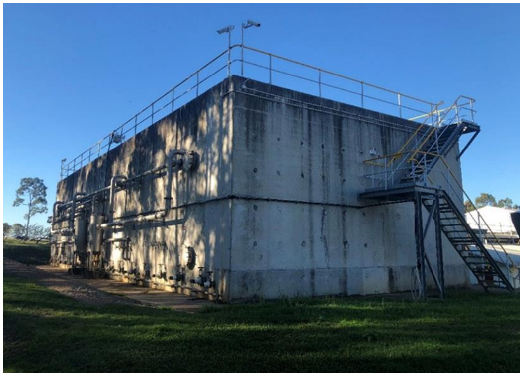
Εικόνα 3.10: Αντιδραστήρας τύπου UASB εγκατεστημένος σε ΕΕΛ της Αυστραλίας (Jensen et al., 2022)
