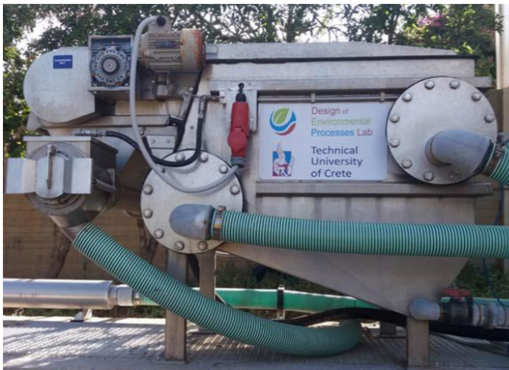
Εικόνα 3.4: Σύστημα μικροκοσκίνισης εγκατεστημένο σε ΕΕΛ του Ρεθύμνου, Κρήτης (Μάναλη, 2023)
