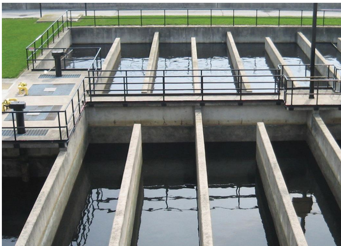
Εικόνα 1.10: Δεξαμενή χλωρίωσης (EnviroMix, 2024)
