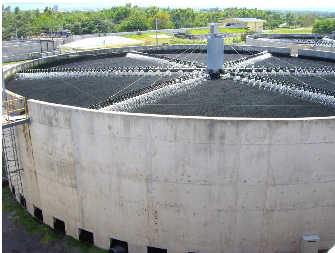
Εικόνα 3.7: Trickling Filter εγκατεστημένο σε ΕΕΛ (EXPOVAL, 2024)
