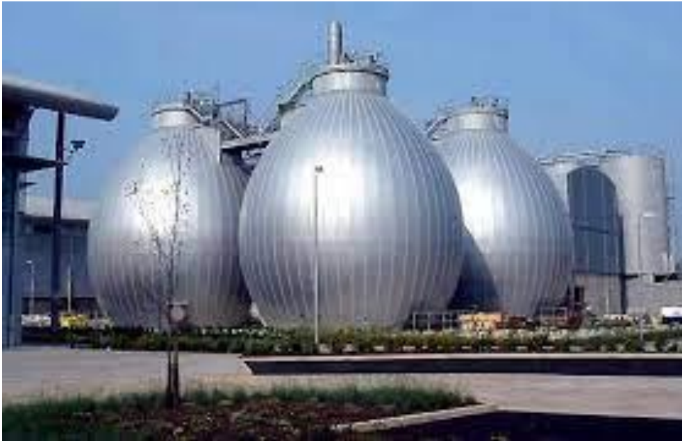
Εικόνα 1.9: Σύστημα αναερόβιων χωνευτών σε ΕΕΛ (WATER TECHNOLOGY, 2024).
