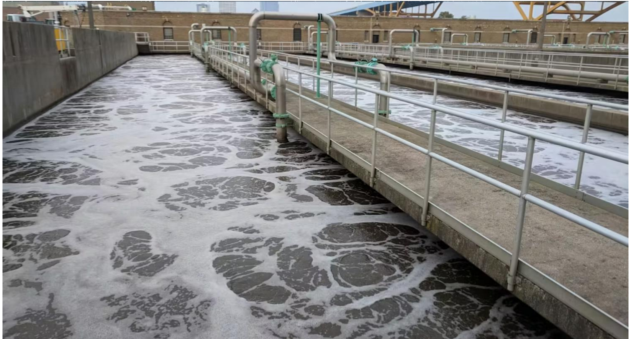
Εικόνα 1.5: Δεξαμενή αερισμού σε ΕΕΛ στις Η.Π.Α (WASTEWATERDIGEST, 2024)
