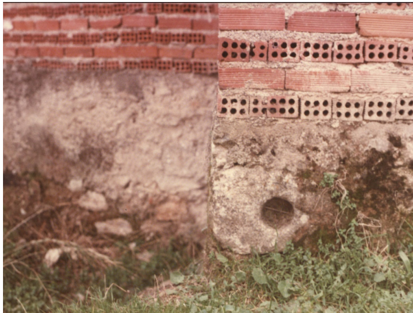
92. Βάση Αγίου Νικολάου κατά την κατασκευή - Διακρίνεται σπόνδυλος κίονα
