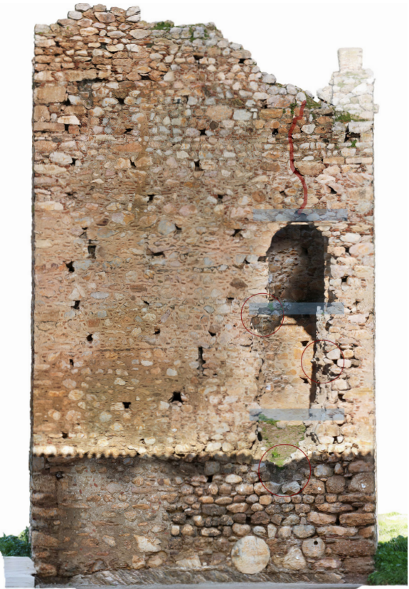
115. Μηχανικές αστοχίες στην Νότια όψη (Στην κάτω αριστερή γωνία διακρίνεται το αποτύπωμα του κονιάματος του προαναφερθέν οστεοφυλακίου)
