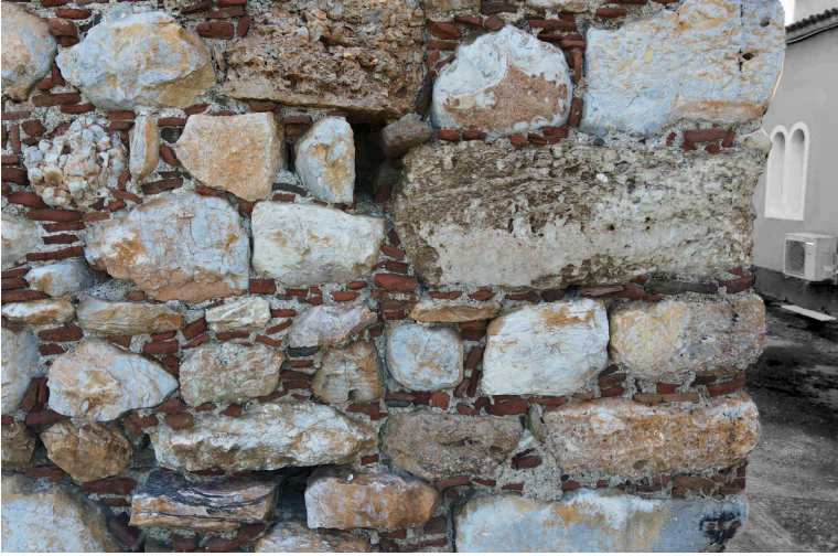
100. Δείγμα της τοιχοποιίας Διακρίνεται η διαφορά μεγέθους μεταξύ γωνιόλιθων και υπόλοιπων λίθων
