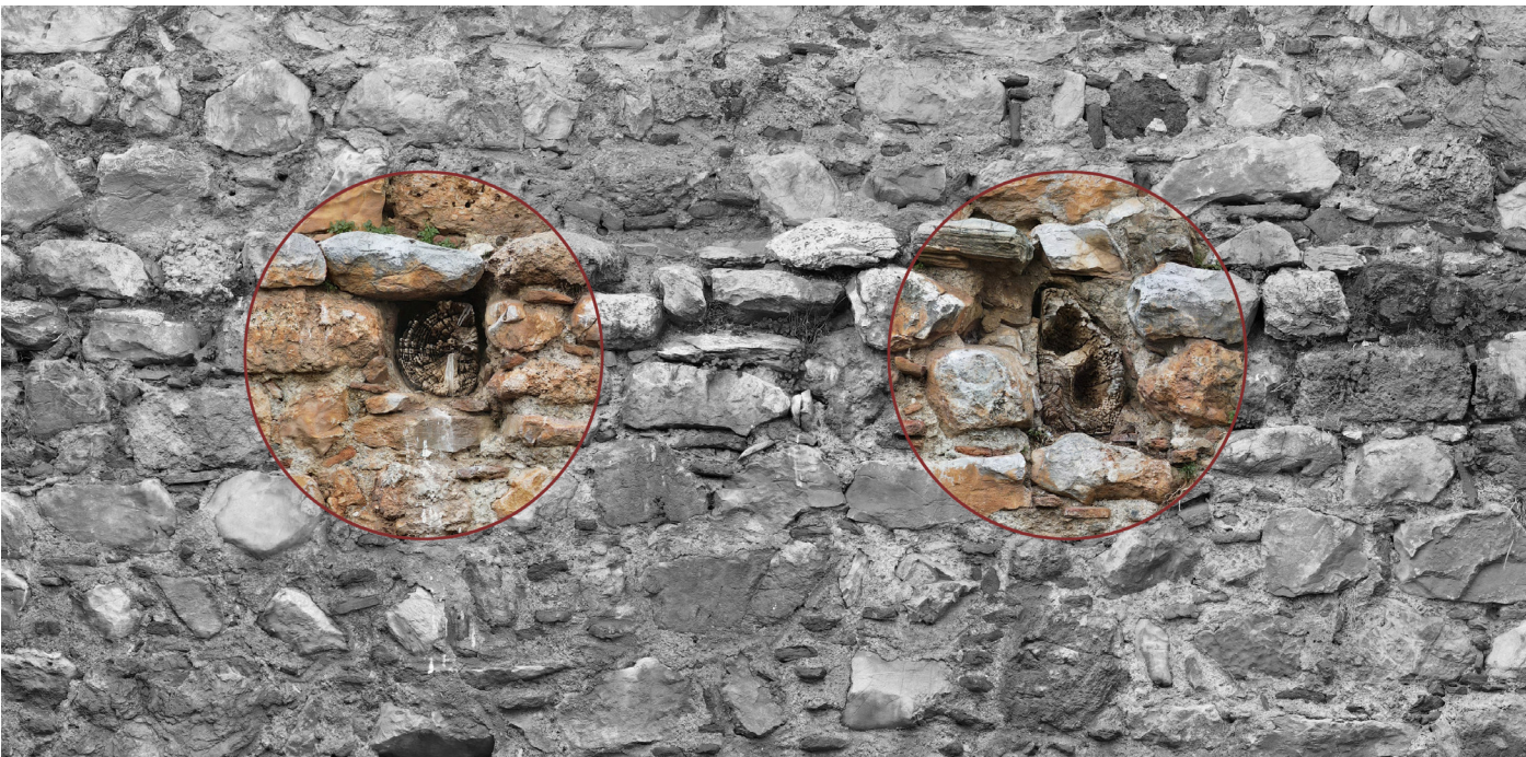
127. Τα αποτυπώματα των τσιμεντοκονιαμάτων που θα απομακρυνθούν (Ανατολική όψη)
