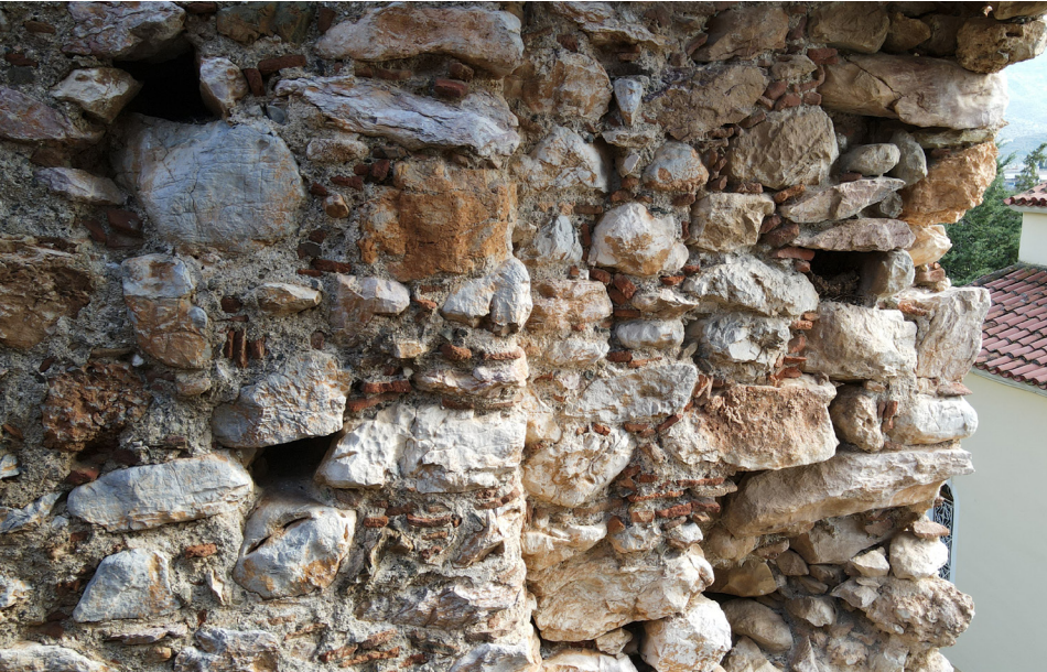
86. Εσωτερική λήψη της θέσης της θύρας. Διακρίνεται η υποχώρηση της τοιχοποιίας και η οπή με την θέση της ξύλινης αμπάρας
