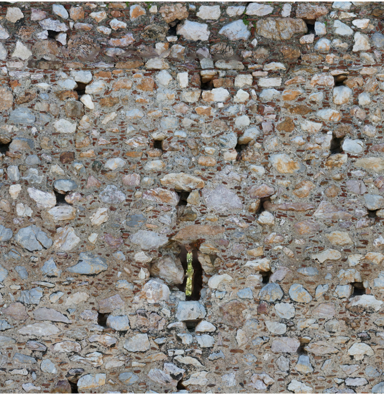
104. Διάταξη σκαλότρυπων - Ανατολική όψη
