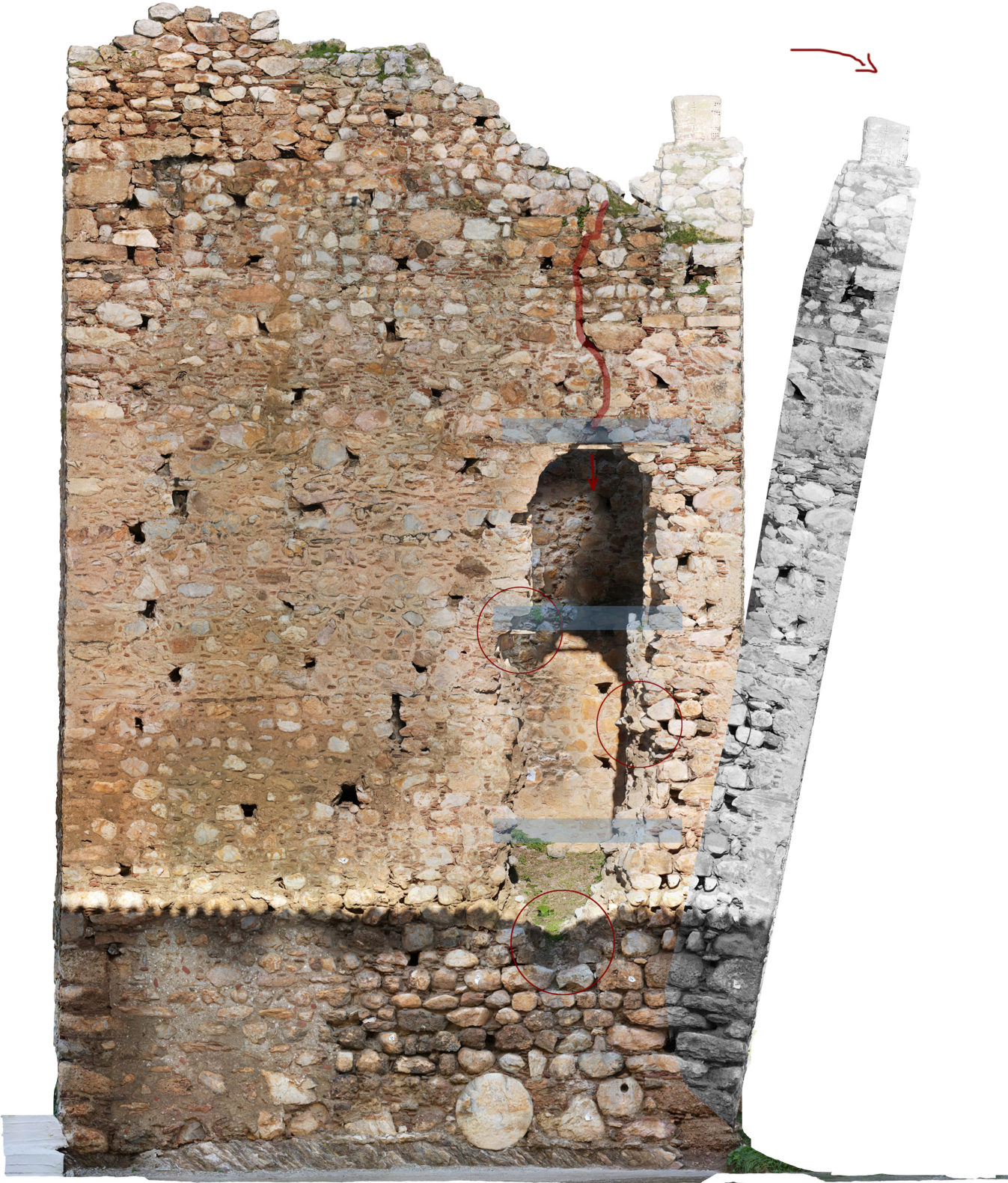
118, Απουσία δυσκαμψίας - Παραμόρφωση ανατολικής τοιχοποιίας
