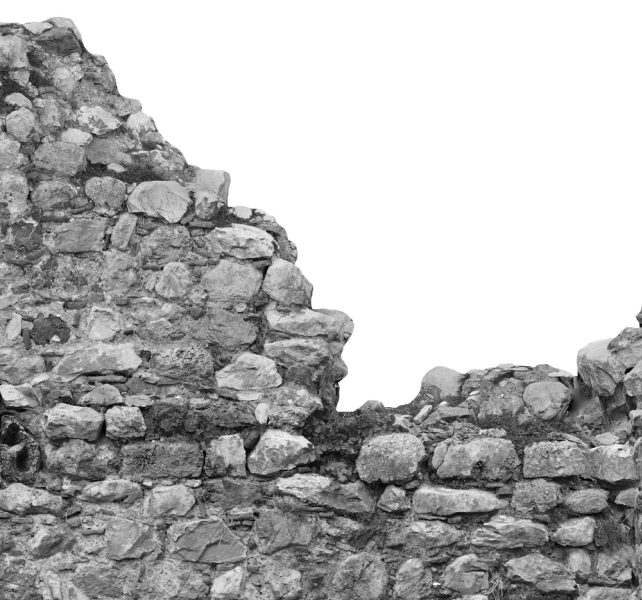
121. Σταδιακή καταστροφή της ανωδομής λόγω της έκθεσης των τοιχοποιιών στις καιρικές συνθήκες
