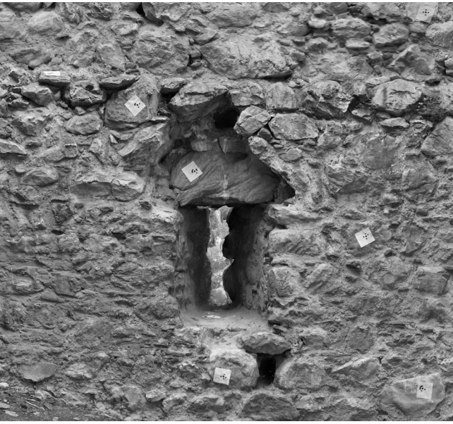
123. Διαρπαγή λίθινου υπέρθυρου σε άνοιγμα στο εσωτερικό της ανατολικής τοιχοποιίας στην Στάθμη 1
