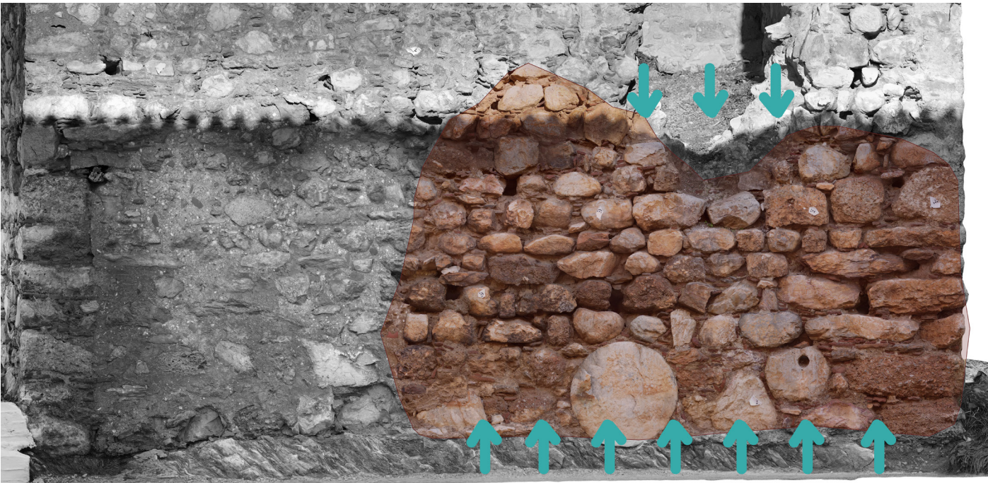
119. Νότια όψη - Απώλεια συνδετικού κονιάματος από ανοδική υγρασία και εισχώρηση νερού στο άνω τμήμα
