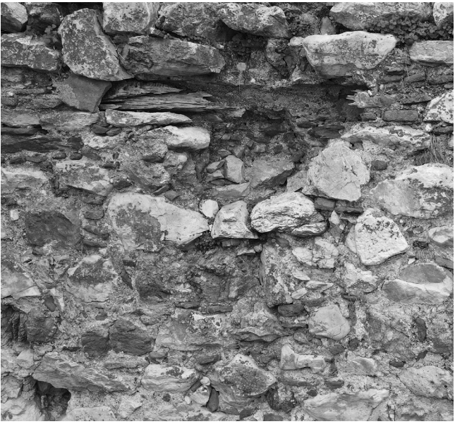
122. Υπολείμματα ξύλινων ιμαντώσεων (ξύλοδεσιές) - Ασυνέχεια
