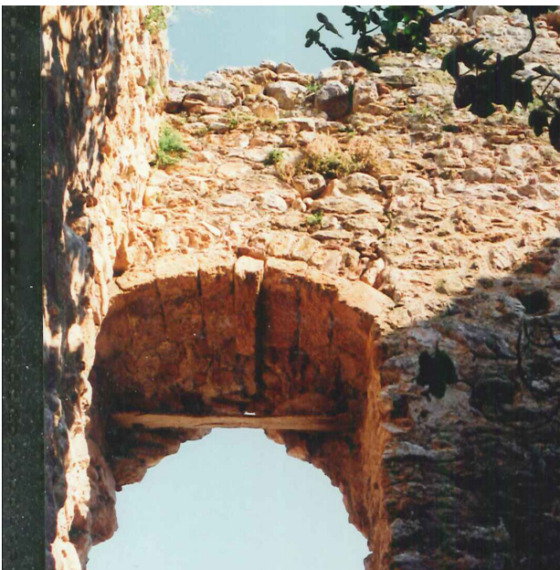
78. . Εσωτερική λήψη της θέσης της θύρας. Διακρίνονται το λίθινο υπέρθυρο και το ξύλινο ανώφλι με την οπή του στροφέα
