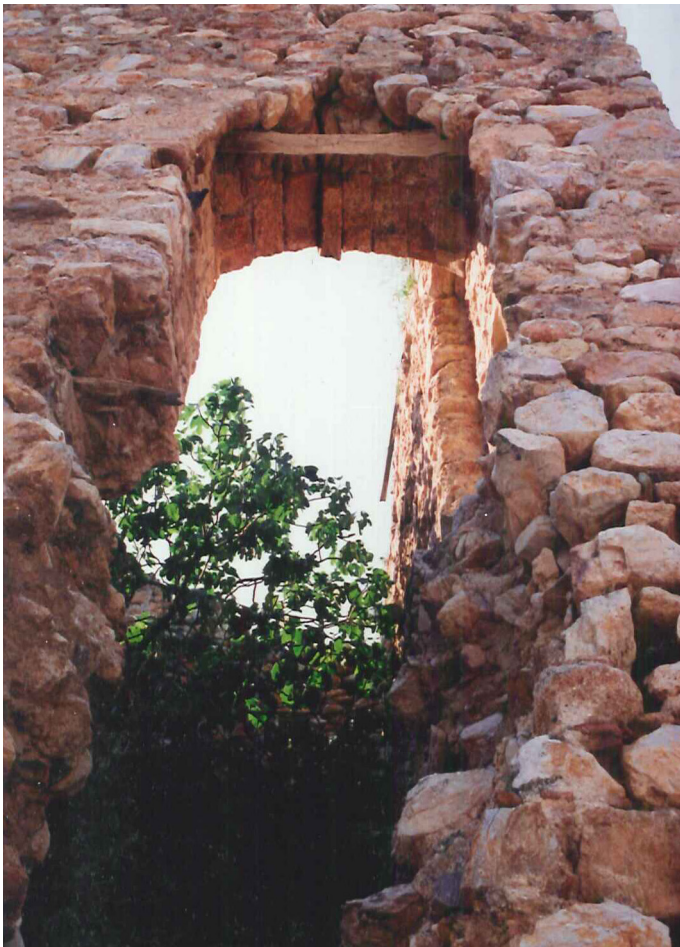
79, 80, 81. . Θέσης της θύρας. Διακρίνονται το λίθινο υπέρθυρο, το ξύλινο ανώφλι και το ξύλινο στοιχείο στην θέση του κατωφλιού.
