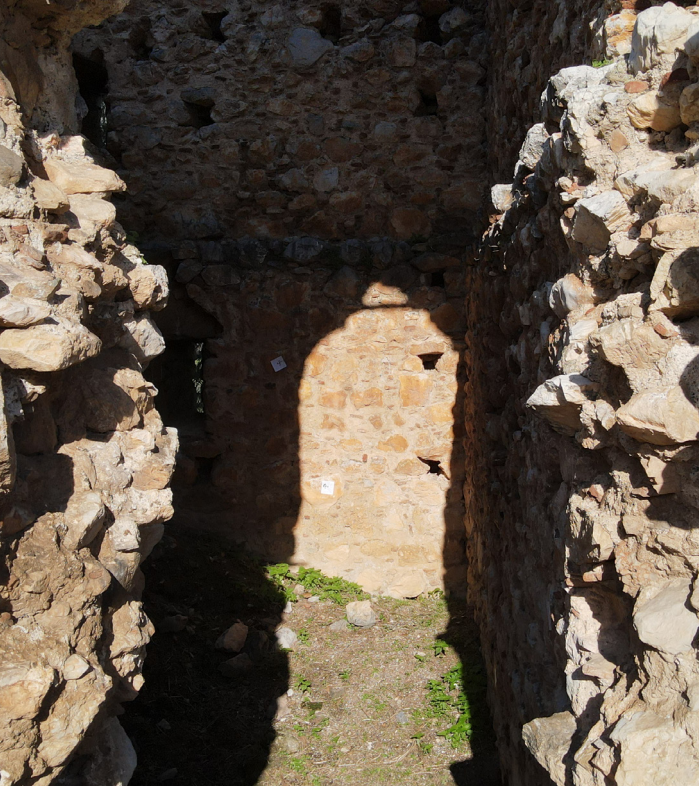
111. Απώλεια υλικού στην λιθοδομή της Νότια όψης
