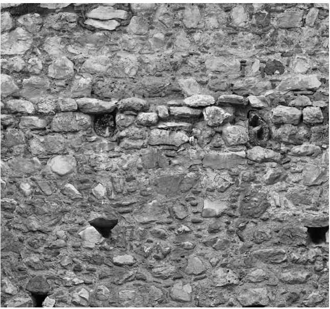
120. Πλήρης καταστροφή των ξύλινων δοκών των πατωμάτων - Υπολείμματα στις δοκοθήκες
