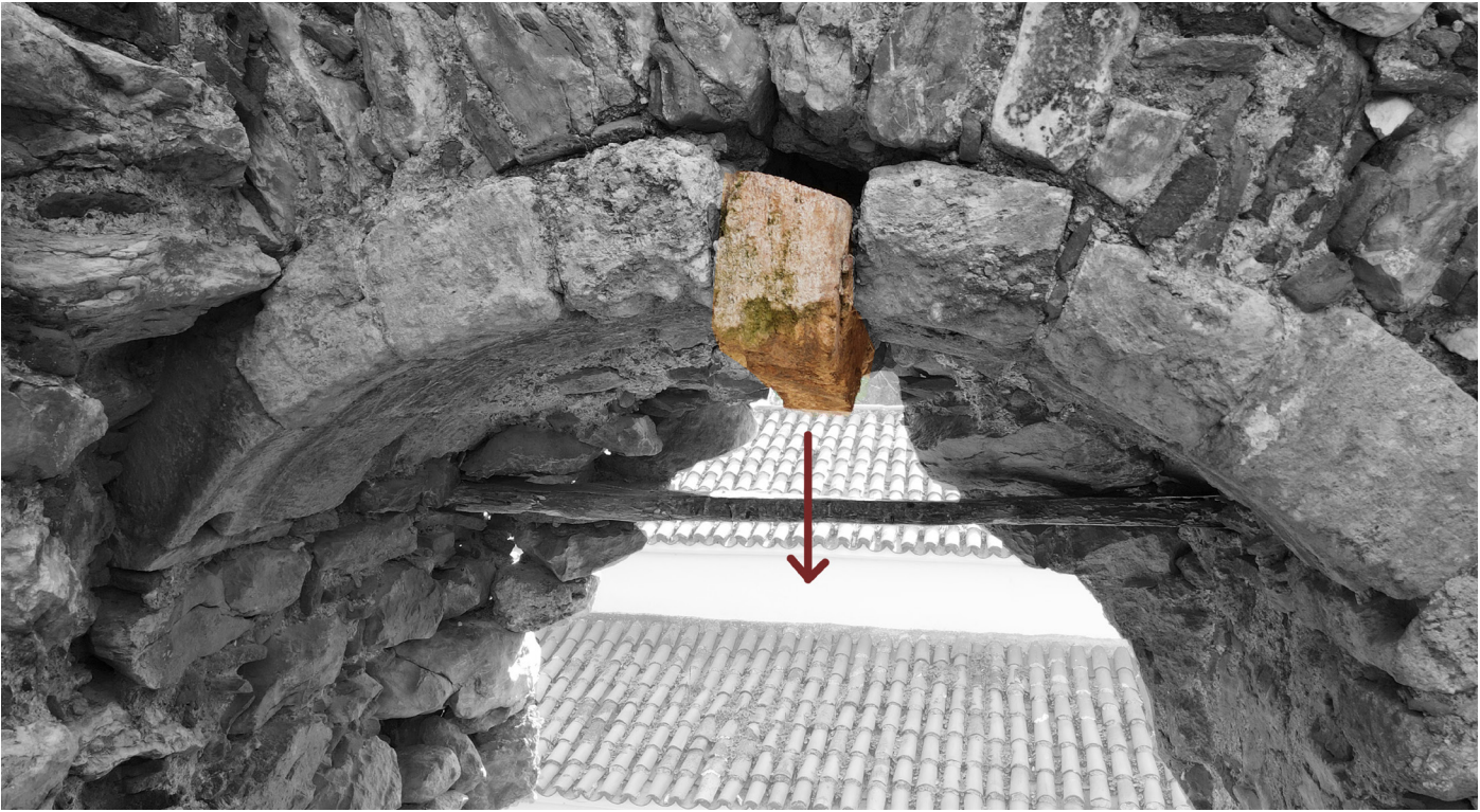
117. Αποδιοργάνωση Τόξου - Μετακίνηση θολίτη λόγω αποσύνδεσης τοιχοποιιών
