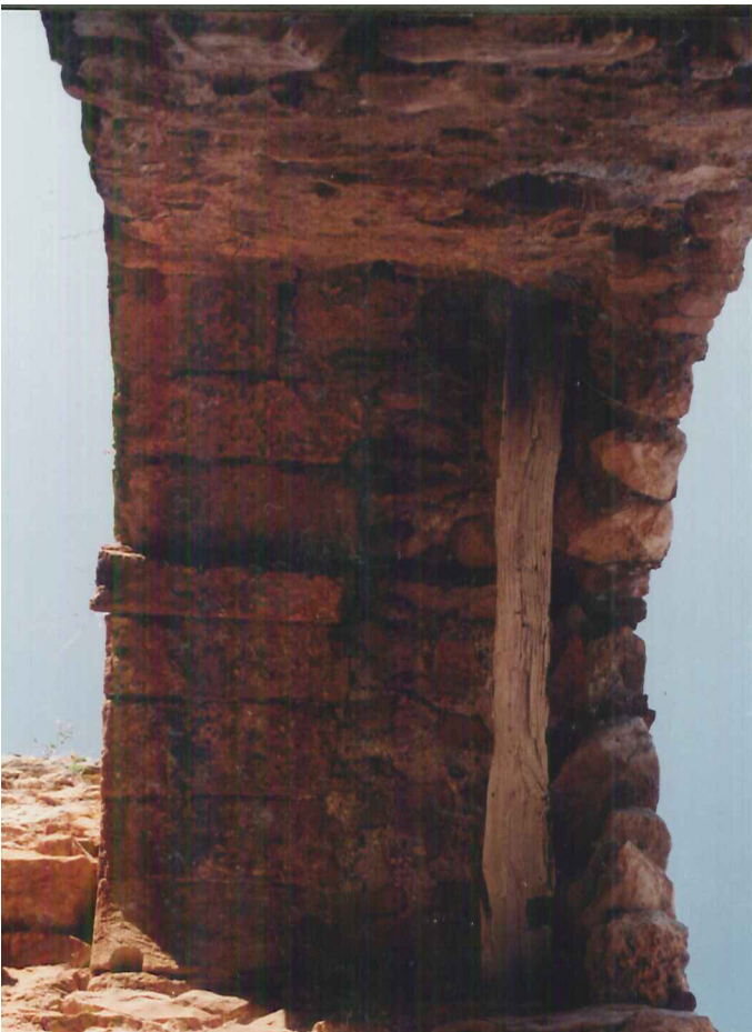
79, 80, 81. . Θέσης της θύρας. Διακρίνονται το λίθινο υπέρθυρο, το ξύλινο ανώφλι και το ξύλινο στοιχείο στην θέση του κατωφλιού.
