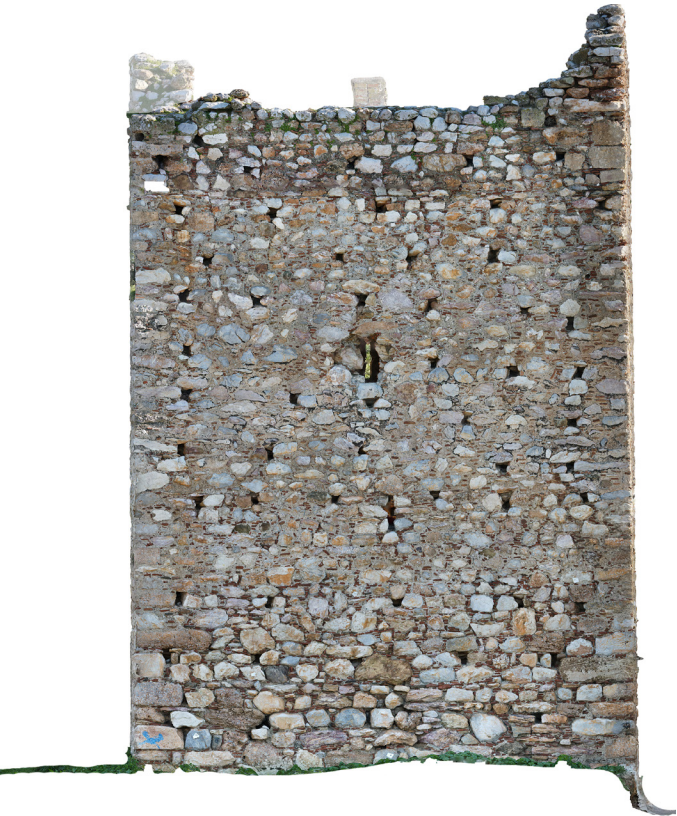
112. Ρηγματώσεις στη ανατολική όψη (Στην κάτω αριστερή γωνία διακρίνεται τμήμα του τσιμεντοκονιάματος που αντιστοιχεί στο αποτύπωμα του προϋπάρχοντος προσκτίσματος)
