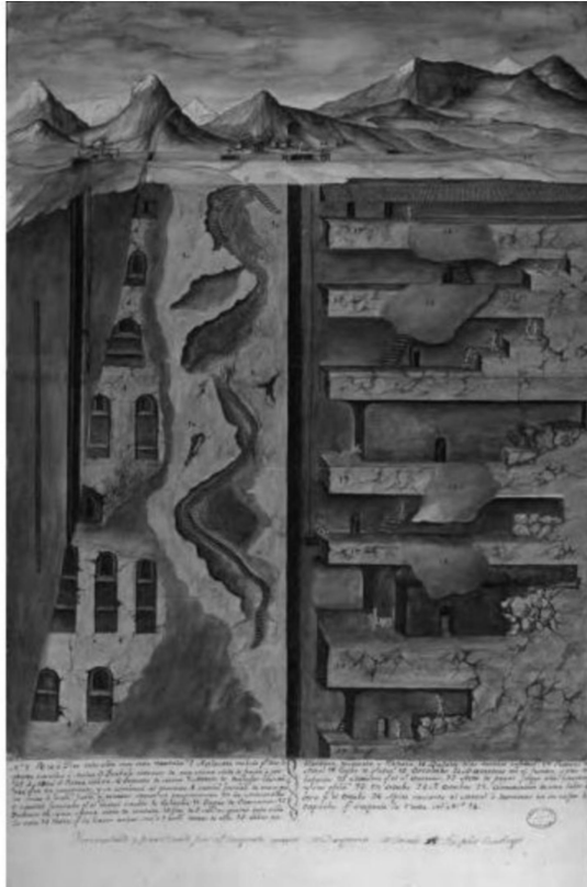
Εικόνα 5.1: Το σχέδιο της νέας μεθόδου λειτουργίας των ορυχείων. Gaspar de Sabugo, Plano del nuevo método de trabajar las minas (Scott, 2015).
