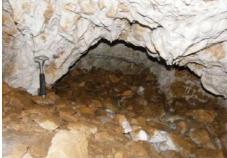
Εικόνα 2.4: Πλήρωση τμήματος της στοάς παλαιότερης εκμετάλλευσης με στείρο υλικό από την εξόρυξη ( Βαξεβανόπουλος, 2017 ).
