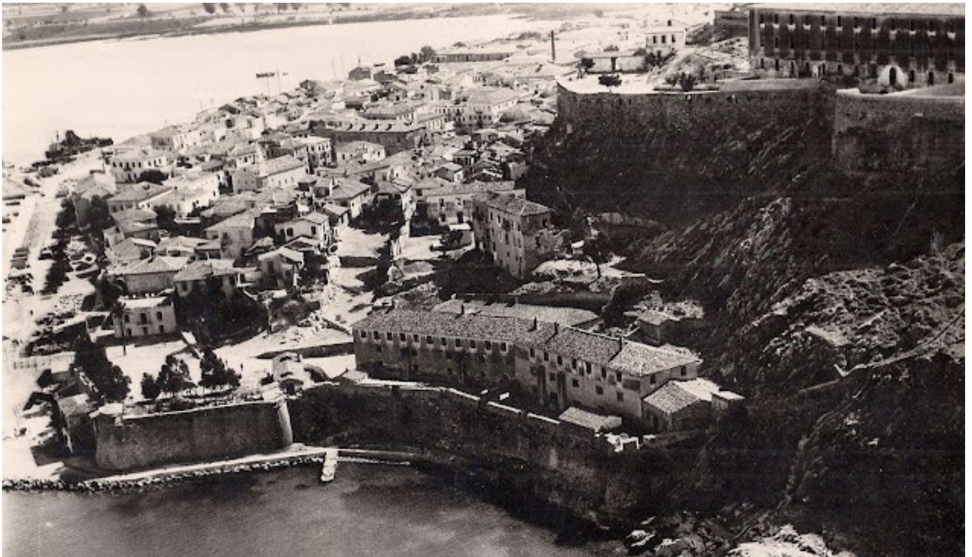
Εικόνα 213 - Πανοραμική άποψη περιοχής (argolikiviniiothiki.gr/.)
