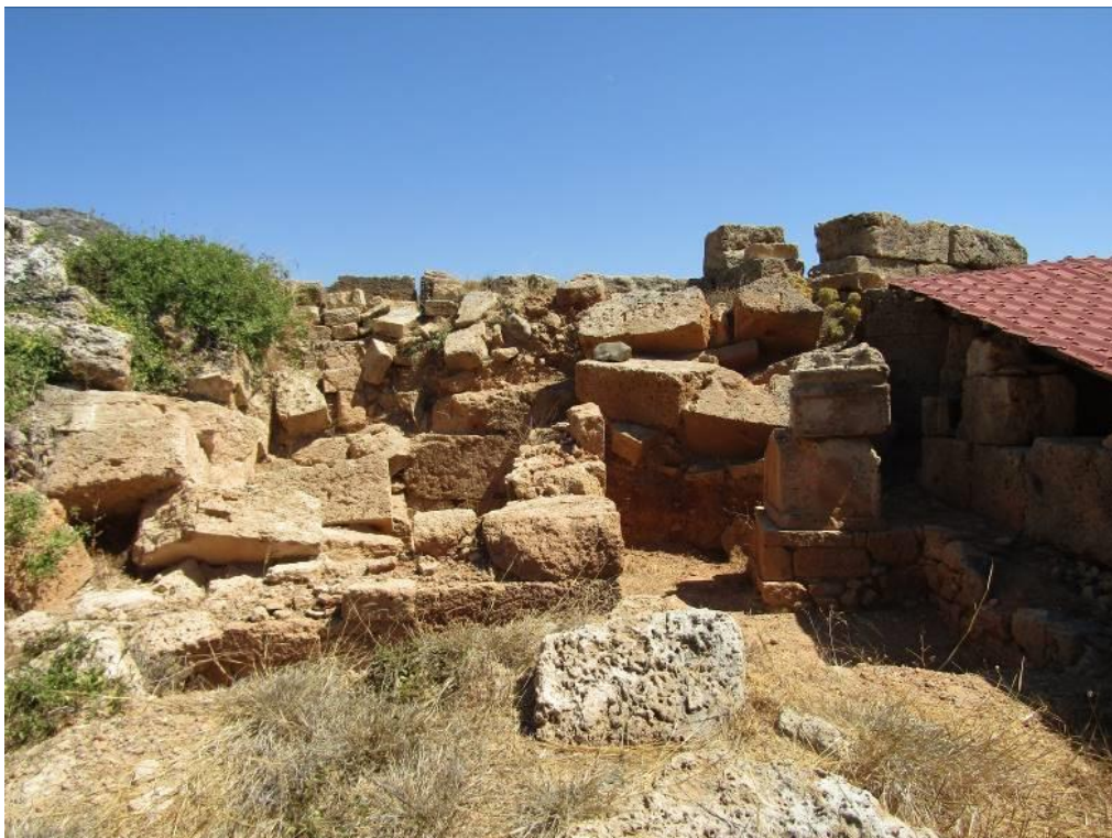
Εικ.86: Η περιοχή στο Β τμήμα του πύργου και στην ΒΔ παρειά του ΒΑ μεταπυργίου μετά από το τέλος των εργασιών (Πηγή: προσωπικό αρχείο).
