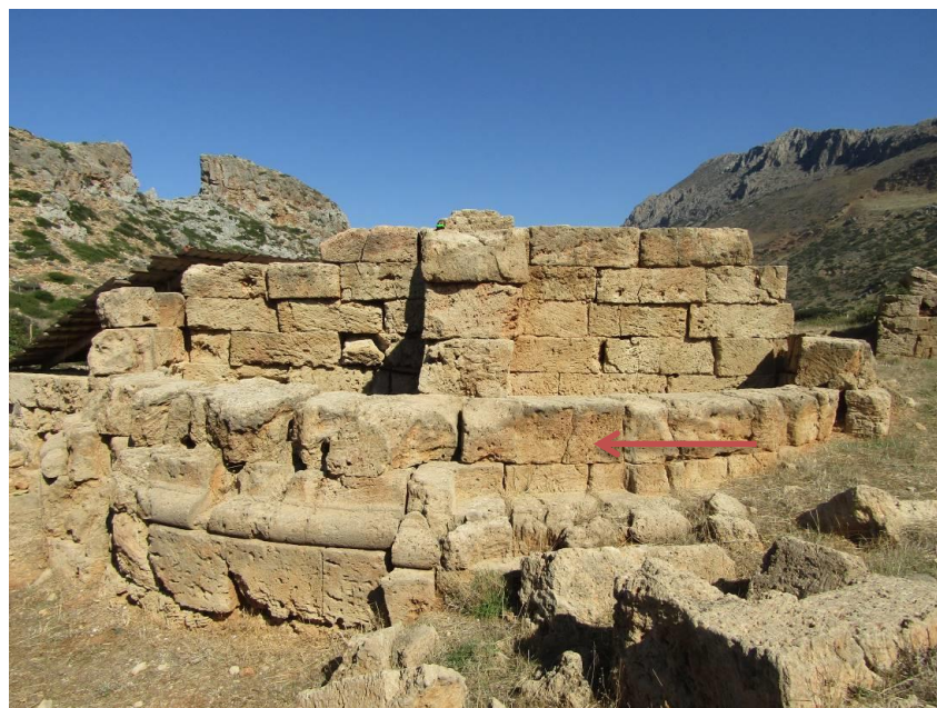
Εικ.18: Όταν ο αρμός βρίσκεται χαμηλά τα μέτωπα των λίθων υποχωρούν στο εσωτερικό της τοιχοποιίας ως αφανείς έδρες (Πηγή: προσωπικό αρχείο).
