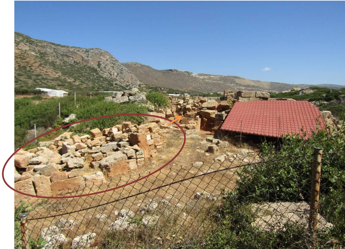
Εικ.87: Όσοι λίθοι αφαιρέθηκαν από τις εργασίες στο ΒΔ μέρος του πύργου τακτοποιήθηκαν στα ΒΑ του μνημείου (Πηγή: προσωπικό αρχείο).
