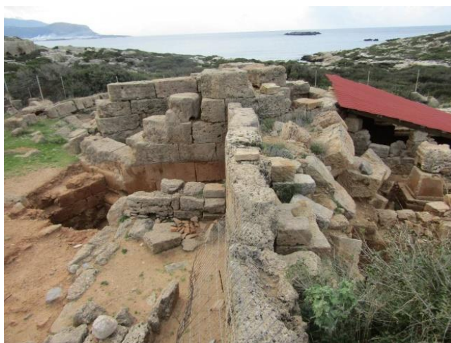
Εικ.33: Το ΒΑ μεταπύργιο στην επαφή του με τον κυκλικό πύργο (Πηγή: προσωπικό αρχείο).
