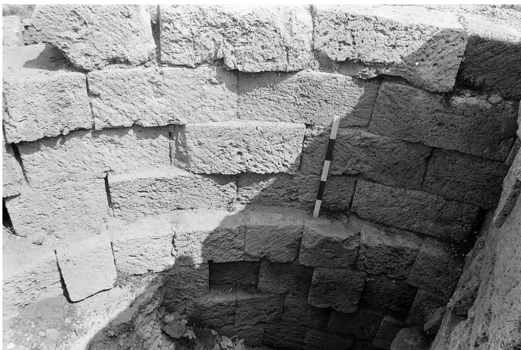
Εικ.42: Η έσω παρειά του συμπαγούς μέρους του κυκλικού πύργου. Φαίνεται η σχετικά επιμελημένη κατεργασία των οπίσθιων εδρών των λίθων, οι αυξομειώσεις στο μήκος των ουραίων τμημάτων τους, ενώ ξεχωρίζει ο δόμος της ανώτερης στρώσης της βάσης, με μικρότερες διαφορές στο μήκος των λίθων (Πηγή: Ανασκαφή Φαλάσαρνας 1987. Ευγενική παραχώρηση της κ. Χατζηδάκη).
