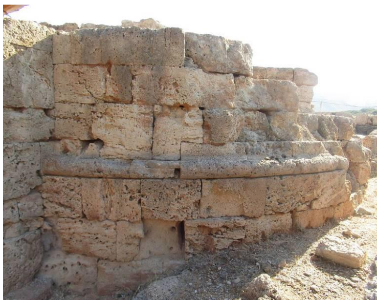
Εικ.13: Το ΝΔ μέρος του κυκλικού πύργου. Φαίνεται η ανύψωση του βράχου και η μείωση της βάσης κατά δύο δόμους (Πηγή: προσωπικό αρχείο).
