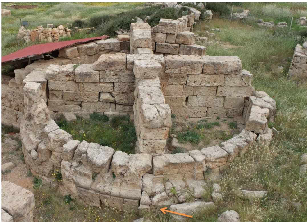
Εικ.83: Το σημείο όπου προτείνεται η απόληξη των αγωγών από το ΒΔ και ΝΔ τεταρτημόριο. Οι λίθοι βρίσκονται σε θραυσματική κατάσταση ή έχουν ολισθήσει. Κατά την ανάταξή τους θα εισέλθουν μέσω της τοιχοποιίας οι δύο αγωγοί.
