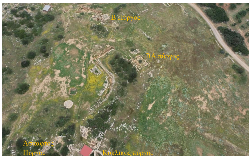
Εικ.11: Η λιμενική οχύρωση της αρχαίας Φαλάσαρνας. Διακρίνονται οι δύο τετράπλευροι πύργοι (ο Β και ο ΒΑ) και στο κάτω μέρος φαίνεται ο κυκλικός πύργος. Εντός της λιμενικής οχύρωσης βρισκόταν η προκουμιά (Πηγή: λήψη με UAV από τον Κλήμη Ασλανίδη).
