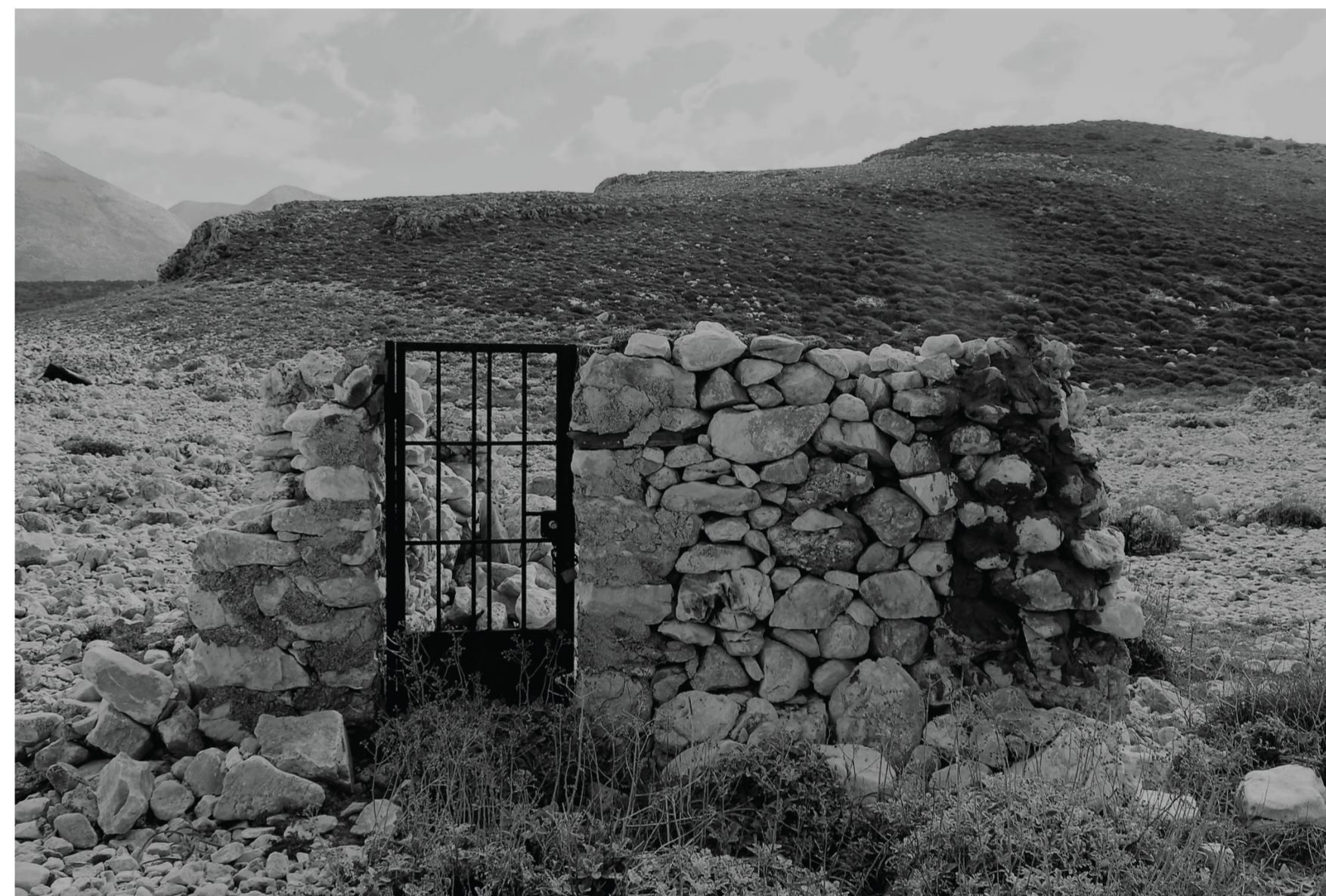
Σπιτακούλα: κτίσμα στην περιοχή των αλυκών
