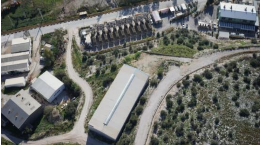
Εικόνα 4.6 : Αεροφωτογραφία εγκατάστασης παραγωγής βιοαερίου και ηλεκτρικής ενέργειας Δυτικής Αττικής.
