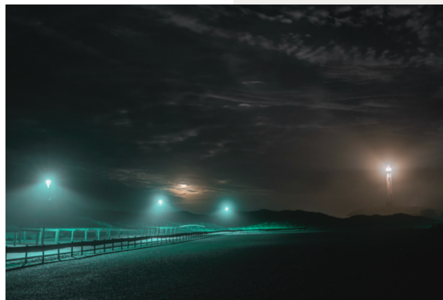
Εικόνα 46: Τεχνολογία φωτισμού LED με φάσμα (γαλαζοπράσινο φως) φιλικό προς τα πουλιά και τα νυκτόβια ζώα
