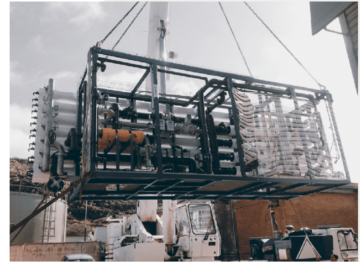
Εικόνα 33: Παράδοση του νέου συστήματος αφαλάτωσης αντιστροφής όσμωσης (Μάρτιος 2015)
