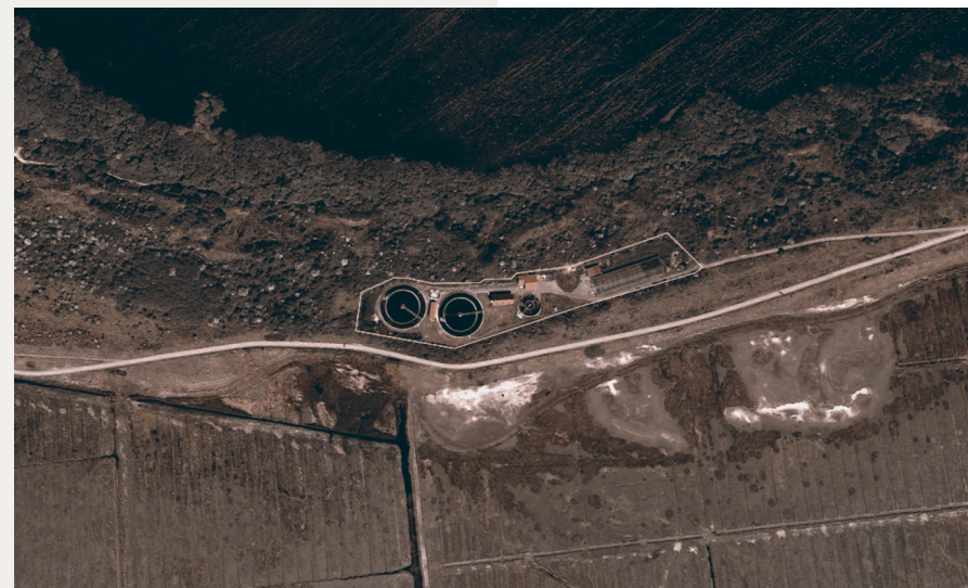
Εικόνα 2: Μονάδα επεξεργασίας λυμάτων
