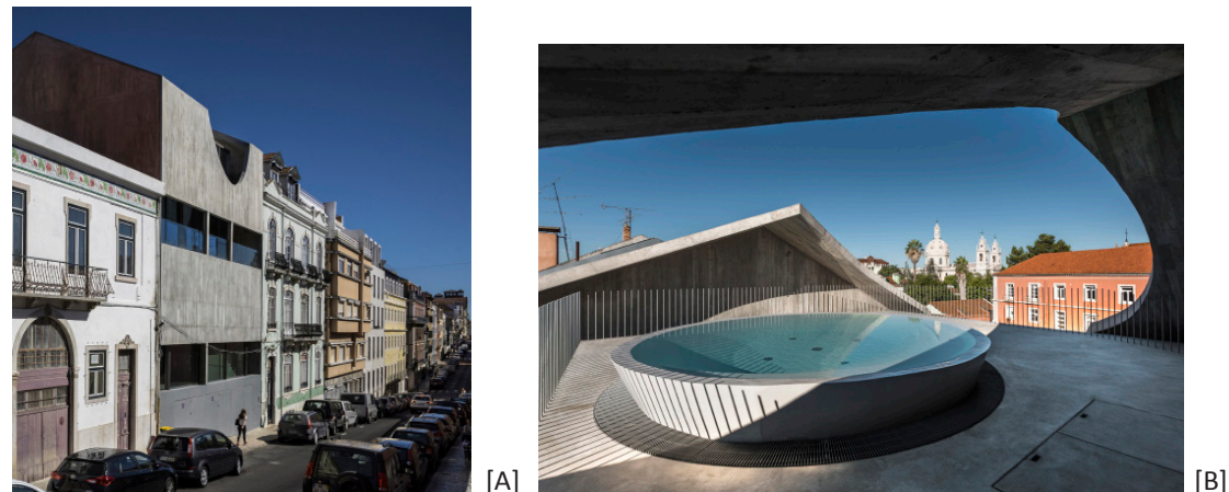
[A]: Ένταξη στην κλίμακα του αστικού ιστού [B]: Οπτική σύνδεση με τοπόσημα της πόλης μέσω της παραβολικής στέγης
