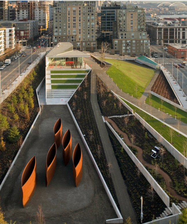
φωτ. 3.3.3 Πανοραμική άποψη της ανάπτυξης (με κόκκινο η κύρια πορεία σχήματος "Z") φωτ. 3.3.4 Πανοραμική άποψη του υπαίθριου αμφιθεάτρου με τα γλυπτά.
