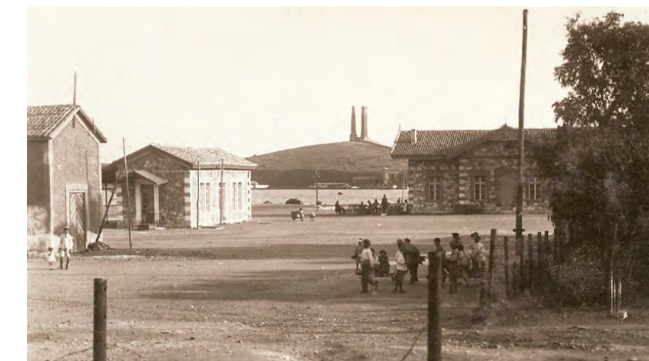
Σταθμός και Καφενείο Σιδηροδρόμων Αττικής
