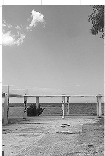
στέγαστρο εξωτερικού μπαρ
