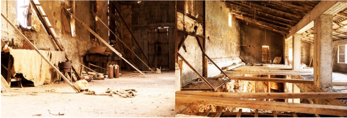
Εικόνα Β. 24 Αρχιτεκτονικά Στοιχεία 3. Φωτογραφίες: Ομάδα Μελέτης.
