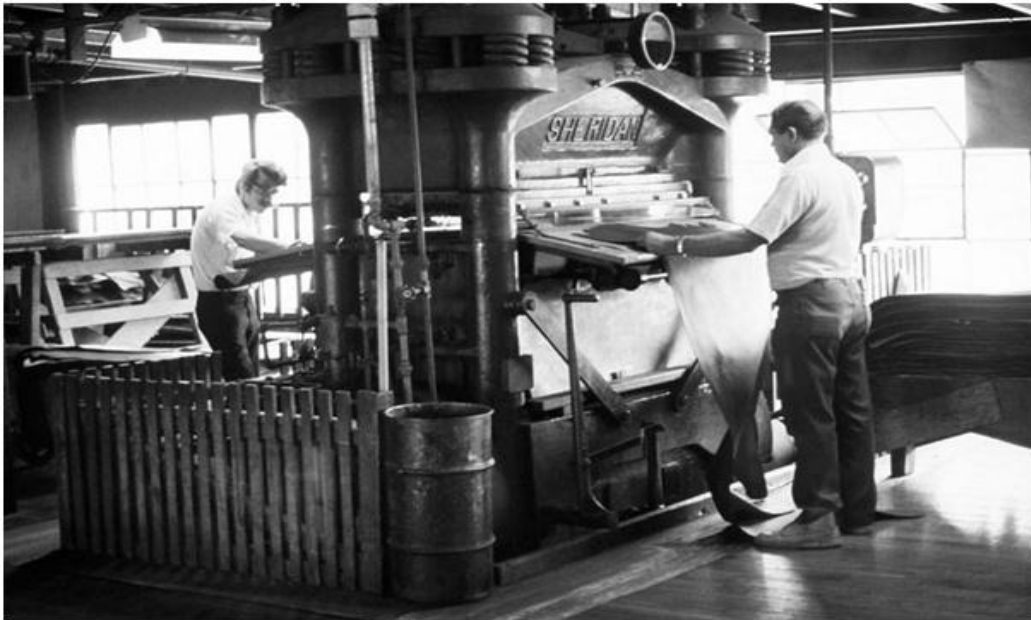
Εικόνα Α.36 Ισοπάχυνση δέρματος λίγο πριν το τέλος της επεξεργασίας. 1975. http://www.leathersmith.com/california-historical-tannery/ , David Ball California Historical Tannery Archive
