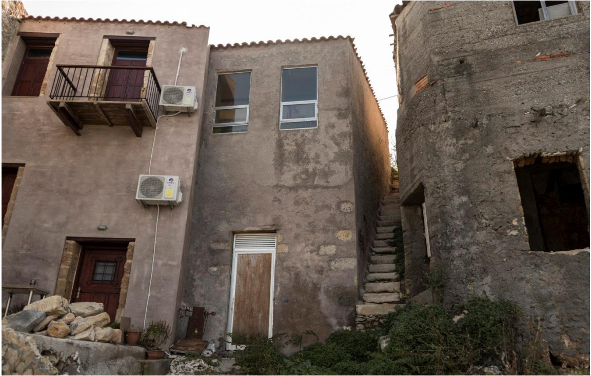
Εικόνα Β.3 Αποκατεστημένα κτίρια. Φωτογραφία: Ομάδα Μελέτης.
