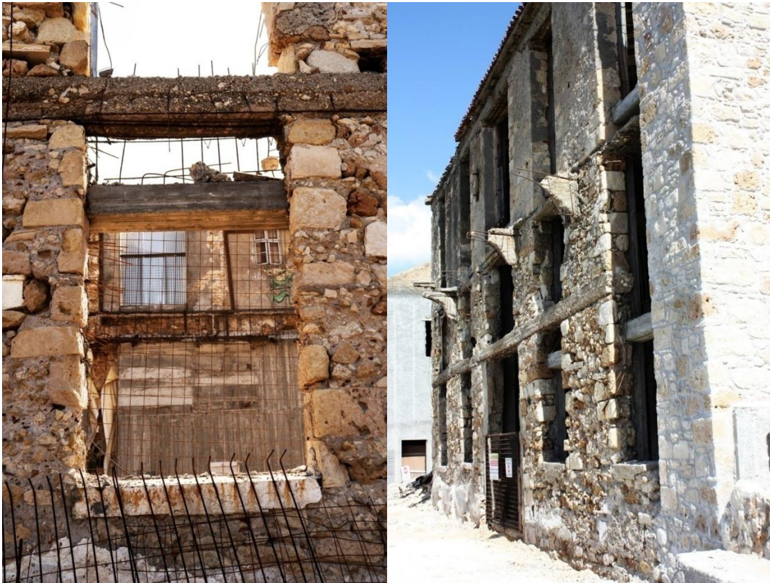
Εικόνα Β.25 Αρχιτεκτονικά Στοιχεία 4. Φωτογραφίες: Ομάδα Μελέτης.
