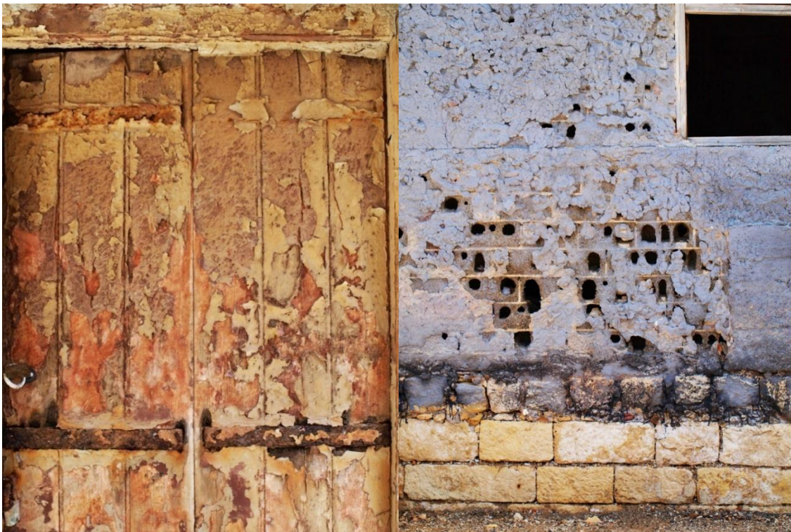
Εικόνα Β.21 Φθορές Ξύλου - Τσιμεντόλιθου. Φωτογραφίες: Ομάδα Μελέτης.
