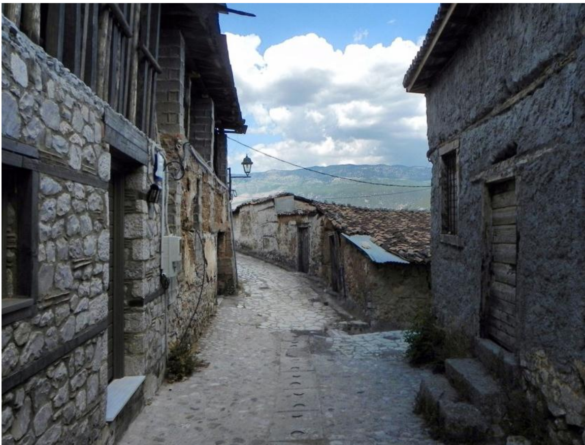
Εικόνα Α.51 Ταμπάκικα στη Χάρμαινα. Διακρίνεται η “ανοιχτή” νότια πλευρά του ορόφου.
