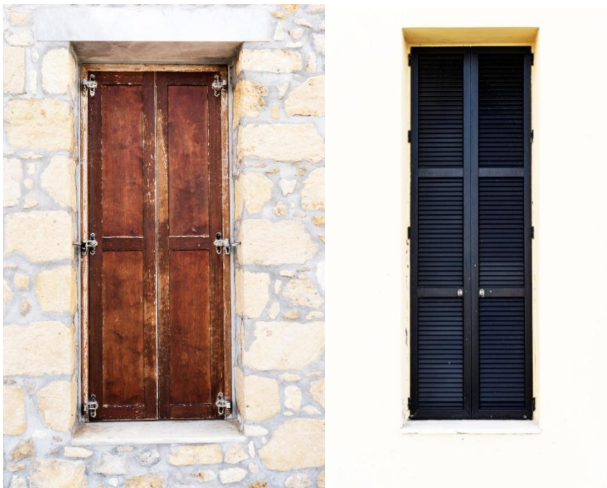
Εικόνα Β.11 Σύγκριση αποκατεστημένων και μη Αρχιτεκτονικών Στοιχείων (Κουφώματα). Φωτογραφίες: Ομάδα Μελέτης.
