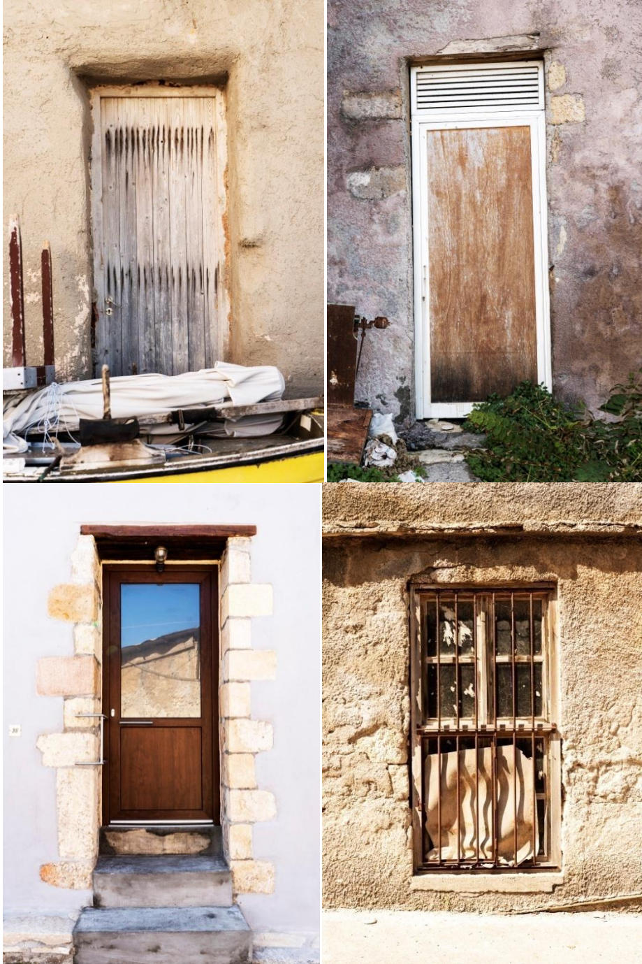
Εικόνα Β.10 Σύγκριση αποκατεστημένων και μη Αρχιτεκτονικών Στοιχείων (Κουφώματα). Φωτογραφίες: Ομάδα Μελέτης.
