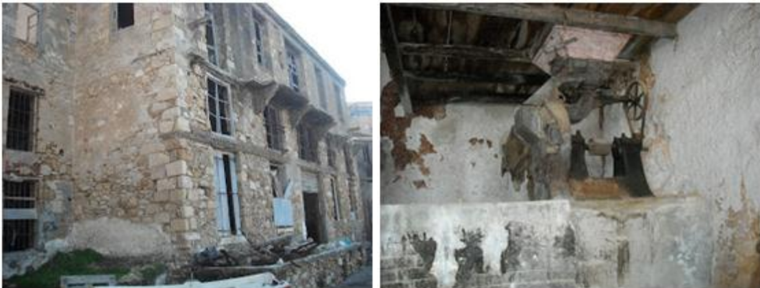
Εικόνα Β.18 Ταμπακαριό οδού Βιβιλάκη. Εμφανή τα υλικά κατασκευής. (Ρέλιας, 2013)
