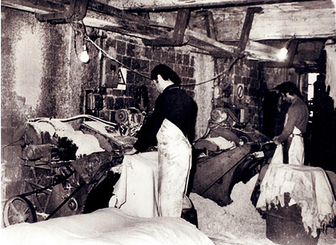
Εικόνα Α.13 Σκεφιστικές Μηχανές. https://karlovasi.wordpress.com/derma/katergasia/stadio1/ , Μουσείο Βυρσοδεψίας, Καρλόβασι, Σάμος.
