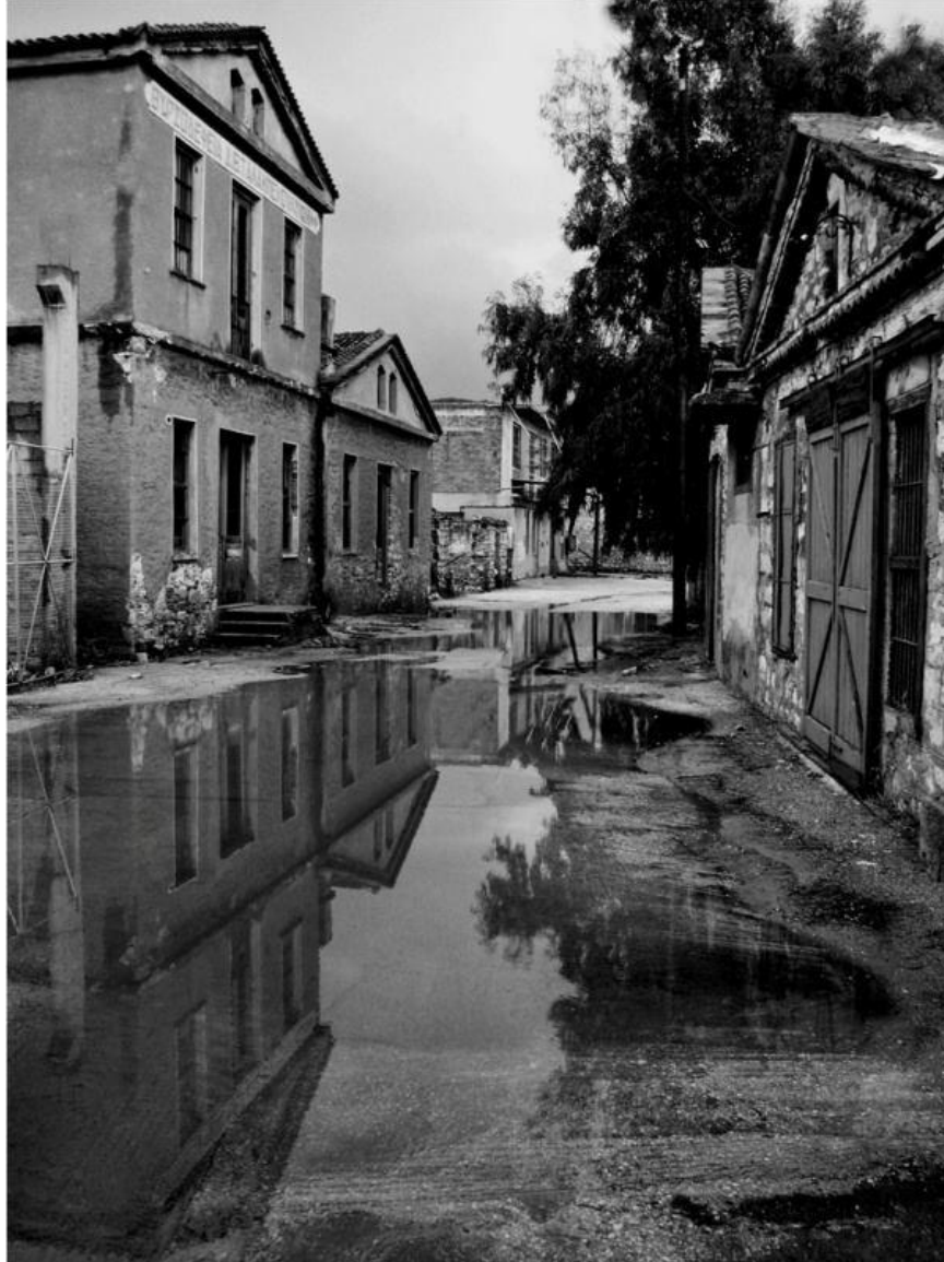
Εικόνα Α.61 Ερμούπολη. Εγκαταστάσεις Βυρσοδεψείων. https://cyclades24.gr/2016/02/birsodepsia-ermoupoli-afieroma/ , Η Βυρσοδεψεία στην Ερμούπολη. Παναγιώτης Κουλουμπής. Φεβρουάριος 2
