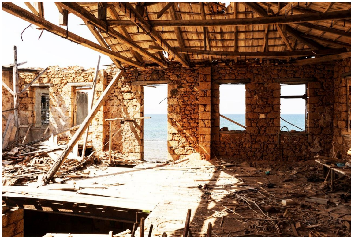
Εικόνα Β.17 Εσωτερικό Βυρσοδεψείου. Φωτογραφία: Ομάδα Μελέτης.
