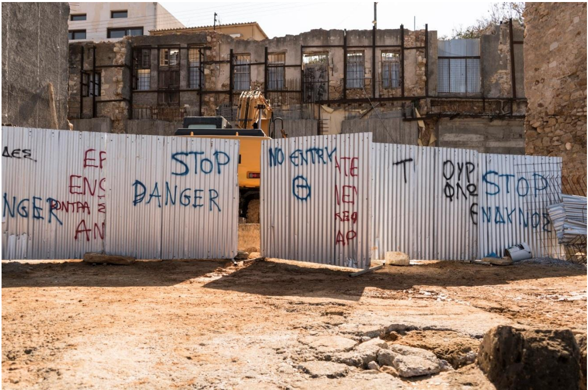
Εικόνα Β.4 Κτίριο υπό αποκατάσταση. Φωτογραφία: Ομάδα Μελέτης.
