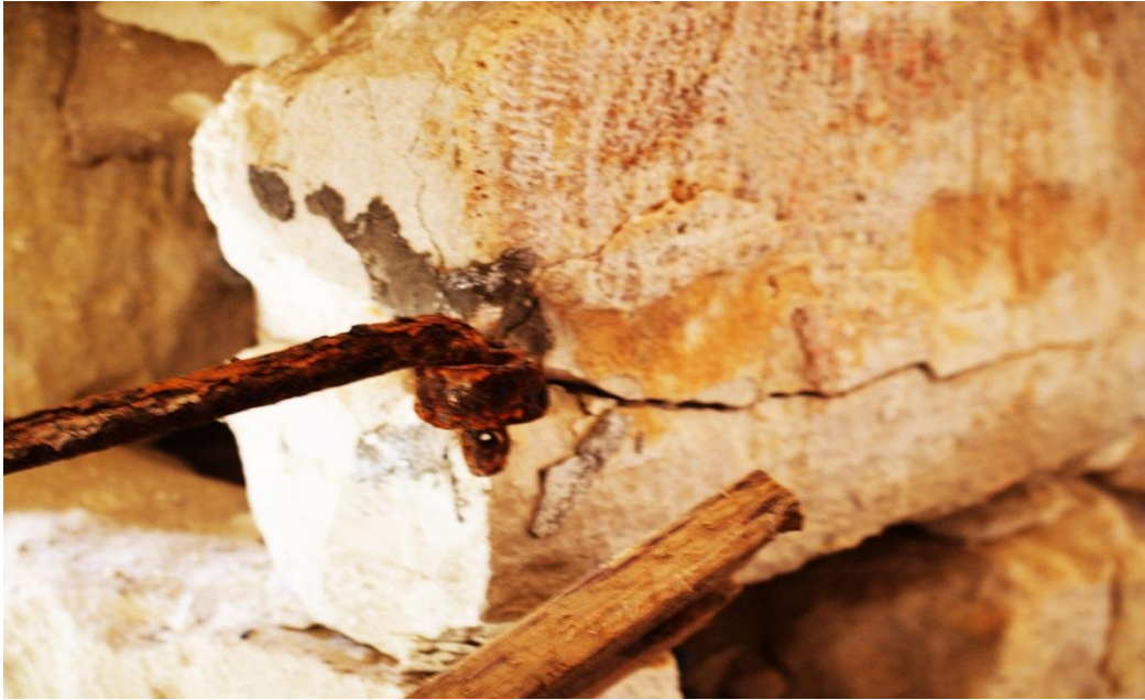
Εικόνα Β.20 Οξείδωση Μετάλλων. Φωτογραφίες: Ομάδα Μελέτης.
