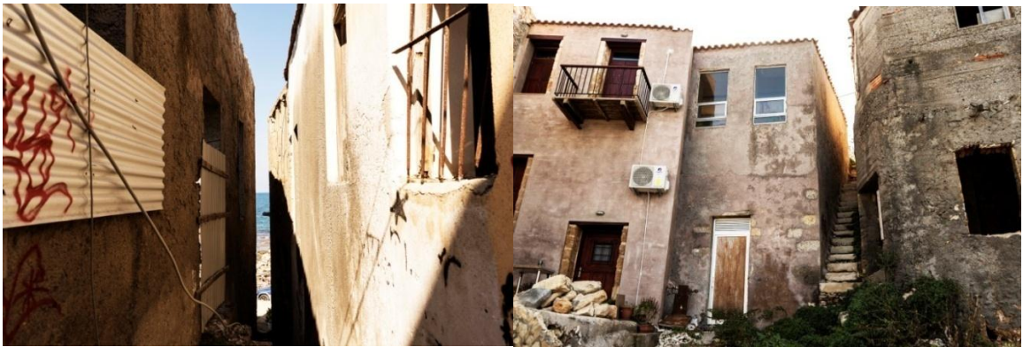
Εικόνα Β.23 Αρχιτεκτονικά Στοιχεία 2. Φωτογραφίες: Ομάδα Μελέτης.
