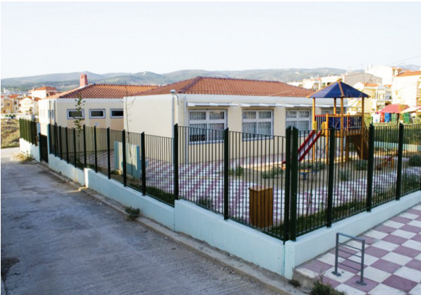
Νηπιαγωγείο Μαλακοπής Πυλαία Θεσ/νίκη
