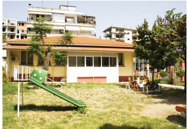
2ο Νηπιαγωγείο | Κιλκίς
