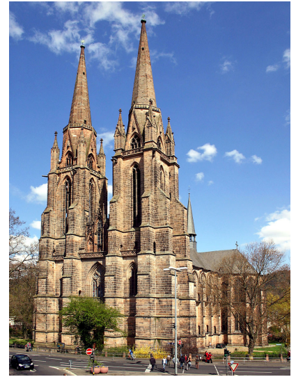
Εικόνα 81: Δυτική όψη του ναού της Αγίας Ελισάβετ στο Marburg
