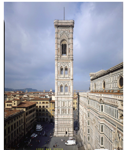
Εικόνα 159: Πύργος του κωδωνοστασίου της Santa Maria del Fiore
