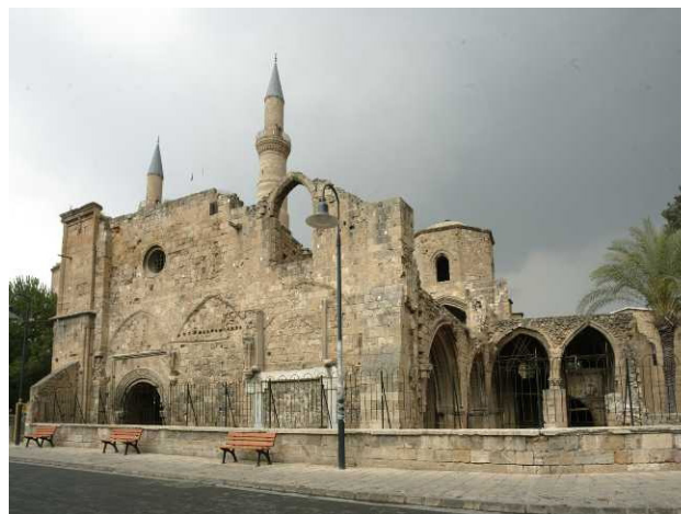
Εικόνα 182: Νοτιοδυτική άποψη του ναού του Αγίου Νικολάου
