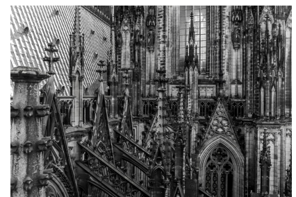
Εικόνα 211: Λεπτομέρεια ανοιγμάτων, επίστεγων αντηρίδων και κορυφωμάτων στον καθεδρικό ναό της Κολωνίας
