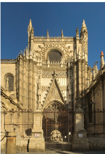
Εικόνα 114: Βόρεια όψη του καθεδρικού ναού της Σεβίλλης
