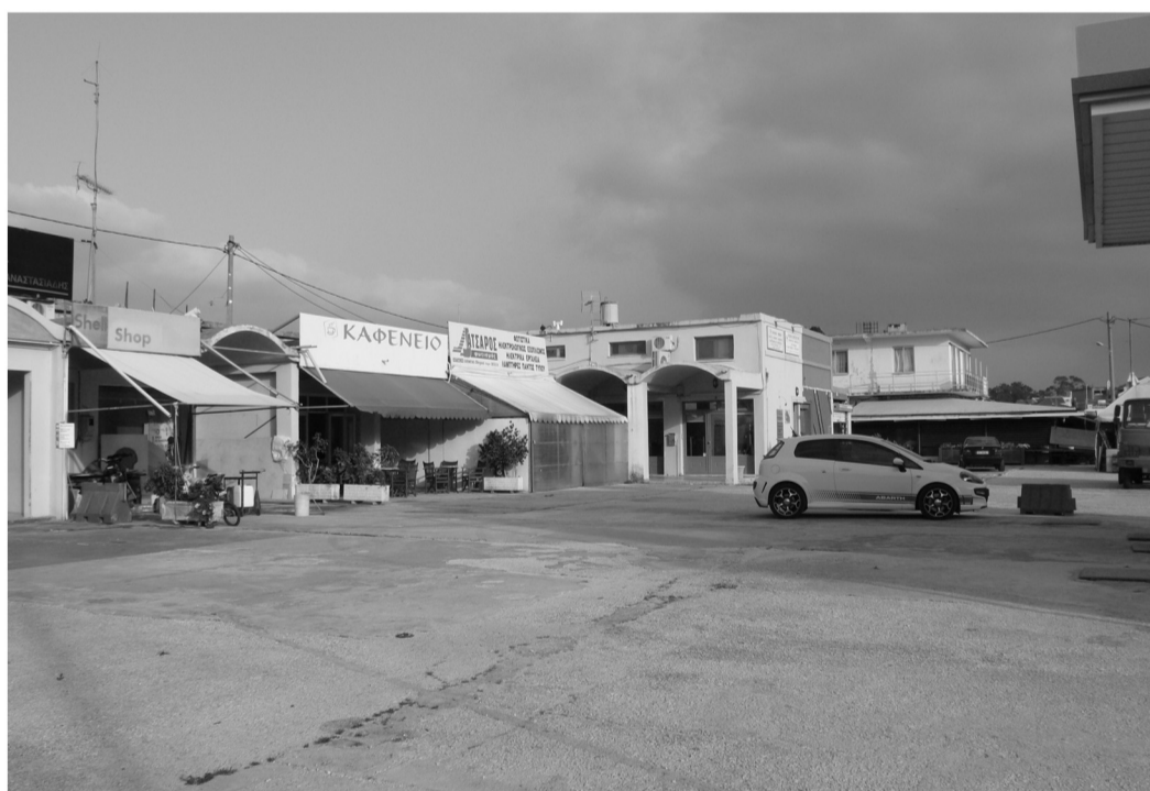
2017 | υποβάθμιση, καθίζηση, φθορές στα κτίρια λόγω σεισμού του 2014.
